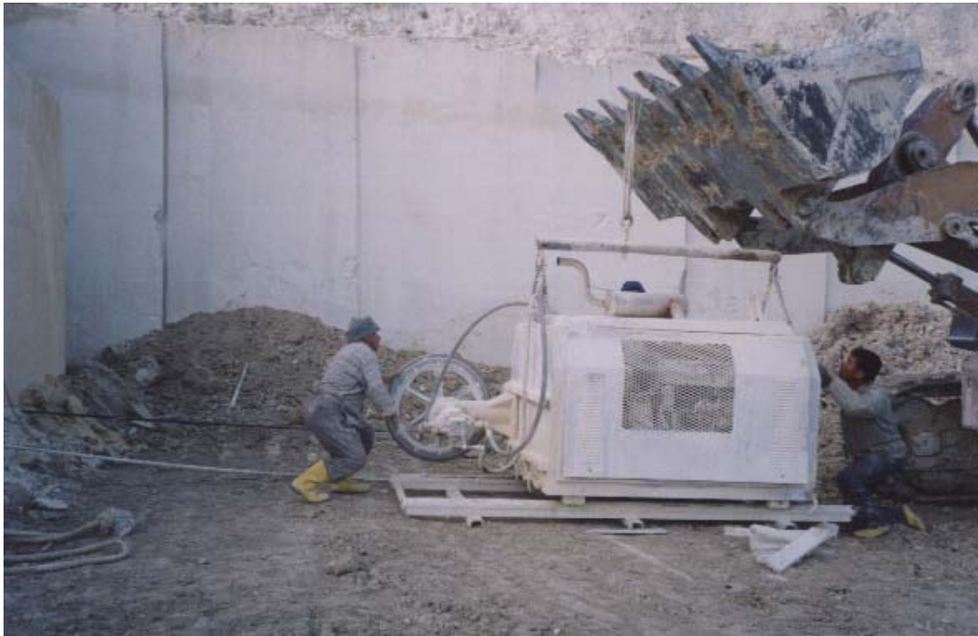
Resim 97, Elmas tel kesme makinesinin yerleştirilmesi
