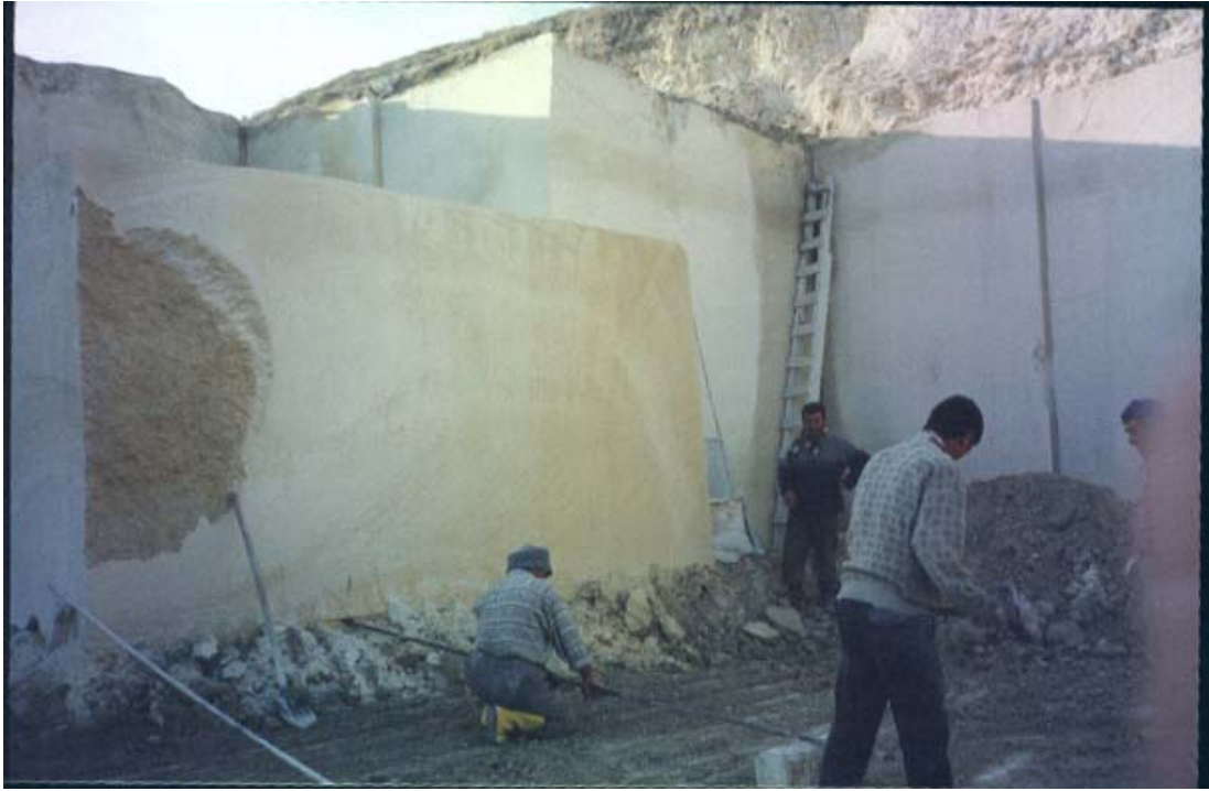
resim 102 ,Bloğun ayna yönünde molozların üzerine yıkılması
