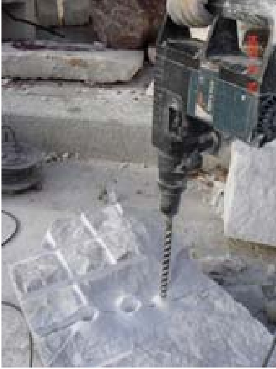
resim 125,Kamalama yöntemi ile taş bölme işlemi
