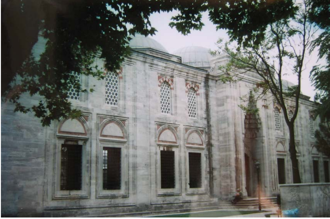
Resim 136: Şehzade Camii Kuzey Avlu Duvarı
