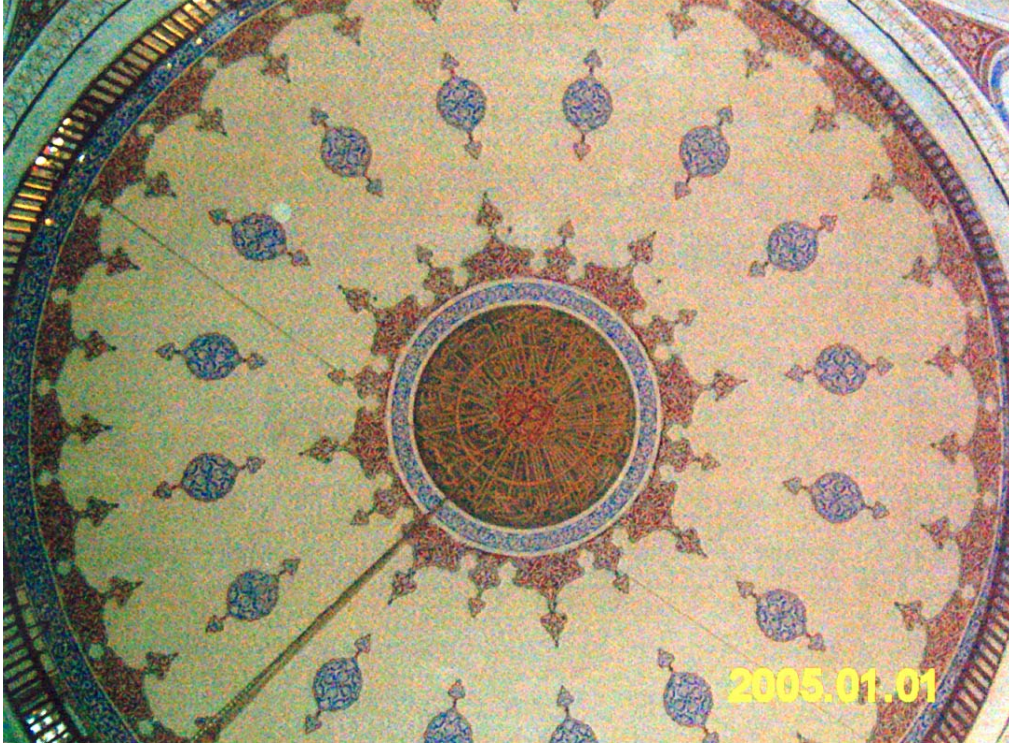
Resim 138: Hadım İbrahim Paşa Camii merkezi kubbe yüzeyi
