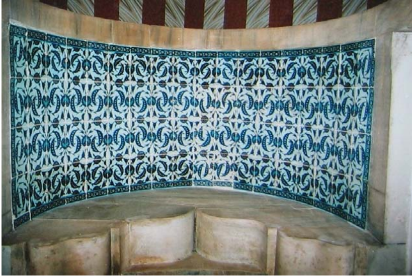
Resim 349: Ana Giriş Kapısı Eyvan tonozu
