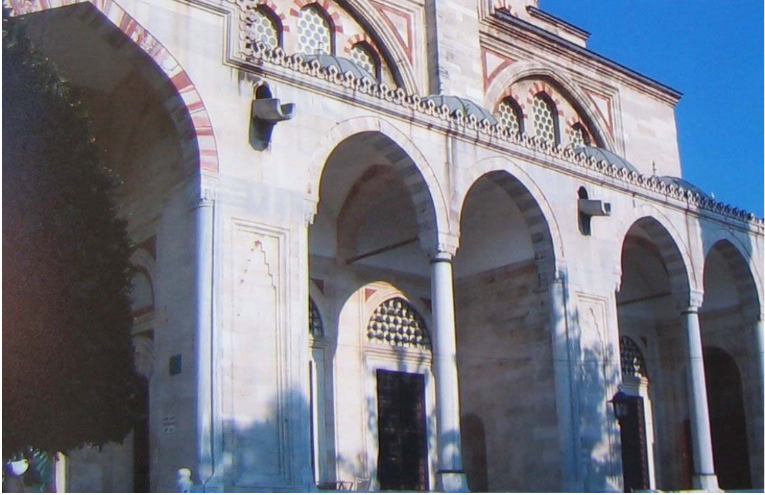
Resim 126: Batı Cephesi, dış galeri detay
