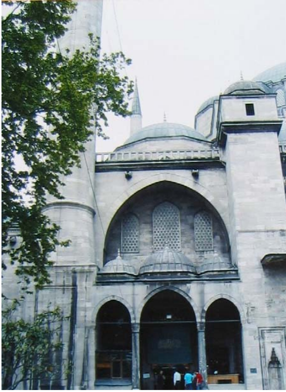
Resim 283: Batı Giriş Kapısı revakı
