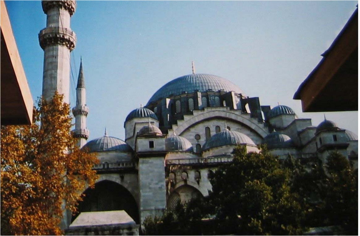
277: Süleymaniye Batı cephesi
