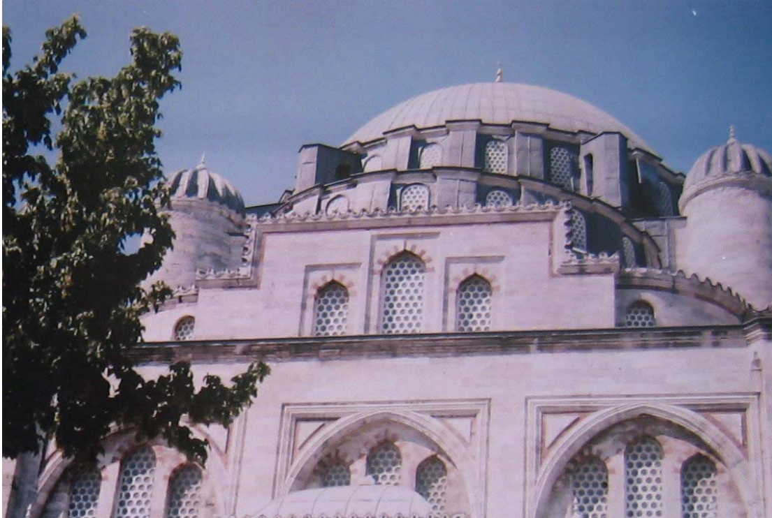
Resim 125: Şehzade Camii Batı cephesi, detay
