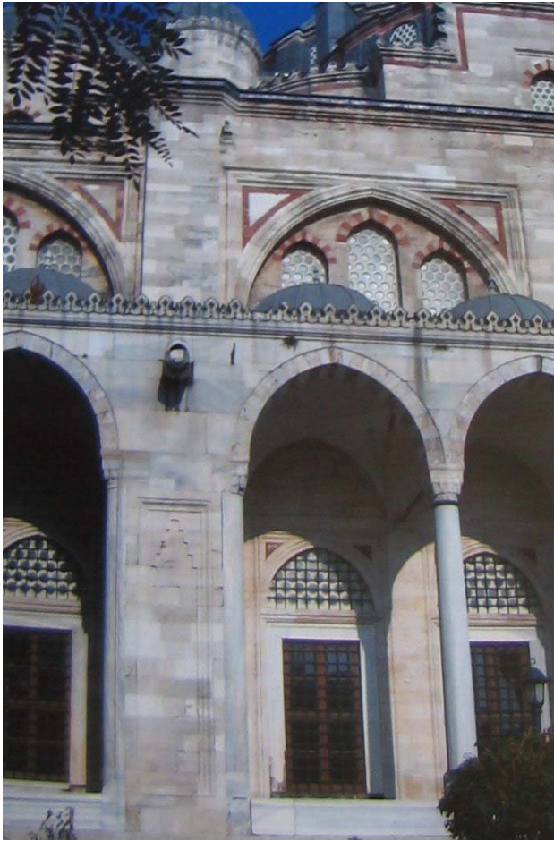
Resim 127: Batı cephesi, detay
