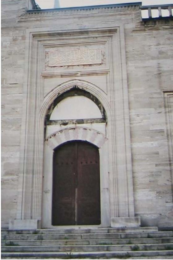
Resim 292: Doğu avlu kapısı
