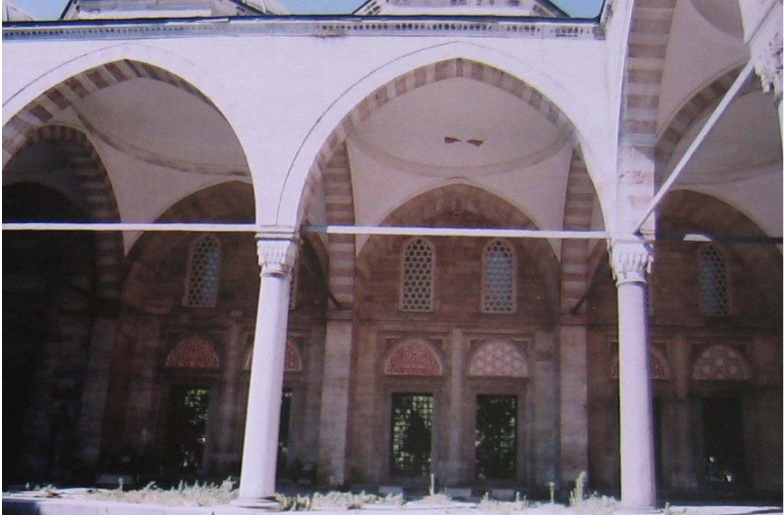
Resim 117: Şehzade Camii avlu revakı
