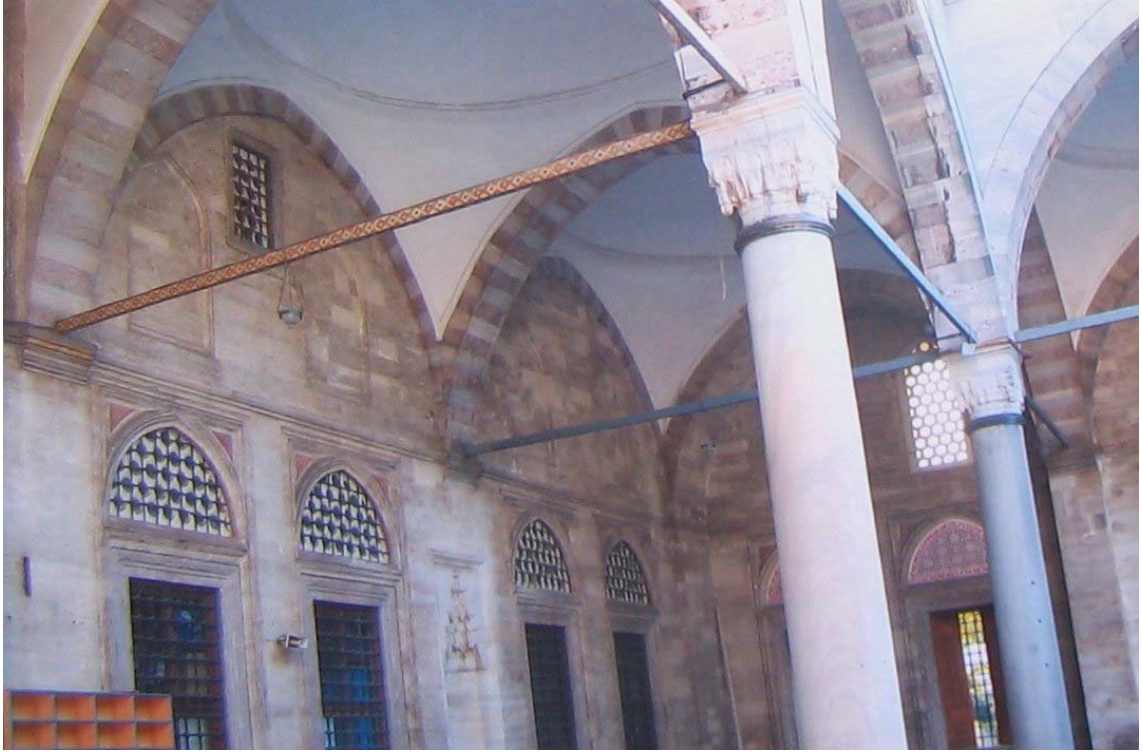
Resim 109. Son cemaat yeri duvarı sağ tarafı
