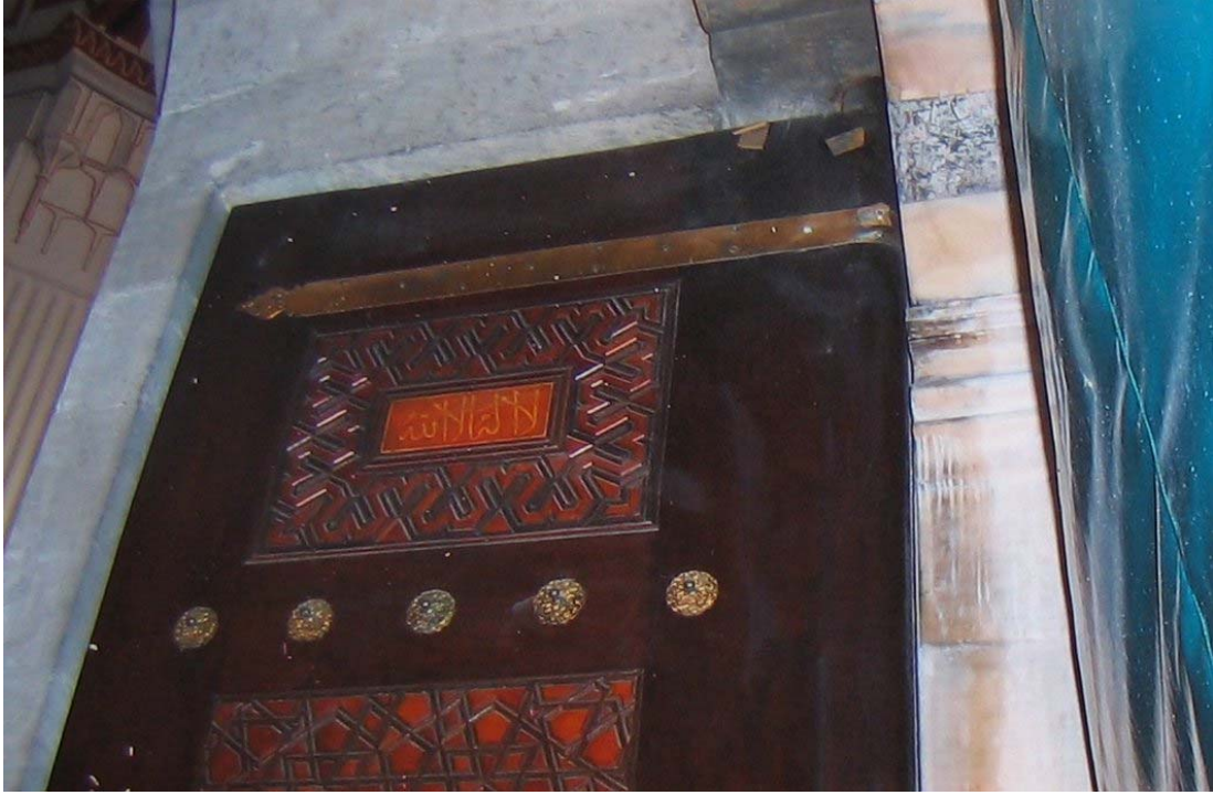
Resim 130: Batı Giriş Kapısı ahşap kanadı, üst tabla
