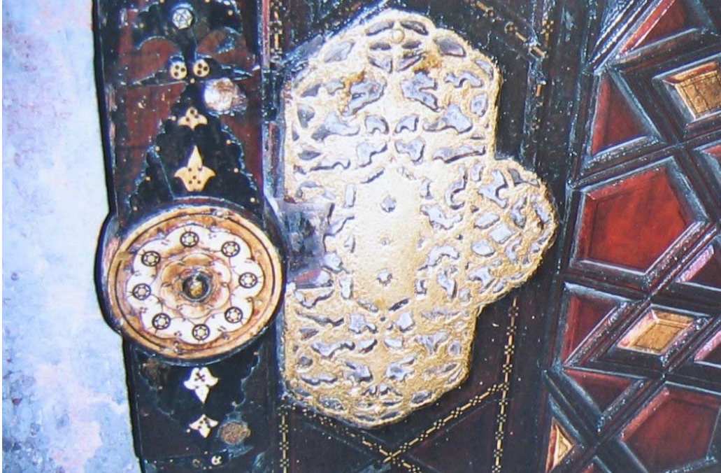
Resim 41. Üsküdar mihrimah sultan C. Ana giriş kapısı detayı
