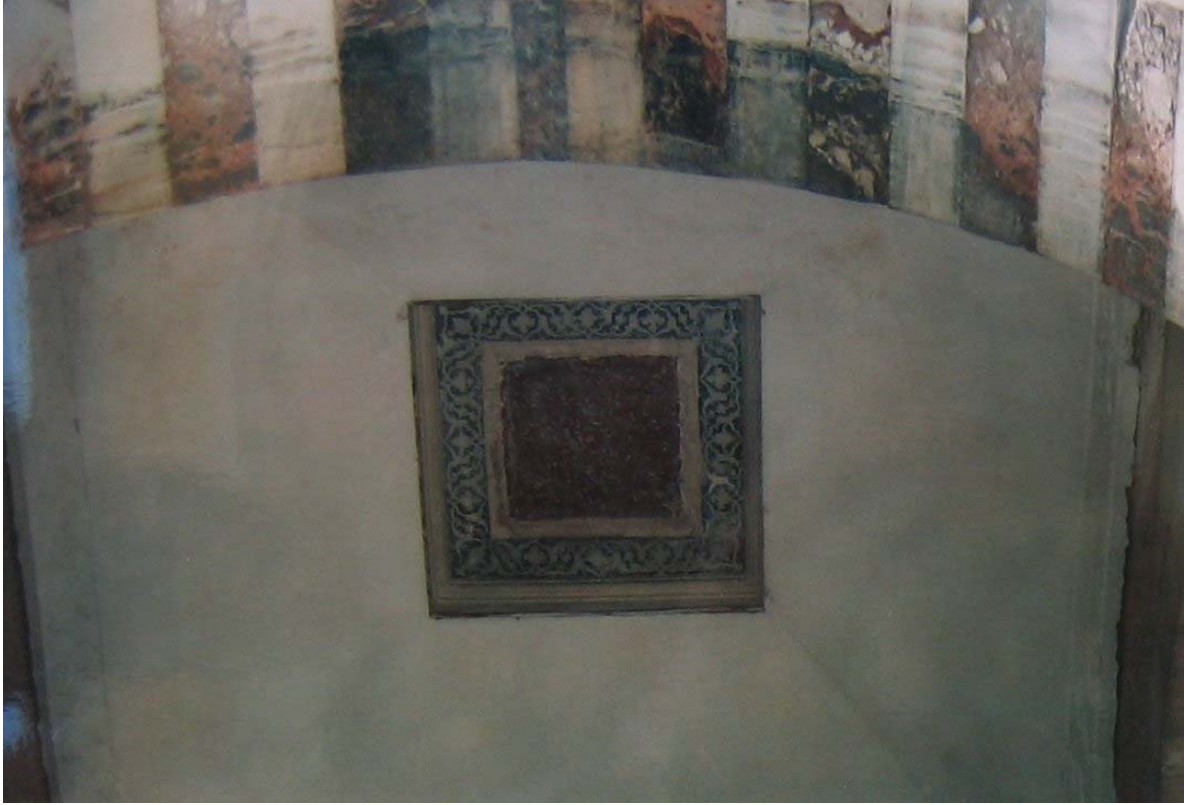
Resim 120: Şehzade Camii Doğu dış galerisi tavanı
