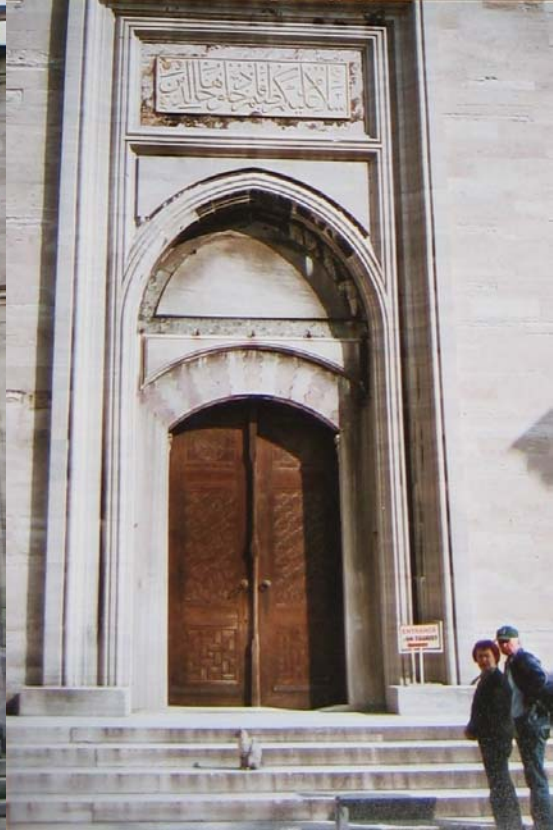
Resim 294: Batı Avlu Kapısı
