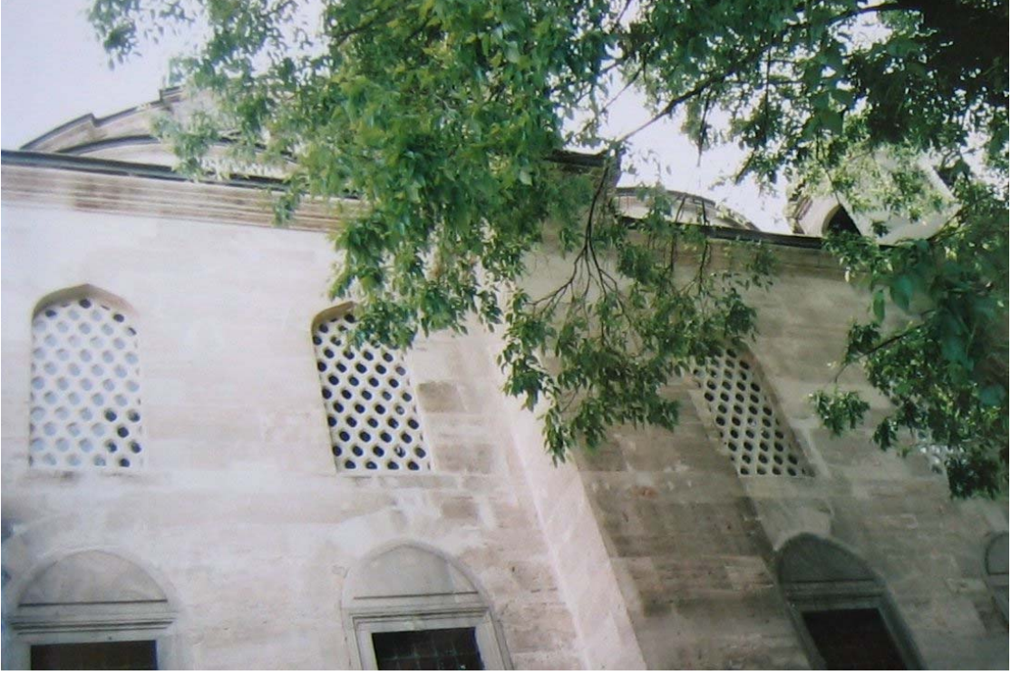
Resim 471: Dođu cephesi detay
