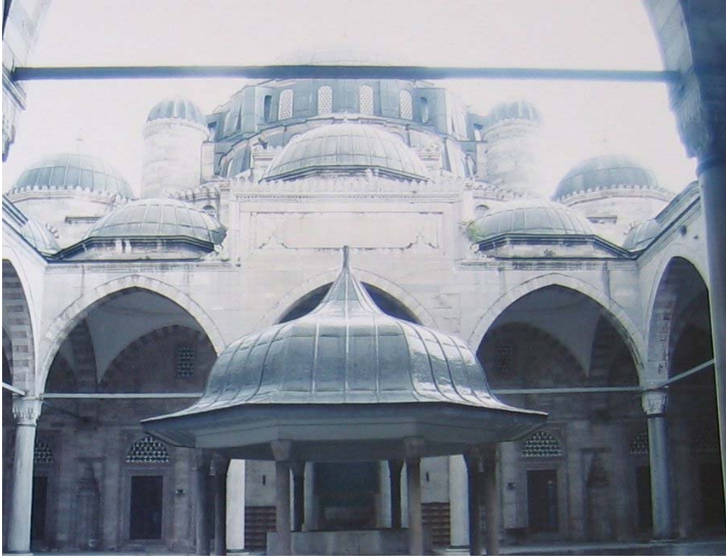
Resim 104: Şehzade Camii Kuzey duvarı genel görünüş
