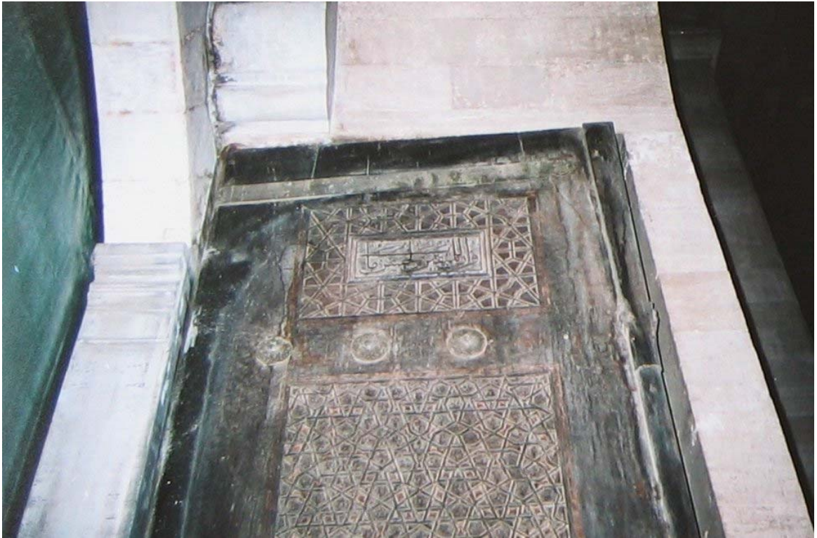
Resim 273: Doğu Giriş Kapısı ahşap kanadı, üst tabla
