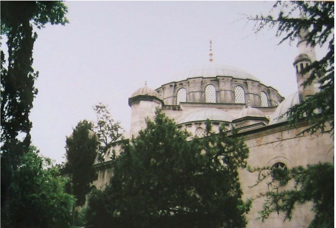
Resim 472: Kadırga Sokollu Batı Cephesi
