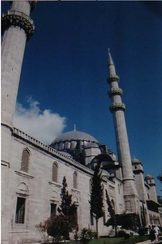
Resim 293: Batı Avlu duvarı
