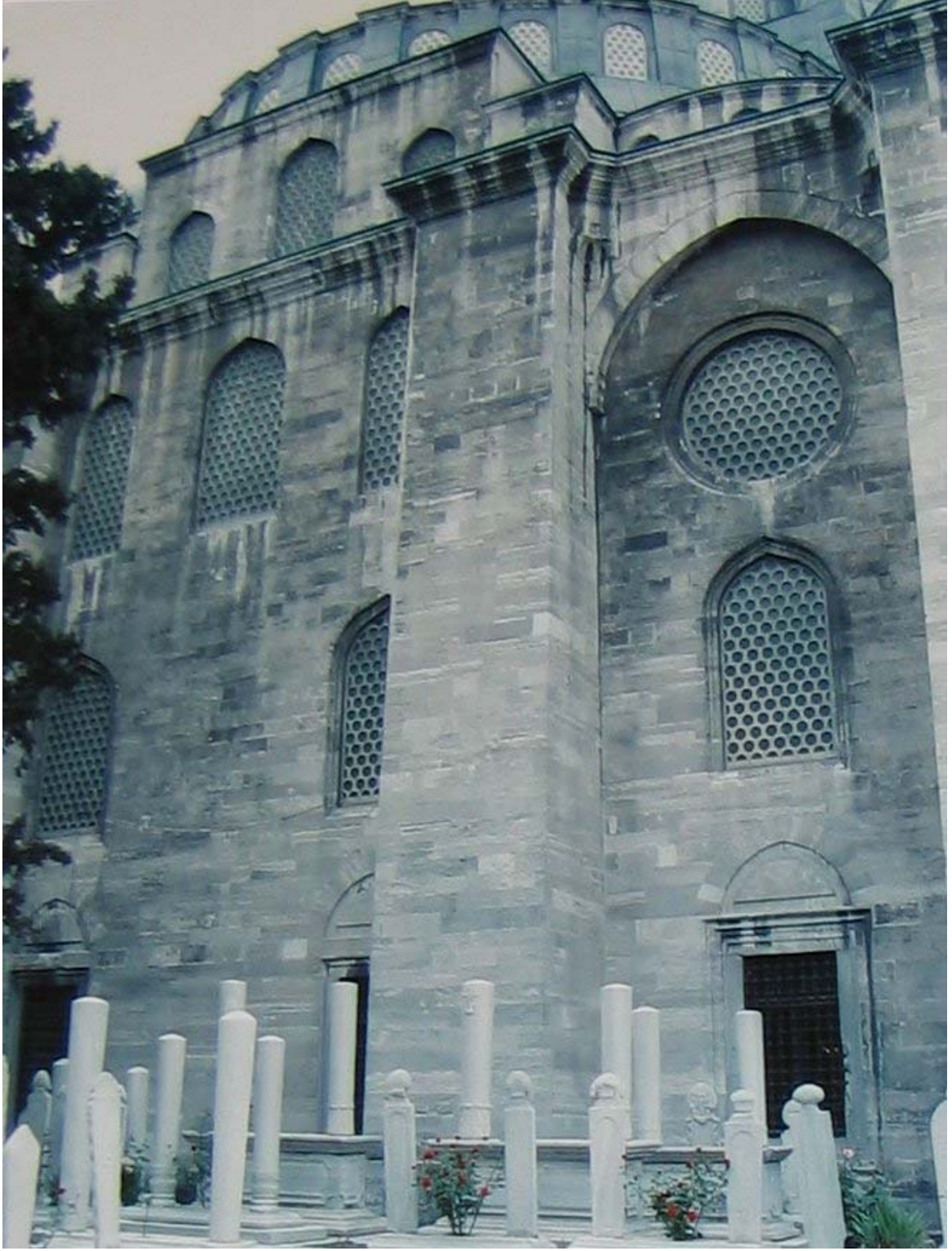
Resim 291: Süleymaniye güney (mihrap) cephesi
