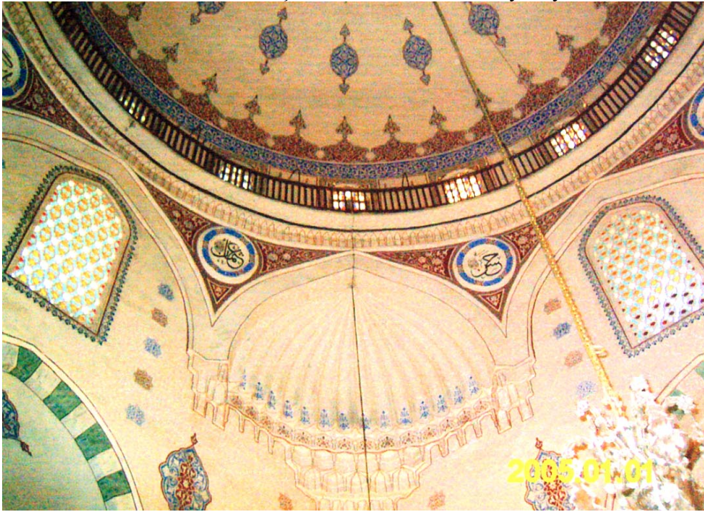
Resim 139: Hadım İbrahim Paşa Camii merkezi kubbeyi taşıyan tromp
