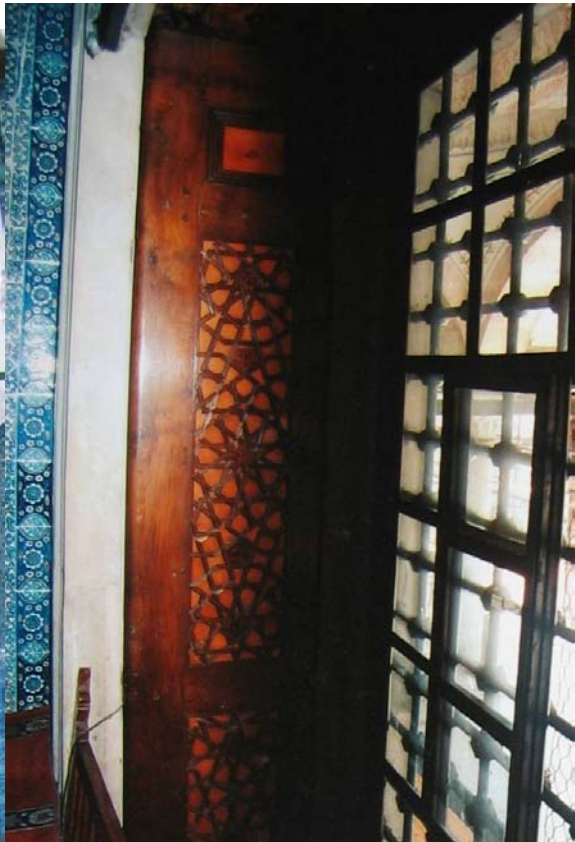
Resim 347: Kuzey duvarı pencere kanadı
