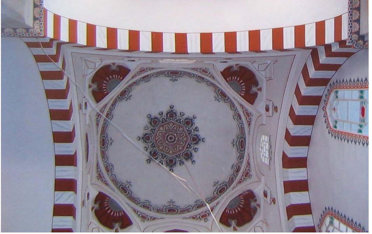
Resim 61: Şehzade Camii kuzeybatı köşe kubbesi
