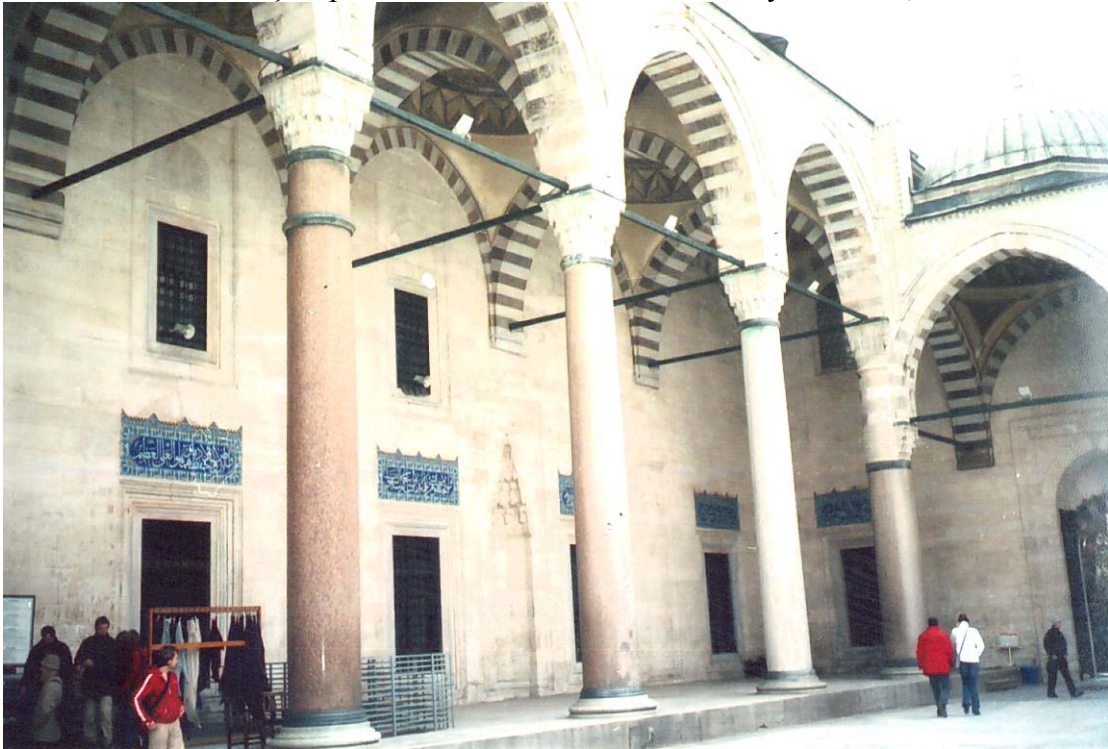
Resim 249: Ana Giriş Kapısının sağ tarafındaki son cemaat yeri duvarı
