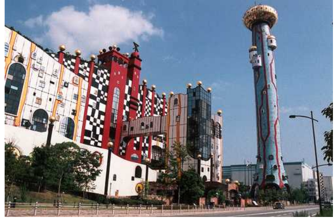
Resim 5.54 Maishima Çöp Yakma Tesisi (Sayfa: 131, 132)
