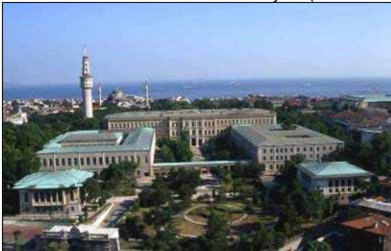
Resim 56. Kışla ve hastane binasının son durumu (2004).
