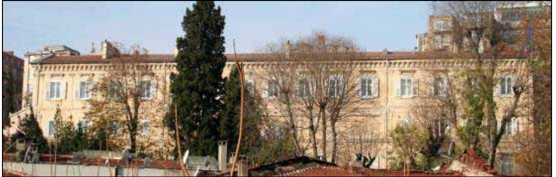
Resim 103. Saray'ın doğu cephesi (2006).
