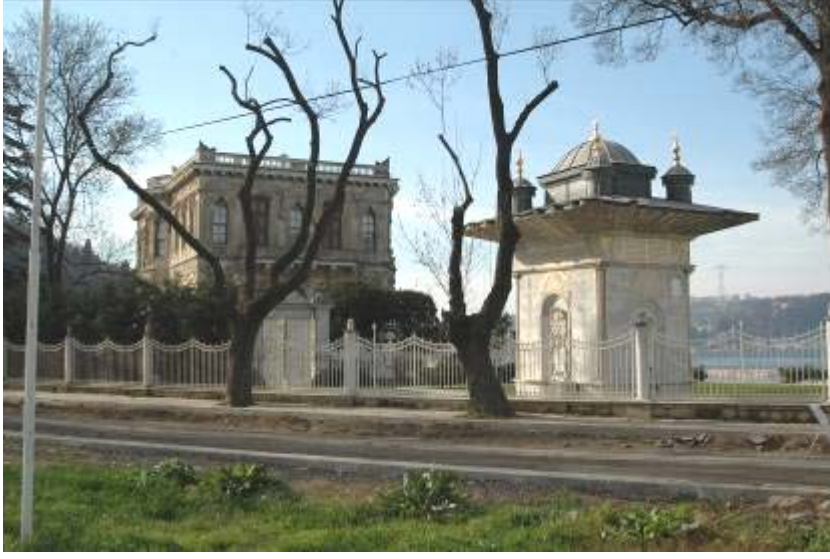
Foto.263- Küçük Kasrı ve Küçük Meydan Çeşmesi, 17 Aralık 2006
