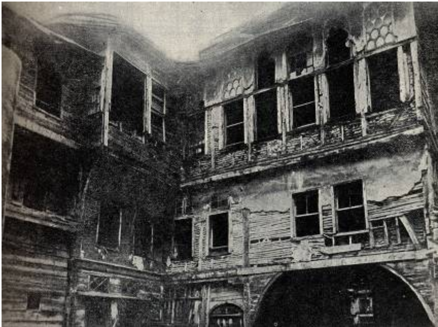
Foto.385- Bayezid Meşruta Köşkü avludan görünüş. (Köşkler ve Kasırlar II, 105)
