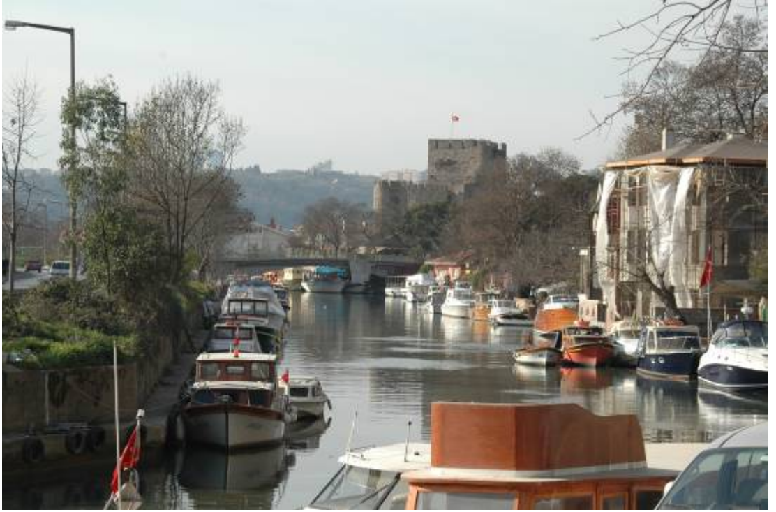
Foto.327- Göksu Deresi, köprü ve hisar, 17 Aralık 2006
