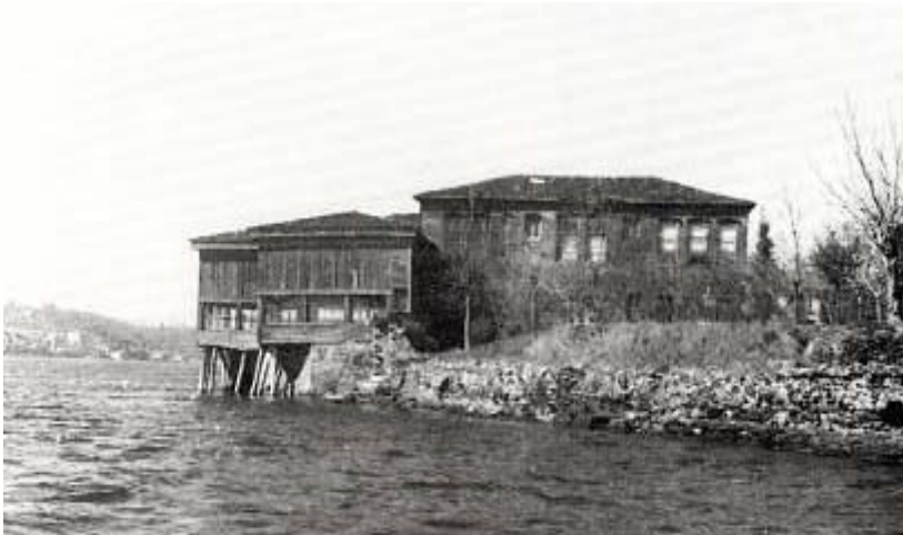
Foto.244- Amcazade Hüseyin Paşa Yalısı'nın Selamlık Köşkü, 1947. (Amcazâde Yalısı ve Manzumesi Onarımları, 36, foto.5)
