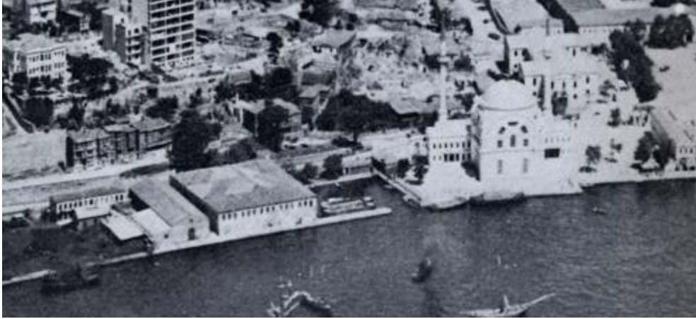
Foto.59- 6.6.1923, saat 11.30. İngiliz işgal kuvvetlerinin şehri boşaltmasından az önce uçaktan aldırıldığı seri fotoğraflardan birinden ayrıntı. Dolmabahçe Camisi ve Hamlehâne Binası. (Dolmabahçe Çağlar Boyu İstanbul Görünümleri III, 10'dan ayrıntı)
