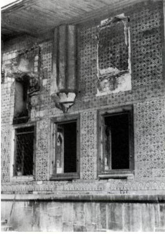
Foto.183- Onarımlar sırasında ekler söküldükten sonra üst katta ortaya çıkan üç pencere. (Topkapı Saray'ında Padişah Evi (Harem), 64)
