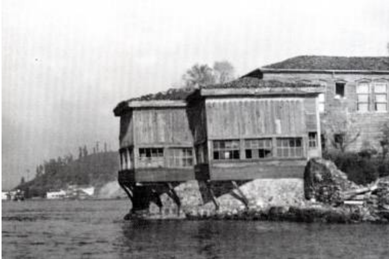
Foto.245- Amcazade Hüseyin Paşa Yalısı'nın Selamlık Köşkü, 1947. (Amcazâde Yalısı ve Manzumesi Onarımları, 37, foto.8)
