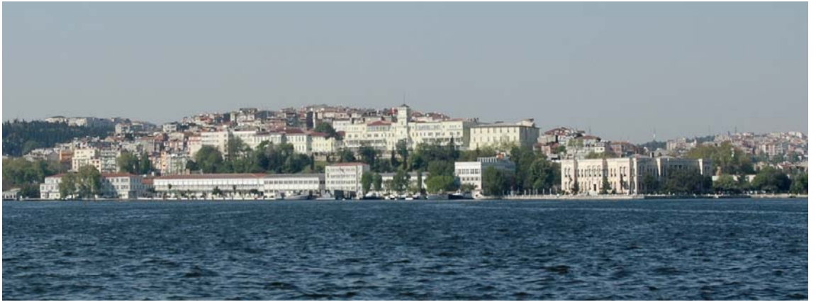
Foto.376- Kuzey Deniz Saha Komutanlığı Karargâh Binası olarak kullanılan beşinci Divanhane Binası, Deniz Hastanesi ve çevresi, Nisan 2006
