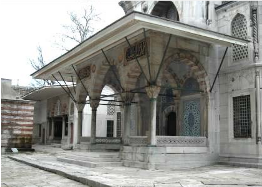
Foto.129- Ayasofya, Sultan II. Selim Türbesi ve Sultan III. Mehmed Türbesi Mart 2006
