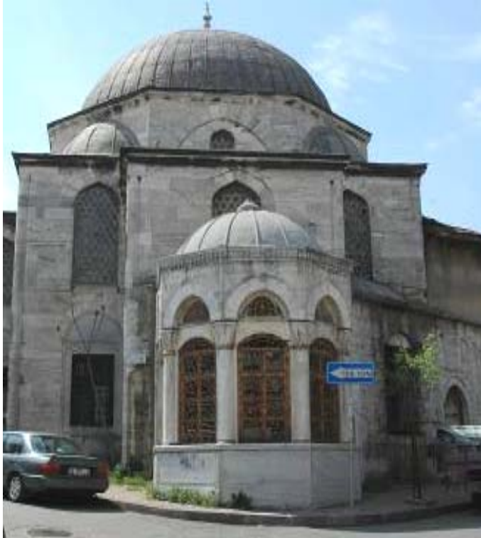
Foto.276- Bayram Paşa Sebili ve türbesi, Nisan 2006
