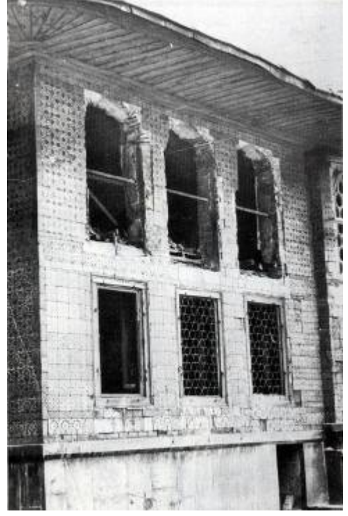
Foto.184- Onarımlar sırasında üst kattaki dikdörtgen pencere açıklıklarının üst kısmı söküldükten sonra ortaya çıkan kemerler. (Topkapı Saray'ında Padişah Evi (Harem), 65)
