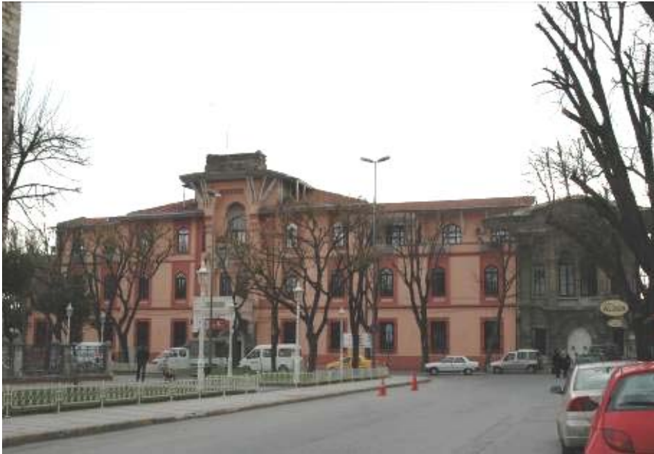
Foto.406- Marmara Üniversitesi Rektörlük Binası ve Yeniçeri Müzesi olarak inşa edilen yapı, 23 Ocak 2007
