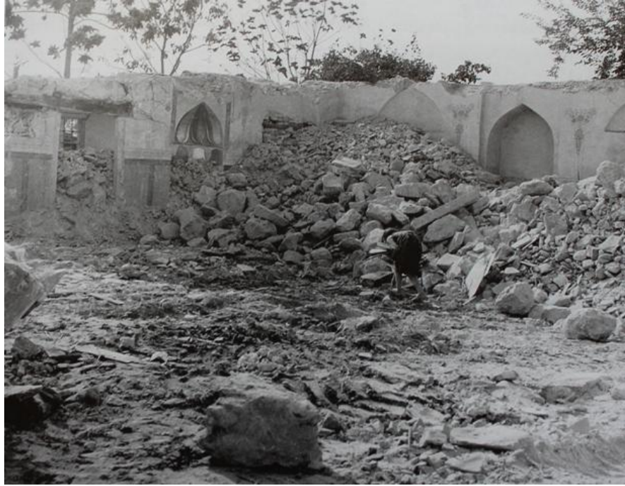
Resim 167- Hacı Taceddin Mescidi, yıkıldıktan sonraki durumu
