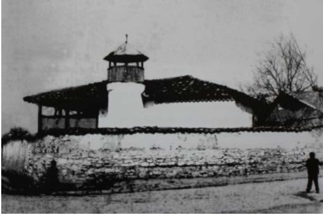
Resim 70- Kapıcı Hamza Camii'nin depremden önceki durumu
