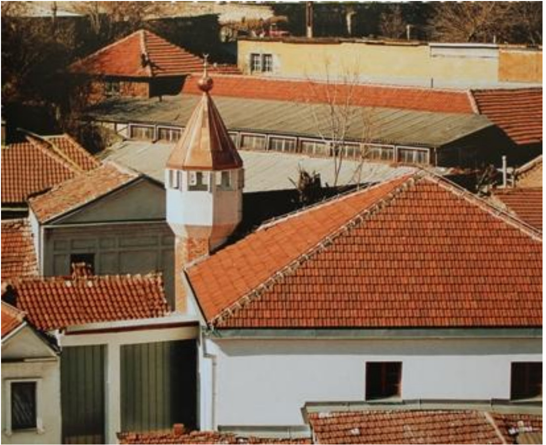
Resim 179- Köse Kadı Camii'nin yapılan onarımdan sonraki durumu
