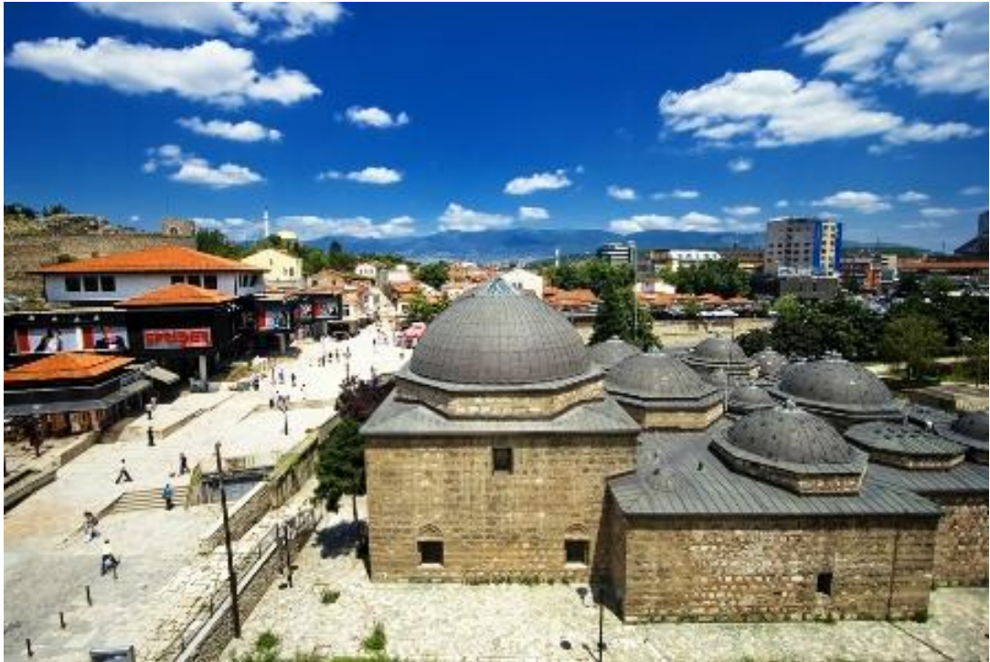
Resim 84 - Davut Paşa Hamamı güney cephesi
