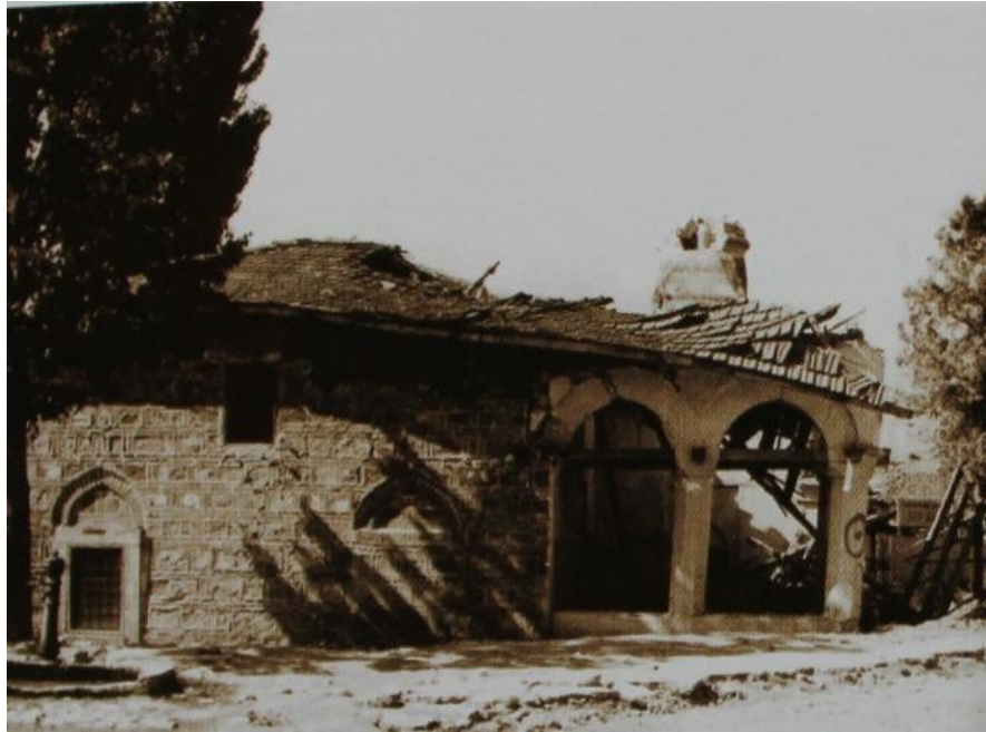
Resim 103 - Hacı Kasım Camii - depremden sonraki durumu
