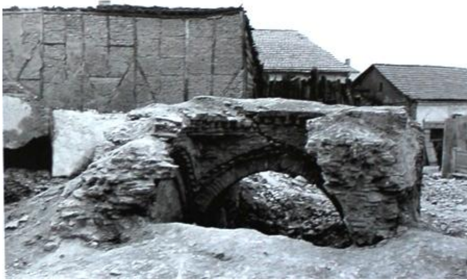
Resim 111- Günümüzde mevcut olmayan İshak Bey Çifte Hamamı'na ait kalıntılar
