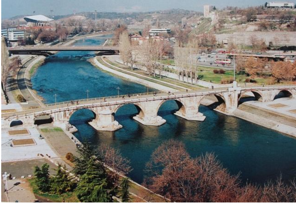
Resim 97 - Taş Köprü, yapılan son restorasyon çalışmalarından önceki durumu
