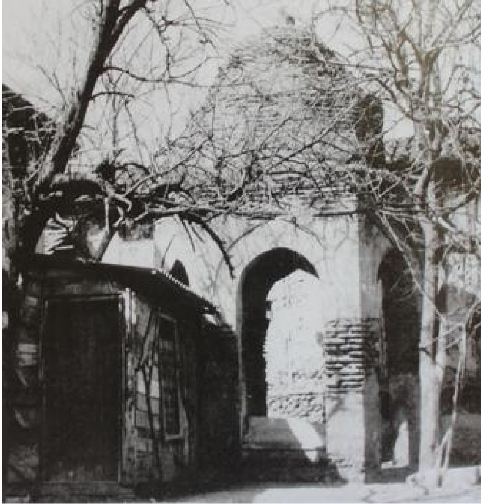
Resim 108- Paşa Yiğit Bey Türbesi'nin depremden önceki durumu
