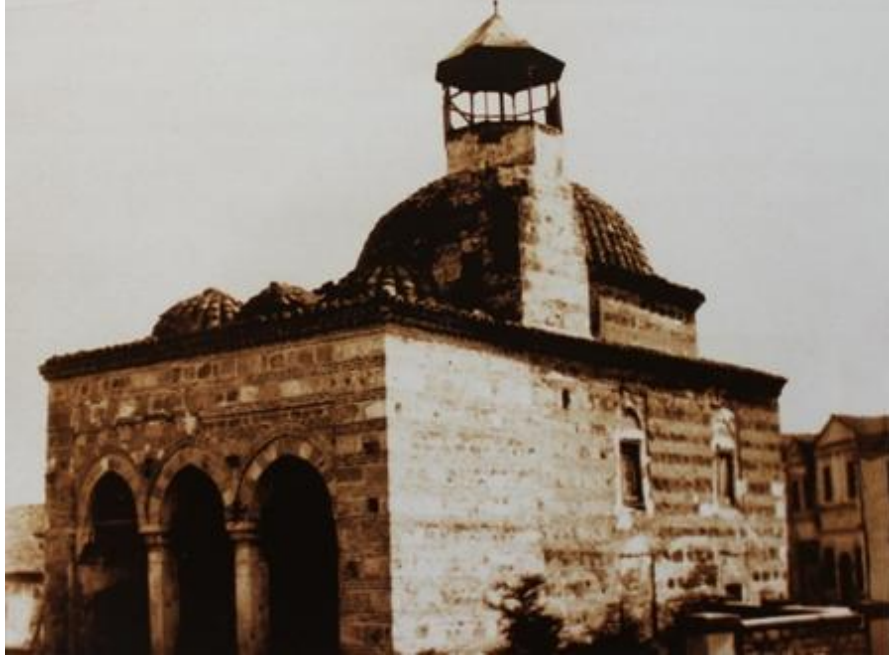
Resim 162 - Kazancılar Camii'nin depremden önceki durumu
