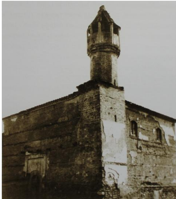
Resim 59 - Arasta Cami'nin 1963 depreminden önceki durumu
