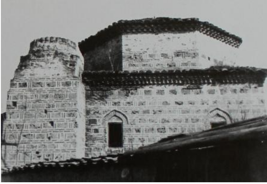
Resim 143 - Hüda-verdi Mescidi'nin depremden önceki durumu
