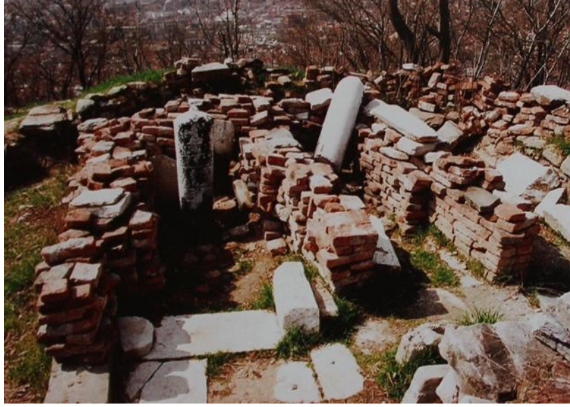
Resim 146- Âşık Çelebi Türbesi'nin günümüzdeki durumu
