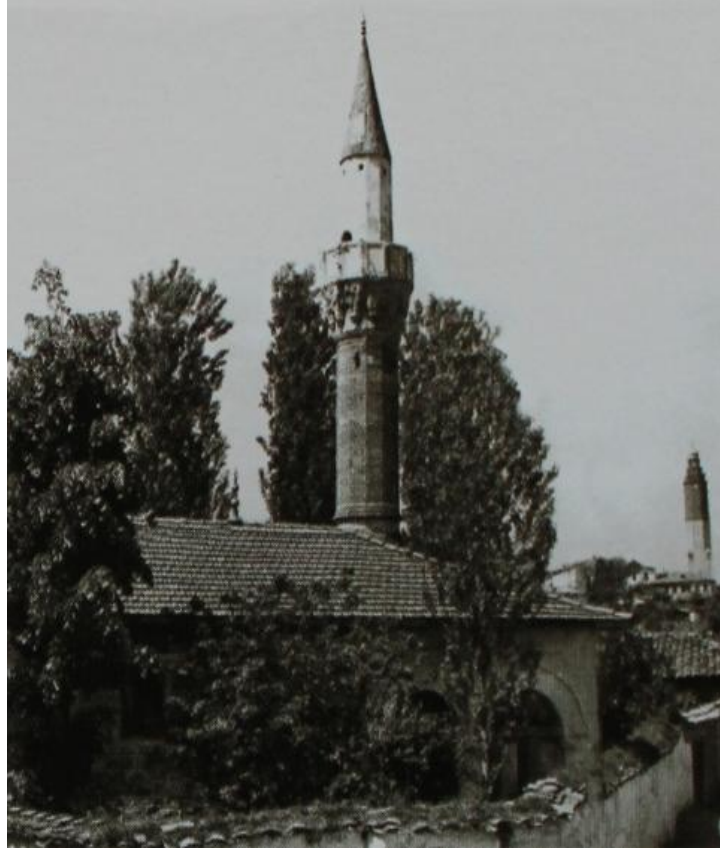
Resim 102 - Hacı Kasım Camii - depremden önceki durumu
