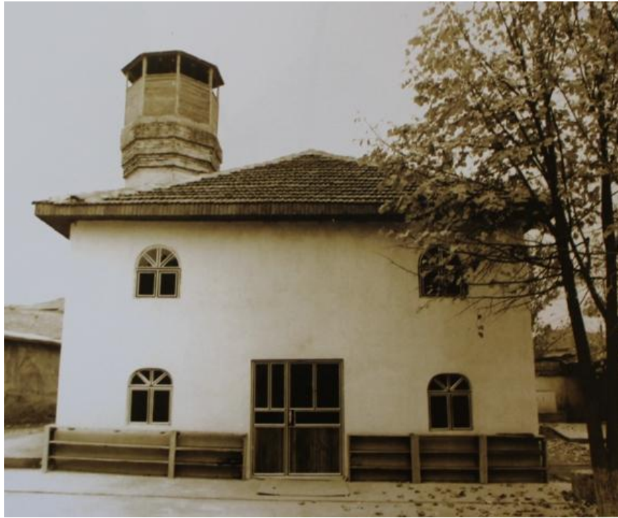
Resim 130- Hacı Kâzım Camii bugünkü durumu
