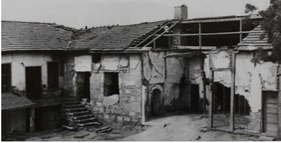
Resim 110- Sultan Murat Camii Medresesi
