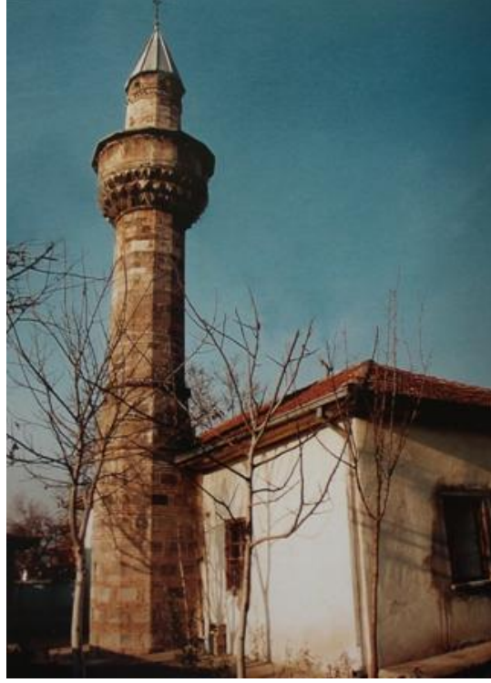
Resim 136- Tütünsüz Camii'nin bugünkü durumu
