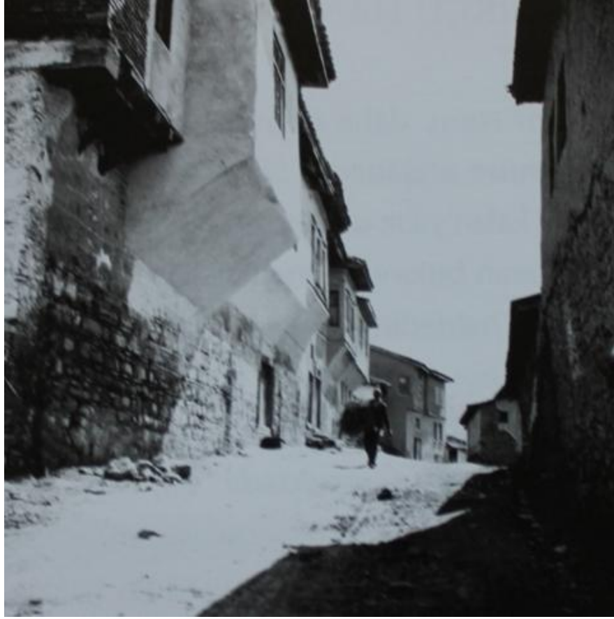
Resim 114- Kapıcıbaşı Sinan Kervansarayı'nın kalıntıları üzerine inşa edilmiş konutların depremden önceki durumu
