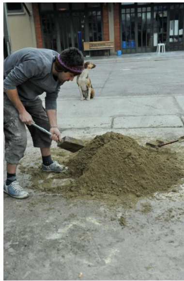
Resim 6.7. Kum, Su ve Bentonitin Kürek Yardımıyla Karıştırılması
