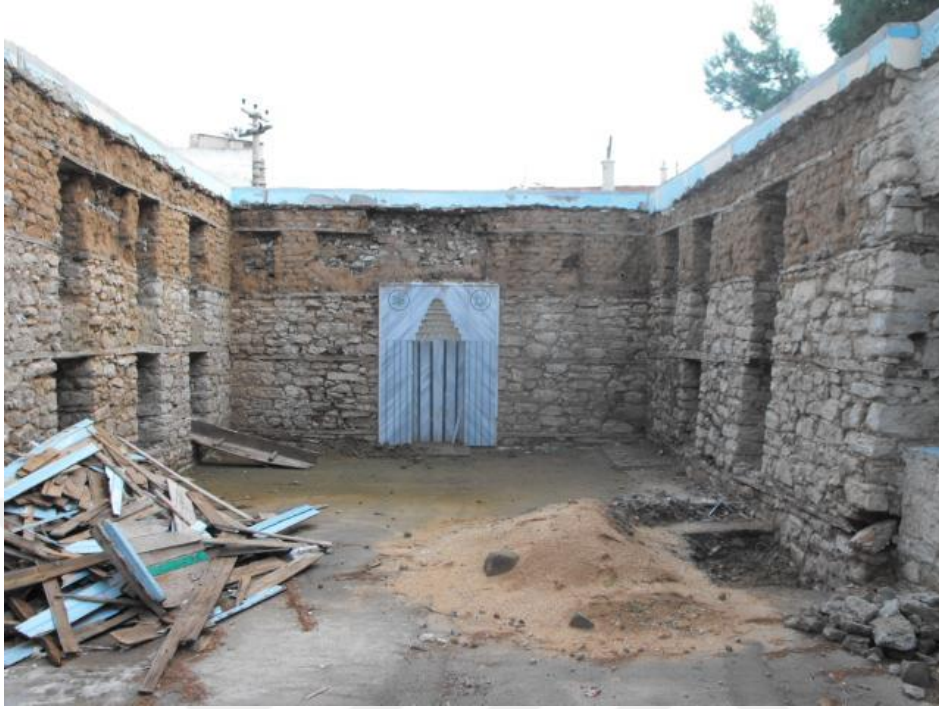
Fotoğraf 3.1.1.2.5. Habib Hoca Camii, Restorasyon Aşamasında İç Mekandan Görünüş, 2014
