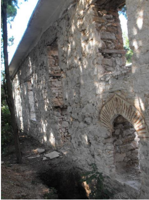
Fotoğraf 3.1.1.2.3. Habib Hoca Camii, Batı Cephesi, 2014
