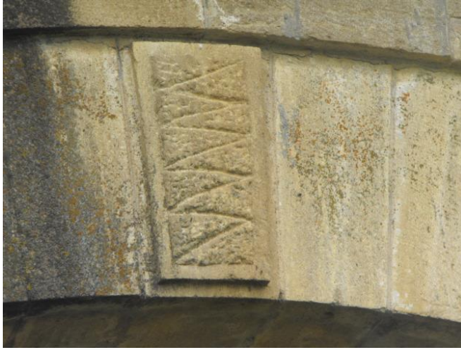
Fotoğraf 3.2.3.1.25. Mamba Yönü 108. Kemer Kilit Taşı Yüzeyindeki Geometrik Süsleme, 2014
