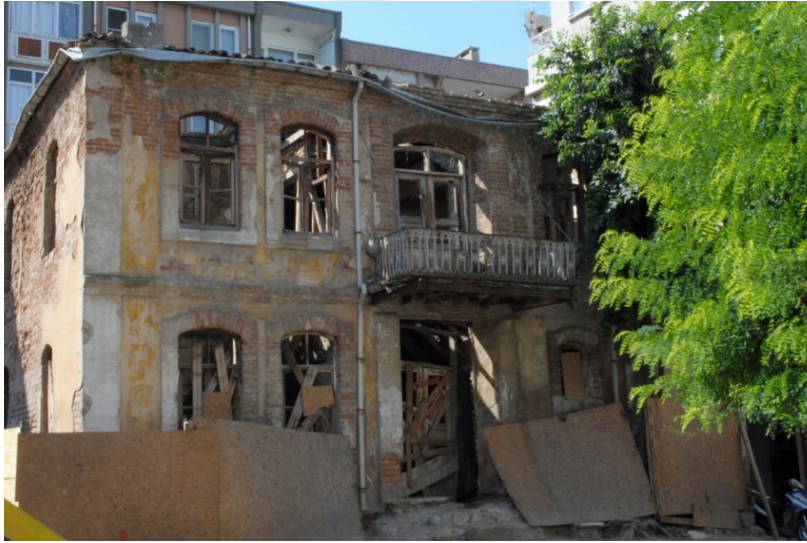
Fotoğraf 3.3.4.2. Eski Tekel Binası Restorasyon Öncesi Arka Cephe, (Kaynak; Belediye Arşivi 2012)
