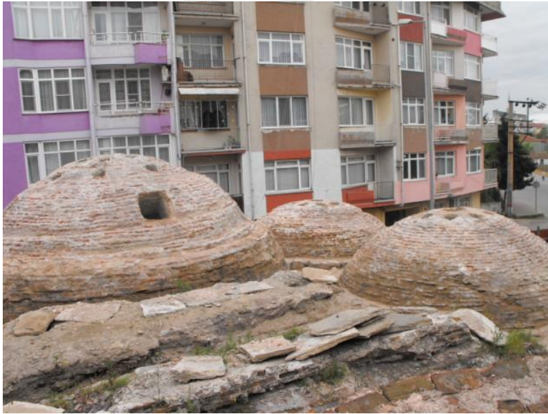
Fotoğraf 3.2.1.1.4. Uzunköprü Hamamı, Erkekler Bölümünün Sıcaklık ve Halvet birimleri, 2014
