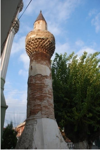
Fotoğraf 3.1.1.5.2. Şehsuvar Bey Camii Minaresi Restorasyon Öncesi, 2013.
