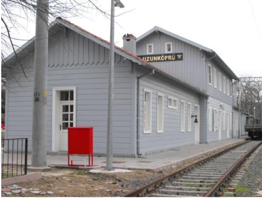
Fotoğraf 3.3.2.1. İstasyon Binası A Bloğu, 2014
