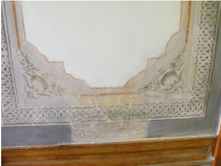
Fotoğraf 3.3.3.10. Halk Kütüphanesi Birinci Kat Güneydoğu Cephesine Açılan Holün Duvar Süslemesi, 2014
