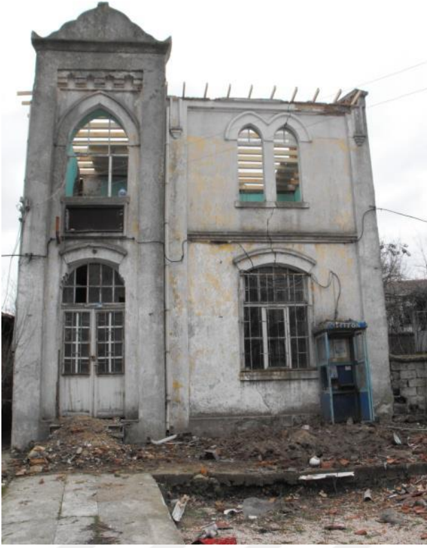
Fotoğraf 3.3.1.1. Ptt Binası, Güneydoğu Cephesi , 2014
