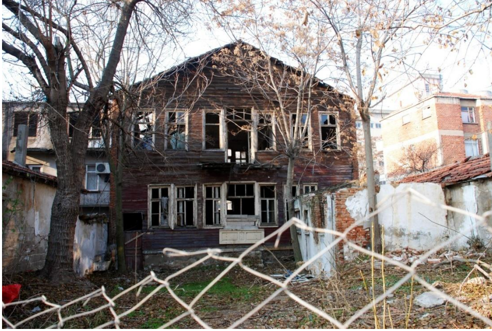
Fotoğraf 3.4.2.2. Eski Askerlik Şubesi Binası Bahçeye Açılan Cephe, (Kaynak: Ali Çıtak'ın izniyle alınmıştır.)
