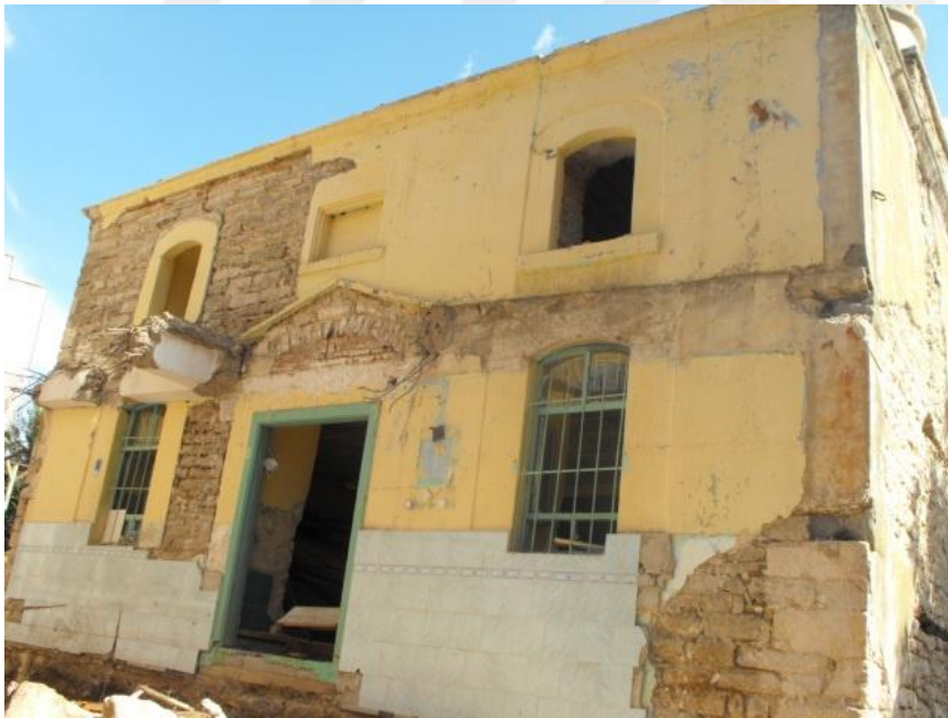
Fotoğraf 3.1.1.2.3. Halise Hatun Camii Kuzey Cephesi, 2014
