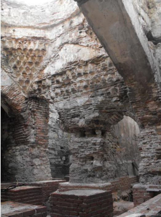
Fotoğraf 3.2.1.1.12. Uzunköprü Hamamı Kadınlar Bölümü ve Halvet Birimlerine Giriş Kapılarından Görünüm, 2014
