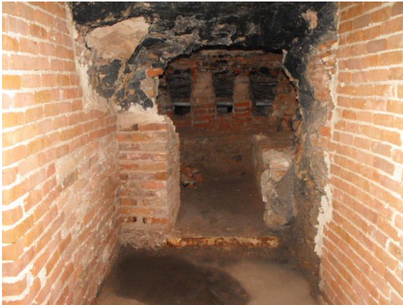
Fotoğraf 3.2.1.1.16 Uzunköprü Hamamı, Külhan Bölümünden Forsi Deliklerinin Görünüşü, 2014
