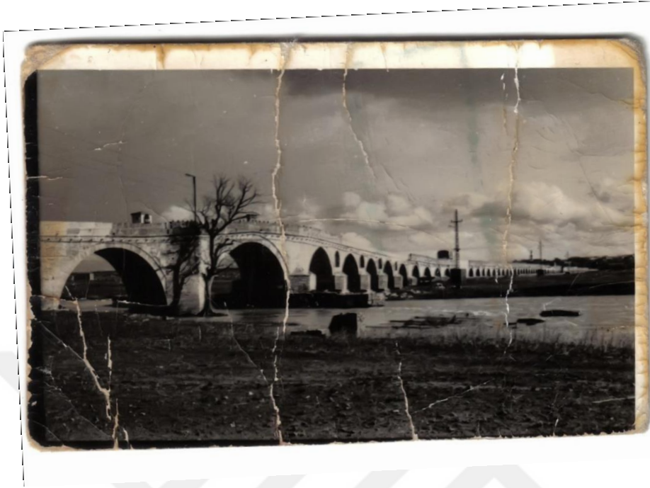
Fotoğraf 3.2.3.1.7. Köprünün Mansap Yönünden Görünüşü, (Kaynak: Ümit Soydaner'in izniyle alınmıştır)
