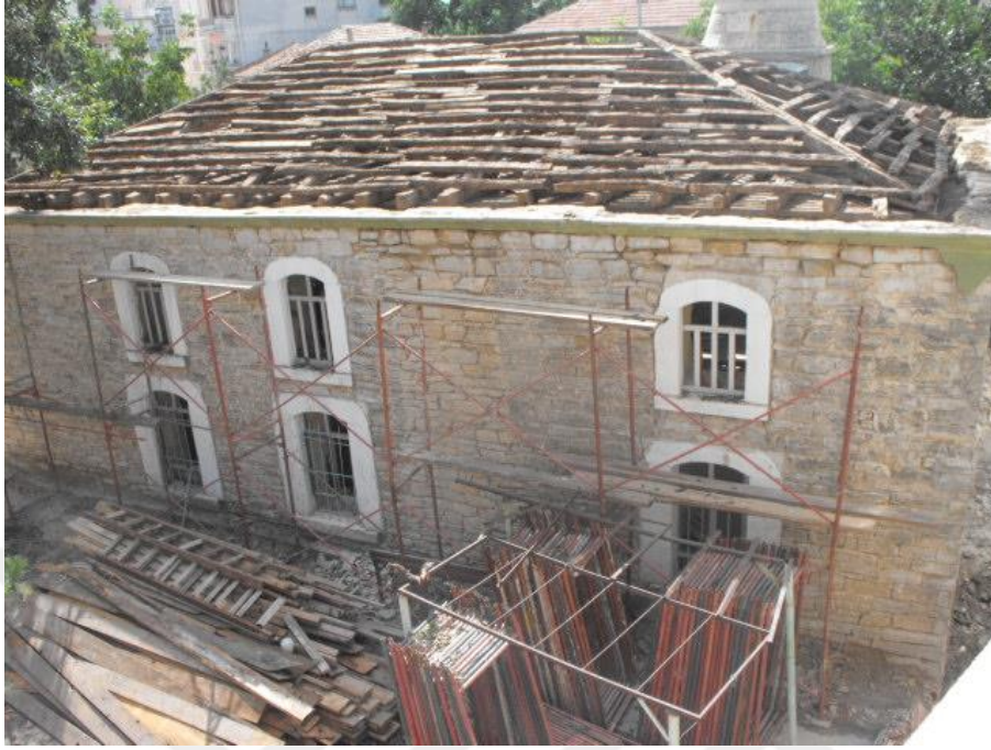
Fotoğraf 3.1.1.3.2. Halise Hatun Camii Doğu Cephesi, 2014
