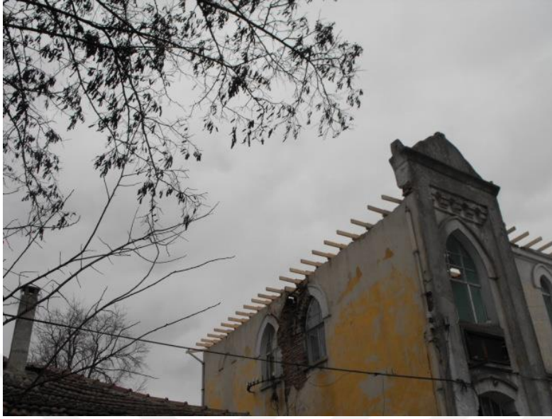
Fotoğraf 3.3.1.3. Ptt Binası, Güneybatı Cephesi, 2014
