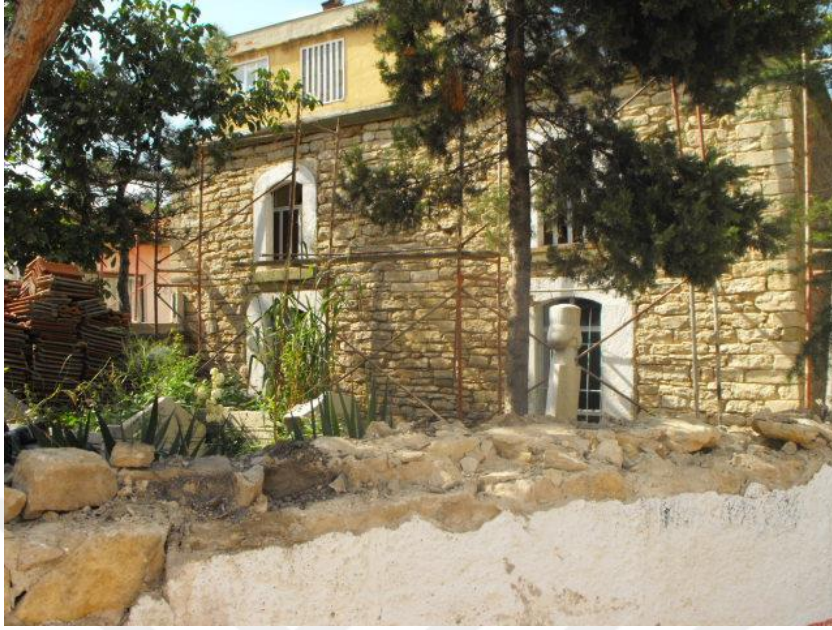
Fotoğraf 3.1.1.3.4. Halise Hatun Camii Güney Cephesi, 2014
