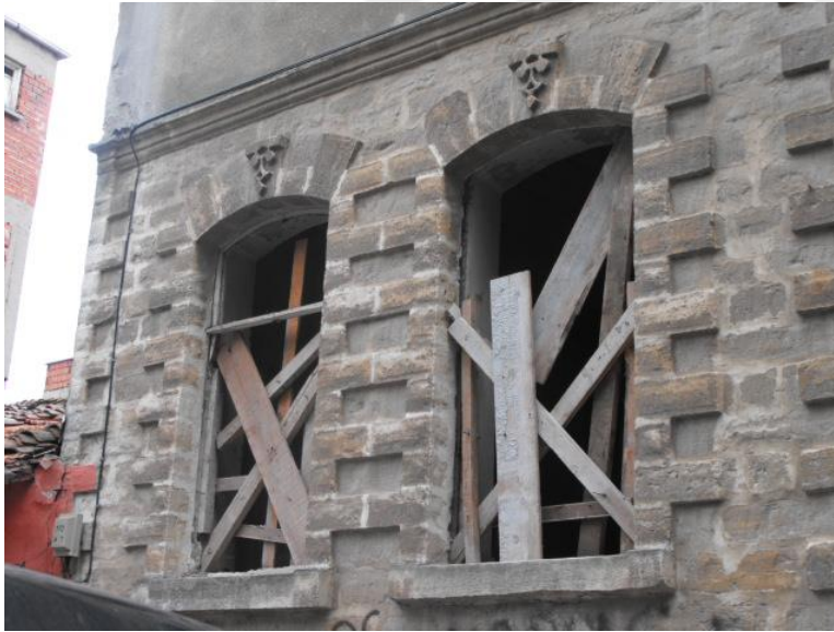
Fotoğraf 3.4.2.4. Eski Askerlik Şubesi Binası Sokağa Bakan Cephe, Pencere Detayı, 2014
