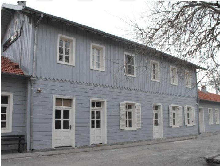
Fotoğraf 3.3.2.2. İstasyon Binası B Bloğu, 2014
