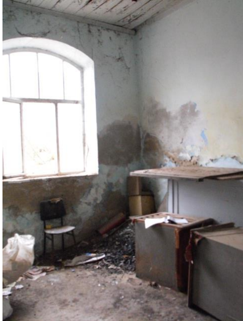
Fotoğraf 3.3.1.6. Ptt Binası, İç Mekan Kuzeybatı Yönüne Bakan Oda,2014
