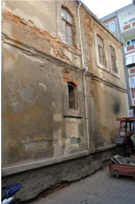
Fotoğraf 3.3.4.4. . Eski Tekel Binası Ön Cephenin Solundaki Yan Cephe, (Kaynak: Belediye Arşivi 2012)
