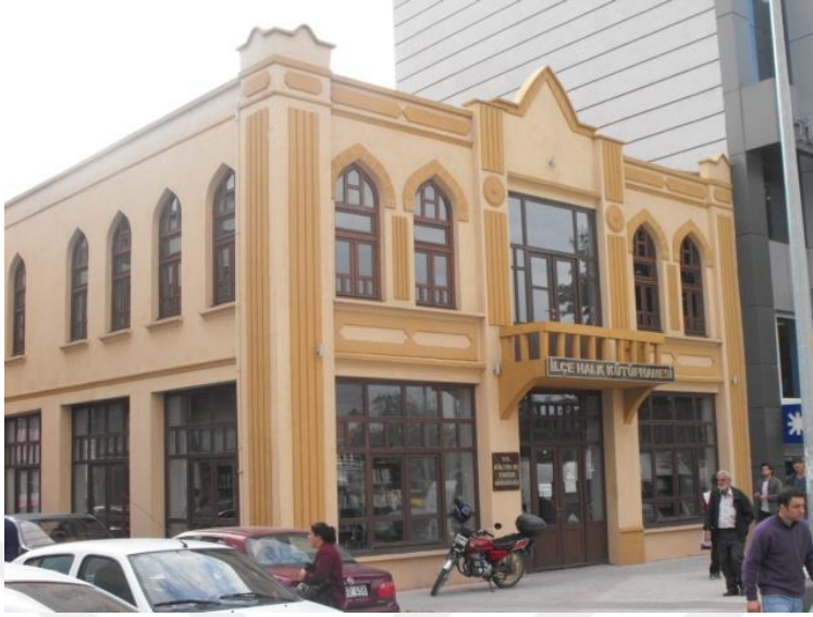
Fotoğraf 3.3.3.1. Halk Kütüphanesi Kuzeybatı Cephesinden Görünüş, 2014
