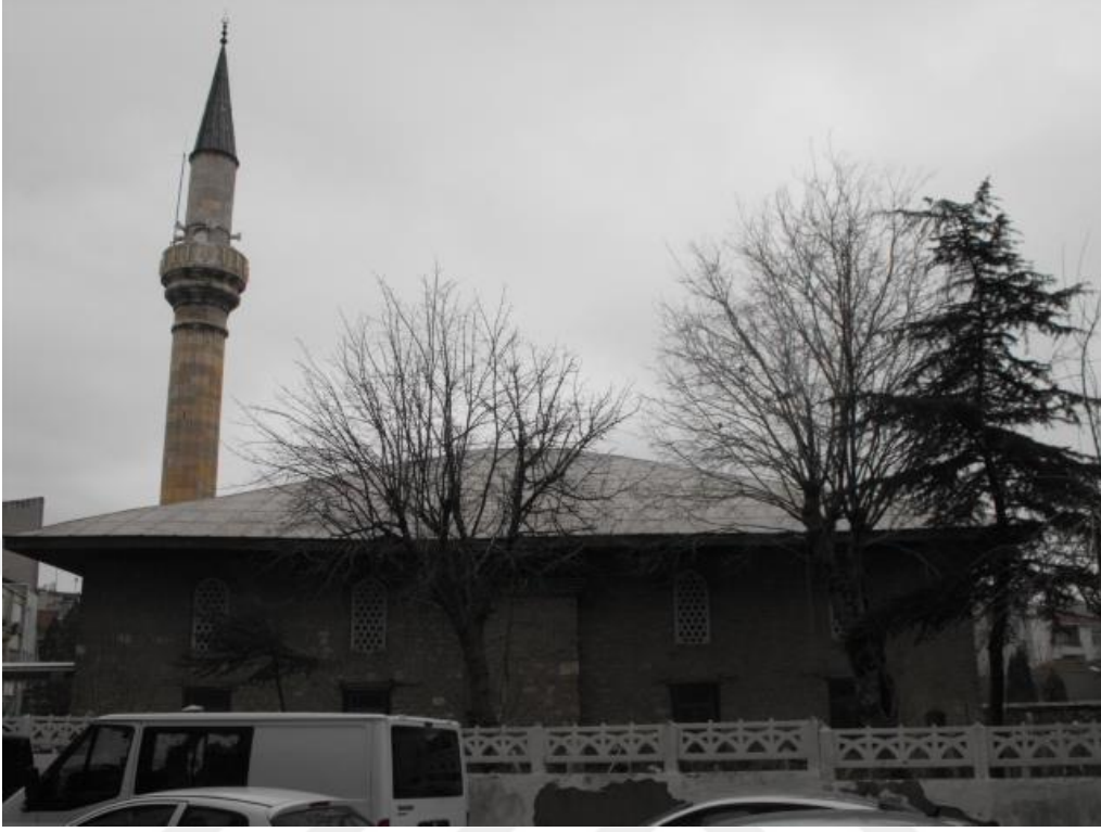
Fotoğraf 3.1.1.1.5. Muradiye Camii Güney Cephesi 2014
