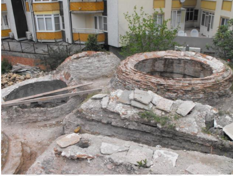
Fotoğraf 3.2.1.1.5. Uzunköprü Hamamı Kadınlar Bölümü Sıcaklık ve Halvet birimleri, 2014
