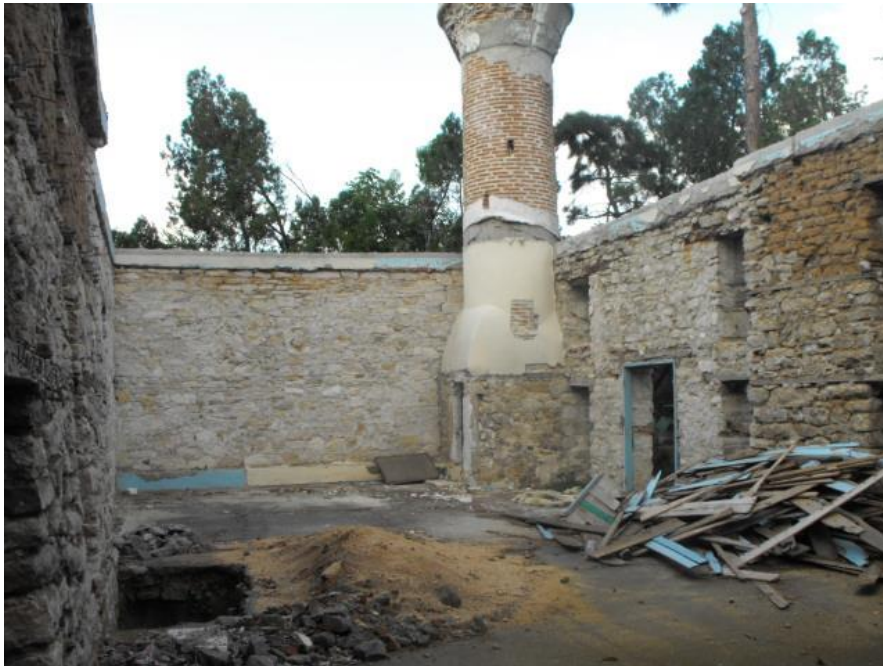
Fotoğraf 3.1.1.2.4 Habib Hoca Camii, kuzeydoğu Köşede Yer Alan Minare
