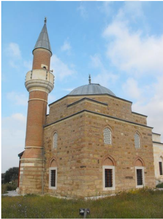
Fotoğraf 3.1.1.4.4. Gazi Turhan Bey Camii Güney ve Batı Cephelerden Görünüşü, 2014
