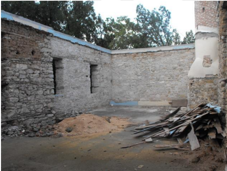
Fotoğraf 3.1.1.2.6. Habib Hoca Camii, Restorasyon Aşamasında Özgün Dokunun Görünümü, 2014
