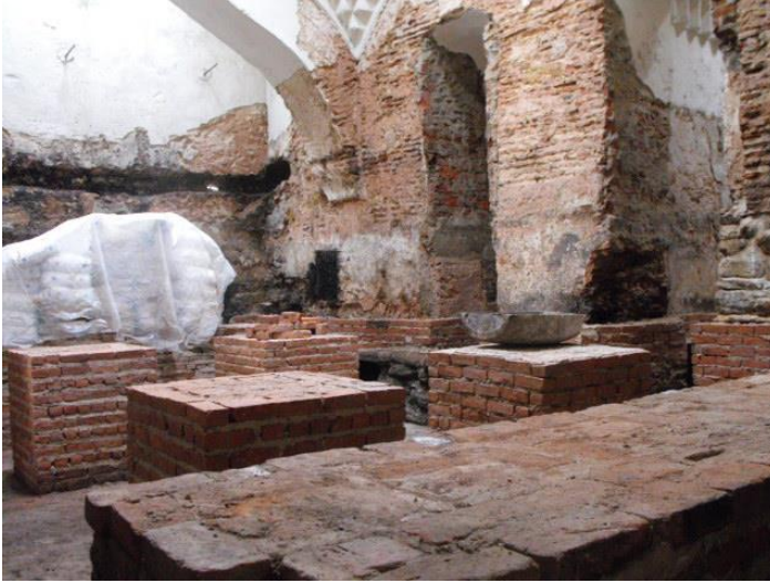
Fotoğraf 3.2.1.1.8. Uzunköprü Hamamı Erkekler Bölümü Sıcaklığı, 2014
