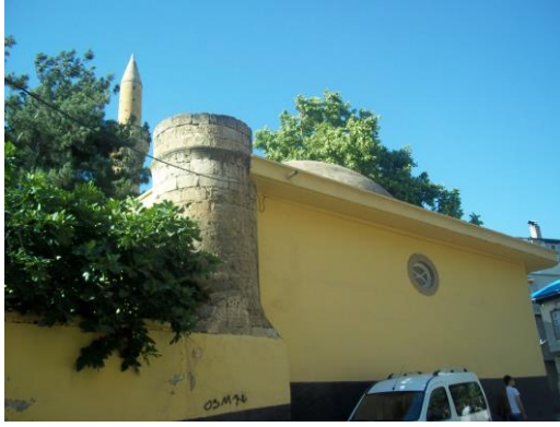
Resim 63: Nakıb Camii Eski Minare(N. Çakmak)
