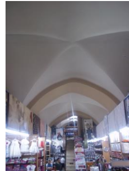
Resim 33: Yeni Bedesten, Örtü Sistemi
