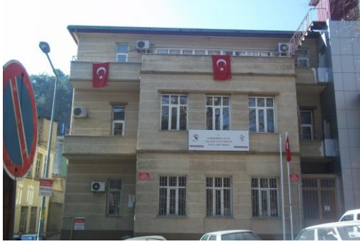
Resim 120: Eski Ziraat Bankası Binası (N. Çakmak)
