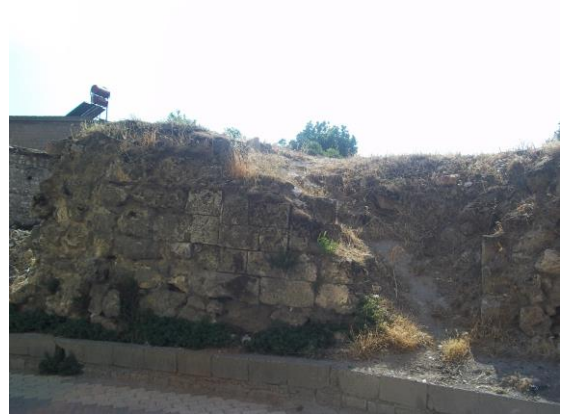
Resim 38: Paşa Hamamı Duvarları (N. Çakmak)
