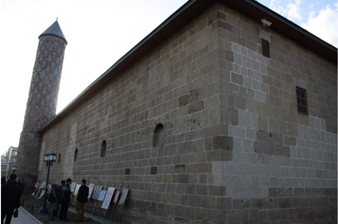
Resim 39: Erzurum Yakutiye Medresesi güney cephesi ( N. Aytaç).
