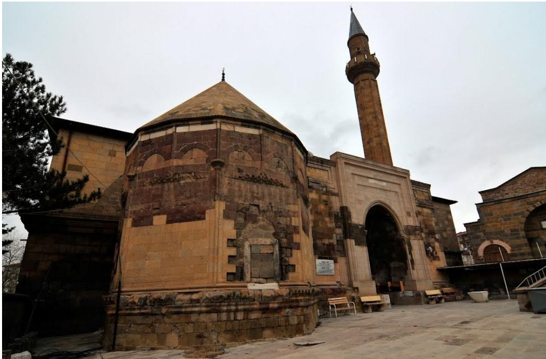
Resim 4: Niğde Sungur Bey Cami giriş cephesi (Panoramio.com).
