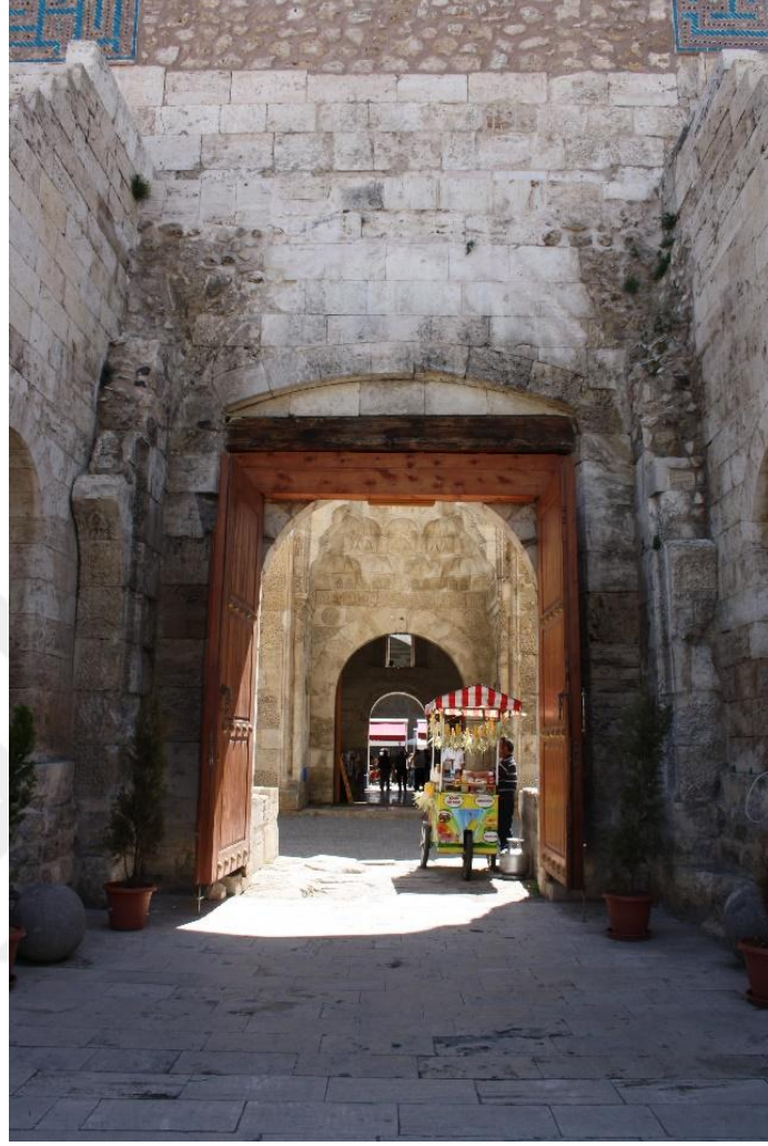
Resim 20: Sivas Çifte Minareli Medrese giriş eyvanı (N. Aytaç).
