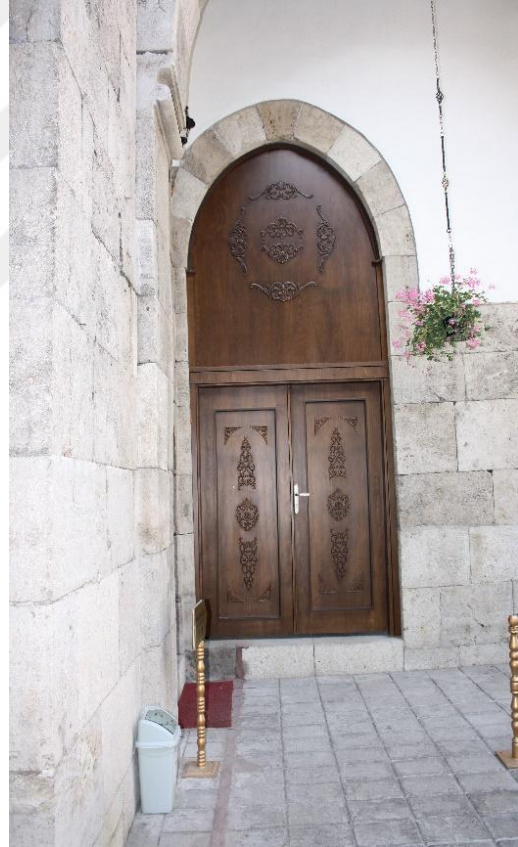
Resim 32: Amasya Darüşşifası giriş eyvanı yönündeki mekânlar (N. Aytaç).
