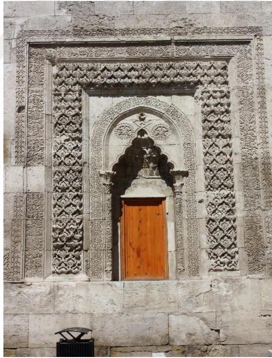
Resim 29: Sivas Çifte Minareli Medrese giriş cephesi detay (N. Aytaç).
