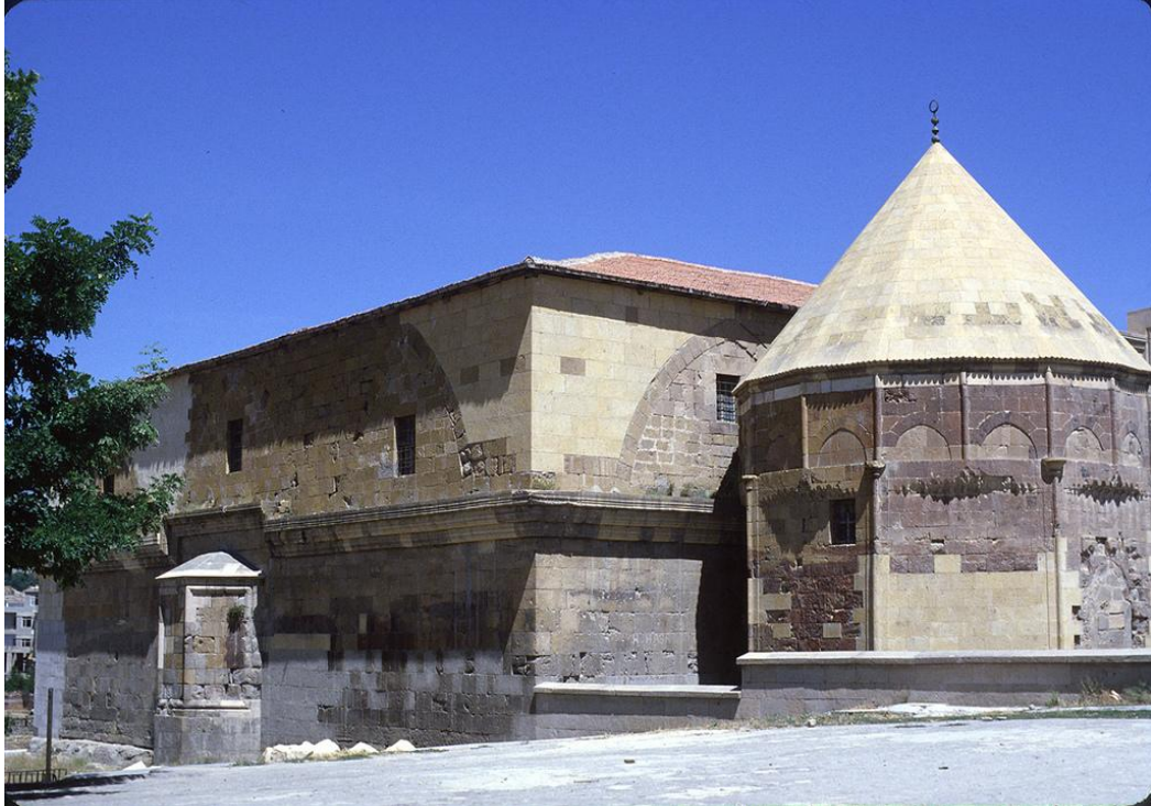
Resim 8: Niğde Sungur Bey Cami güney cephesi (Panoramio).
