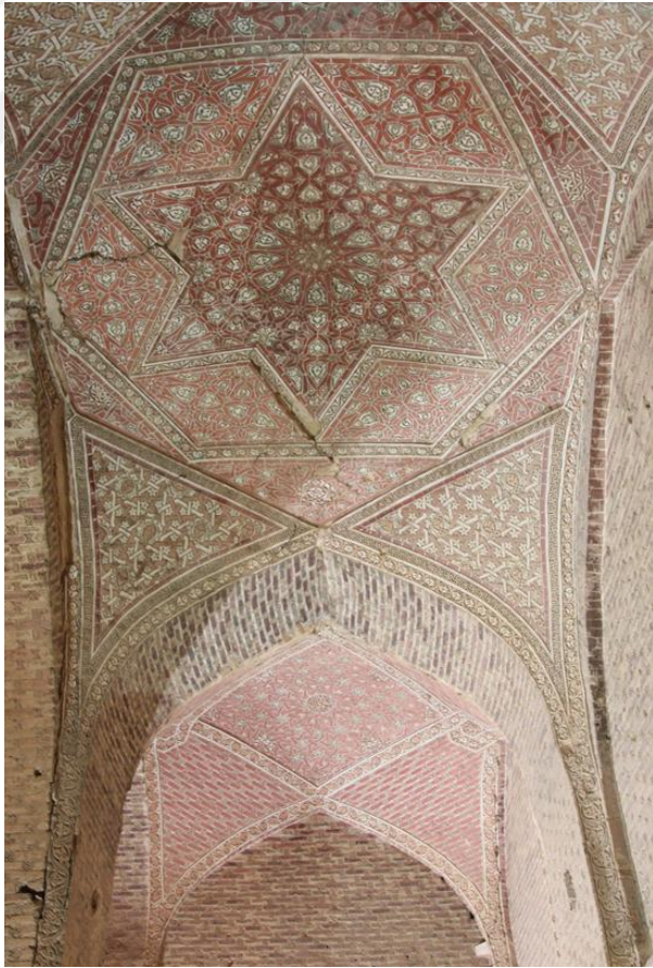
Resim 87: Sultan Olcayto Türbesi tonozları (H.F. Yılmaz).
