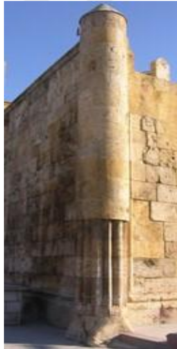
Resim 17: Kırşehir Cacabey Medresesi kuzeydoğu-kuzeybatı ve batı cephesi üzerinde yer alan destek kuleleri (Panoramio.com).
