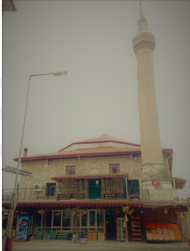
Resim 10: Tokat Halil Bey Cami giriş cephesi (N. Aytaç).
