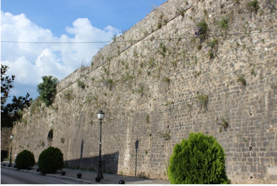
Resim 170: Batı surlarından görünüm, Eylül 2016 (A.Ateş)
