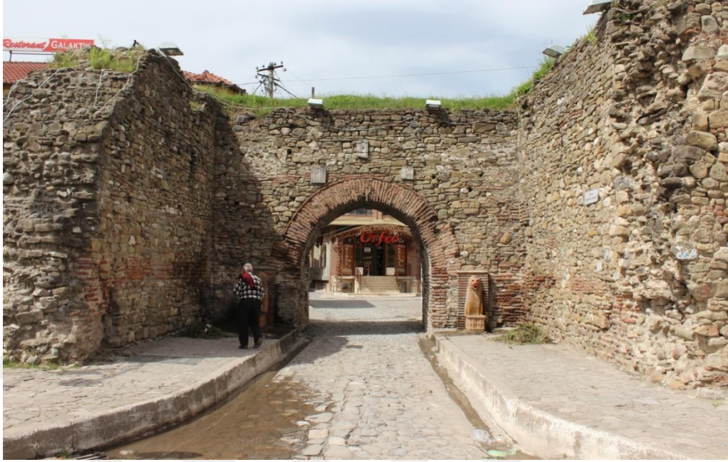
Resim 30: Elbasan surları üzerinde yer alan güney kapısı, Nisan 2016 (A.Ateş)
