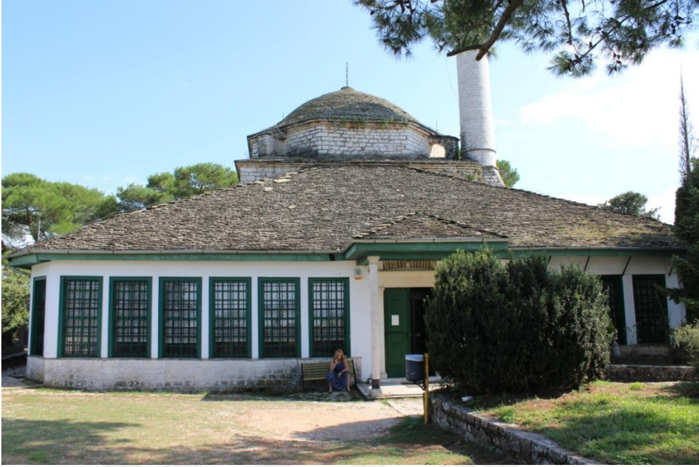
Resim 128: Aslan Paşa Camii'nin ön cepheden görünümü, Eylül 2016 (A.Ateş)
