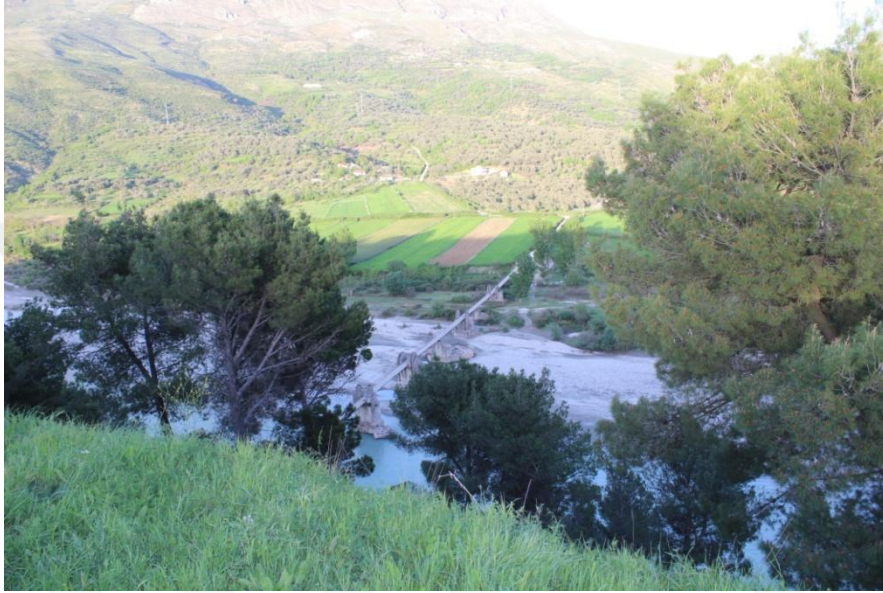
Resim 74: Vjosa Nehri üzerindeki köprü, Nisan 2016. (A.Ateş)
