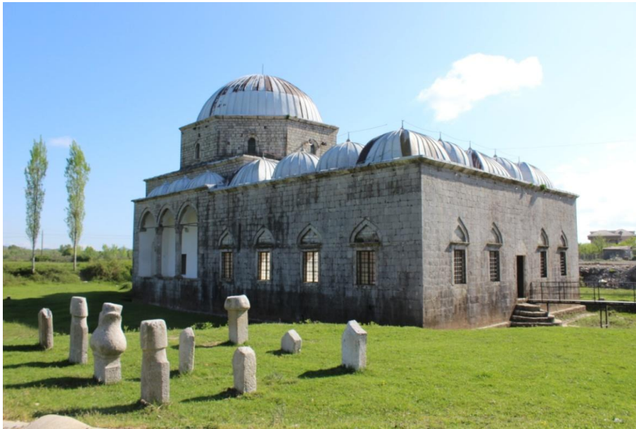
Resim 1: Buşatlı Mehmet Paşa Camii veya Kurşunlu Camii (H.1187 - M.1773), Nisan 2016 (A.Ateş)
