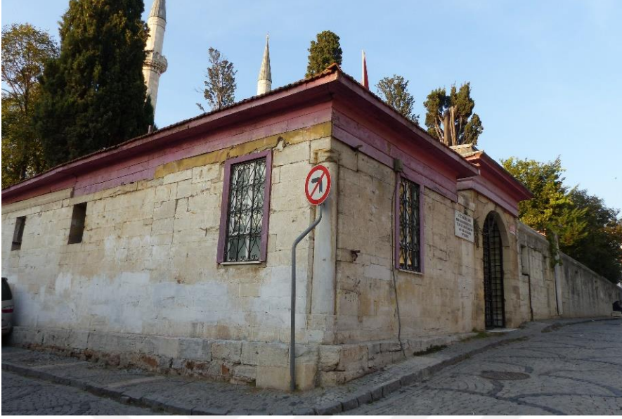
Resim 3.28 Üsküdar Atik Valide Camii dış avlu duvarının güneybatısındaki köşe sütunu, 2017.
