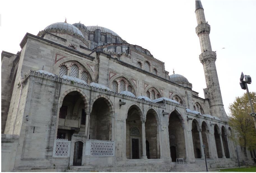
Resim 4.4 İstanbul Şehzade Mehmed Camii dış yan revaklı galeriler, 2017.
