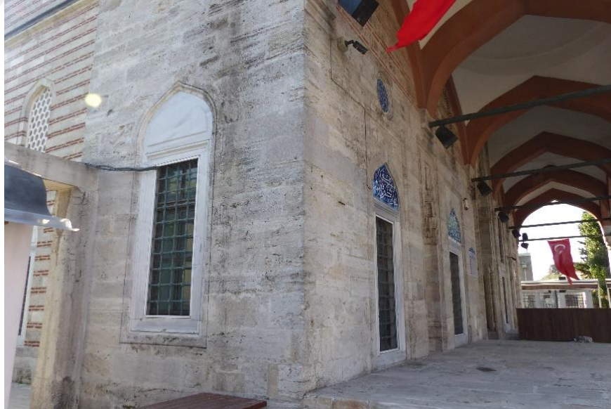
Resim 3.1 Silivrikapı Hadım İbrahim Paşa Camii kesme taş kuzey cephe ve taş-tuğla beden duvarları, 2017.
