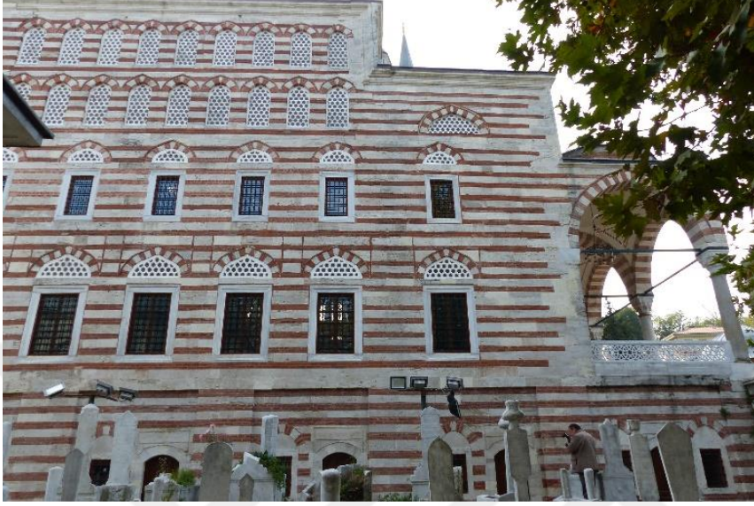
Resim 3.5 Eyüp Zal Mahmut Paşa Camii taş-tuğla duvar dokusu, 2017.
