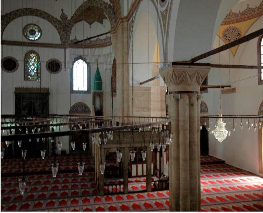
Resim 5.3 Konya Selimiye Camii, kubbeyi taşıyan dilimli ayak (K.Kuşüzümü, 2017)
