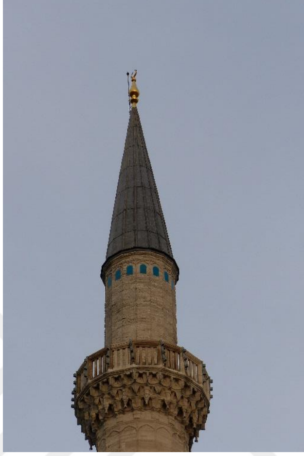
Resim 7.12 İstanbul Süleymaniye Camii, külah altındaki çiniler, 2017.
