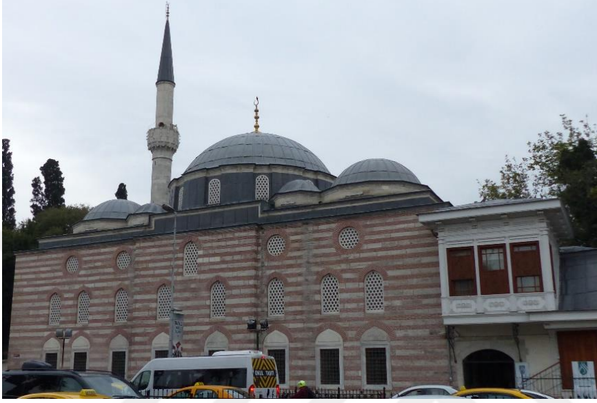
Resim 3.2 Beşiktaş Sinan Paşa Camii taş-tuğla duvar dokusu, 2017.
