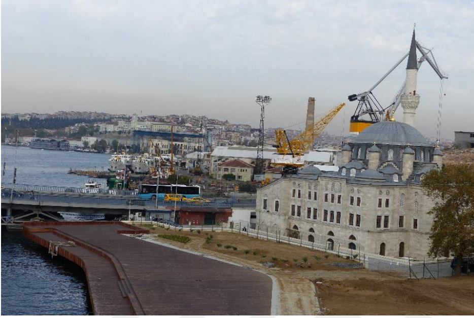
Resim 2.8 Azapkapı Sokollu Camii ve Kasımpaşa tersanesi, 2017.
