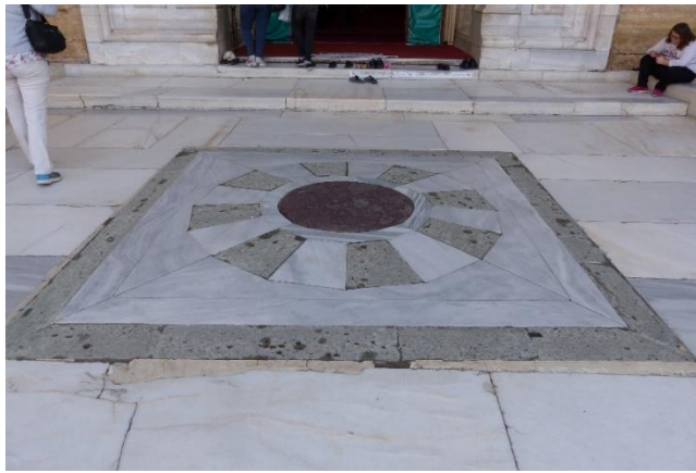
Resim 3.21 Edirne Selimiye Camii harim girişi önünde döşeme taşı, 2017.
