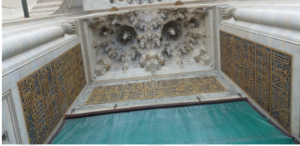
Resim 7.25 İstanbul Süleymaniye Camii, inşa kitabesi, 2017.
