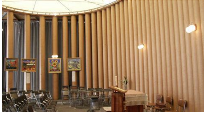
Şekil 2.51: Shigeru Ban Tarafından Geliştirilen Kağıt Tüpler Kullanılarak İnşa Edilmiş Yapı. ( http://v3.arkitera.com , Erişim:02.06.2016)
