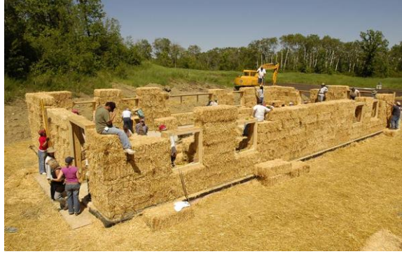
Şekil 2.48: Saman Balyasından Ev Yapımı. ( https://gaiadergi.com , Erişim:02.06.2016)
