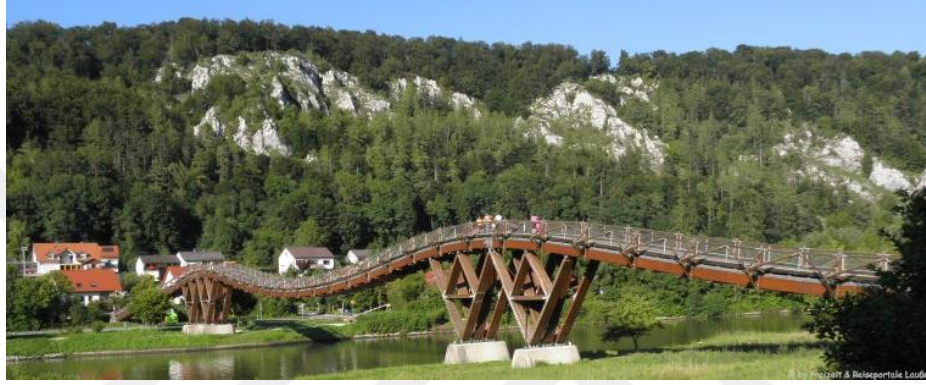
Şekil 2.63: Lamine Ahşap Malzemenin Kullanıldığı Köprü Örneği. ( http://www.sehenswerter-bayerischer-wald.de , Erişim: 19.09.2017)
