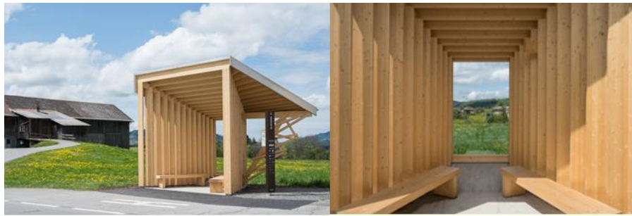
Şekil 2.73: Ahşap Malzemenin Otobüs Durağında Kullanımı. ( https://www.archdaily.com , Erişim:19.10.2018)
