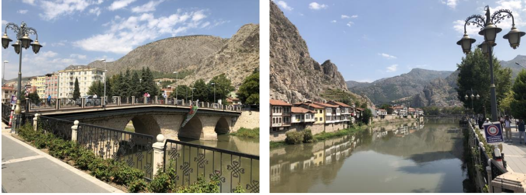
Şekil 3.8: İstasyon Köprüsü ve Çalışma Alanı Başlangıcı (Orijinal, 2018).
