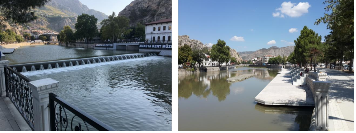
Şekil 3.12: Amasya Yeşillik Sergi ve Müze Binası Lastik Bendi ve Yenilenebilir Enerji Çevre Peyzaj Düzenlemesi Yapımı Projesinden Görseller (Orijinal, 2018).
