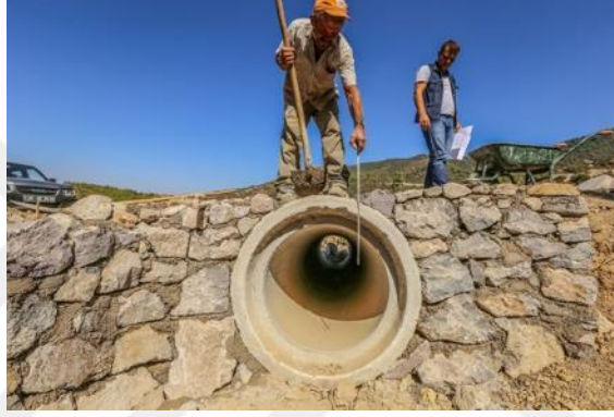
Şekil 2.12: Orman yolu sanat yapısı çalışmaları (OGM)
