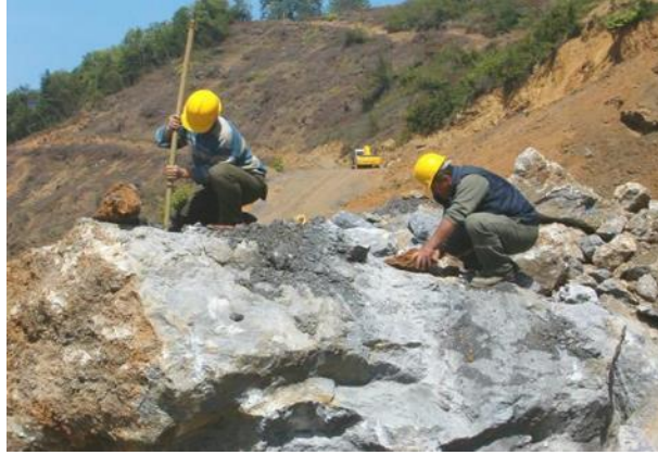
Şekil 2.11: Kayaların patlatılması için lağım deliği açma çalışmaları (OGM)
