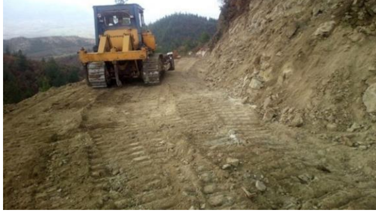
Şekil 2.10: Orman yol inşaat çalışmaları (OGM)
