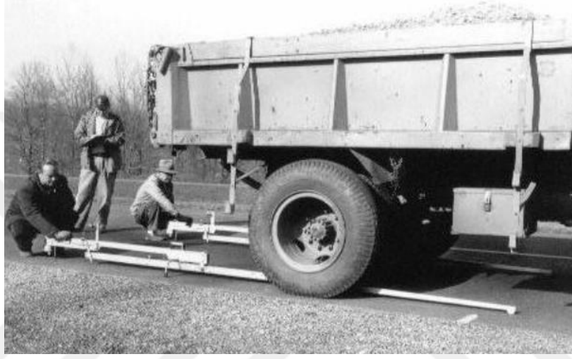
Şekil 2.17: Benkelman Beam'in AASHO testi (Rabaiotti, 1975)
