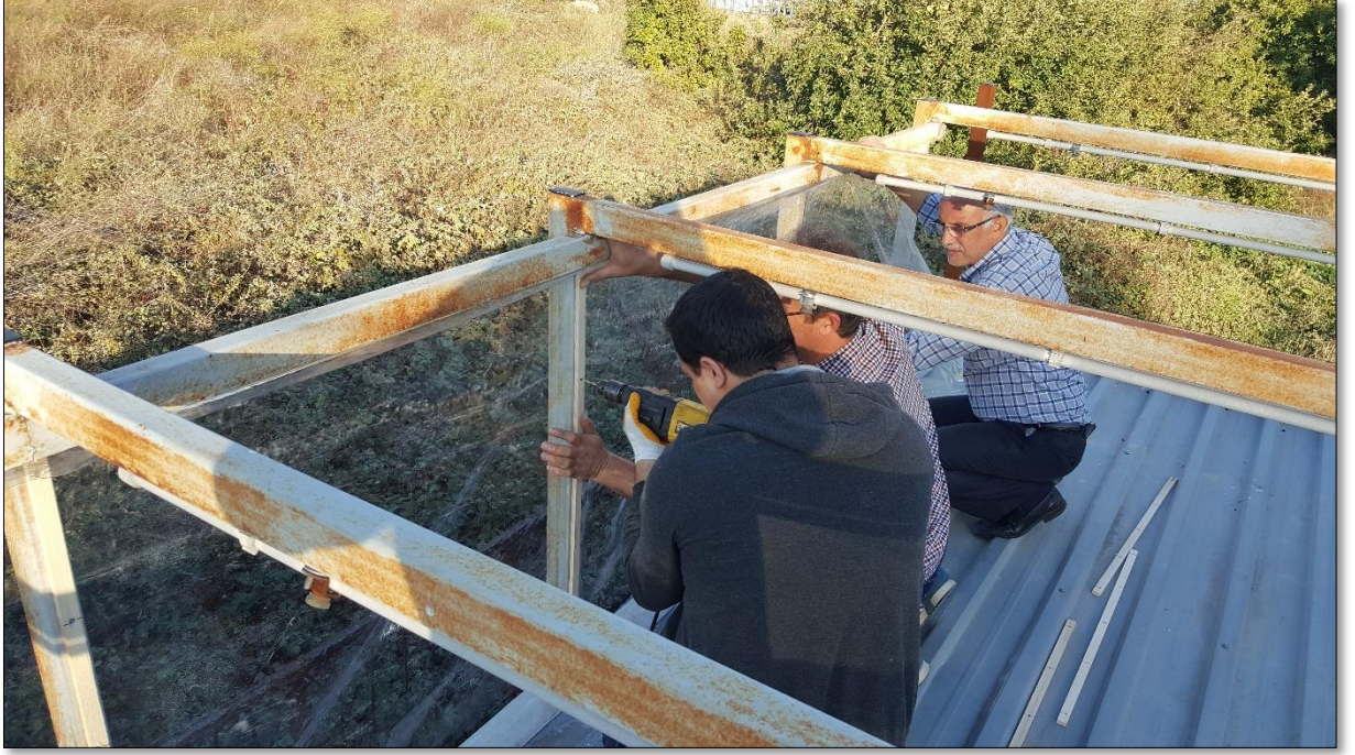
Şekil 3.18: Sisteme naylon branda gerilmesi.
