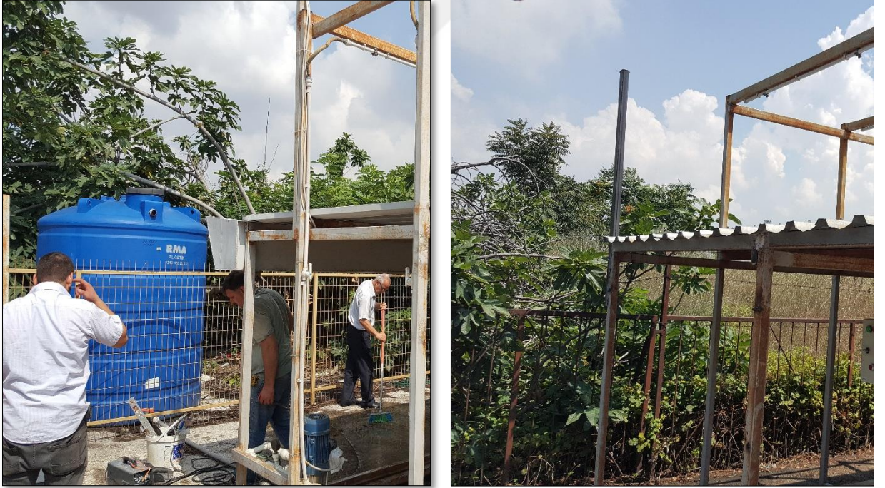
Şekil 3.15: Yağmur deresinin sökülme işlemi (solda), çelik çubuğun sisteme kaynaklanmış şekli (sağda).
