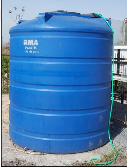
Şekil 3.12: Sisteme verilen suyun depolandığı polietilen su tankı.
