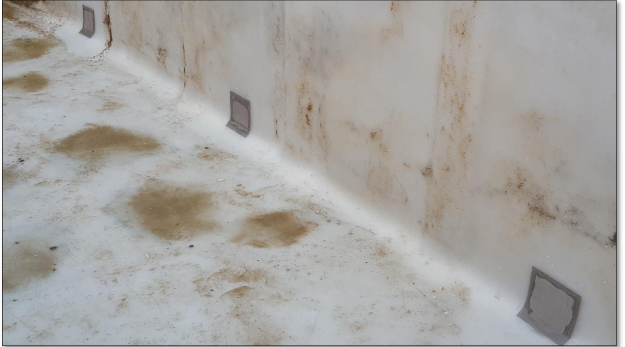
Şekil 3.26: Boruların iç tarafına yapıştırılmış çelik kum filtreleri.
