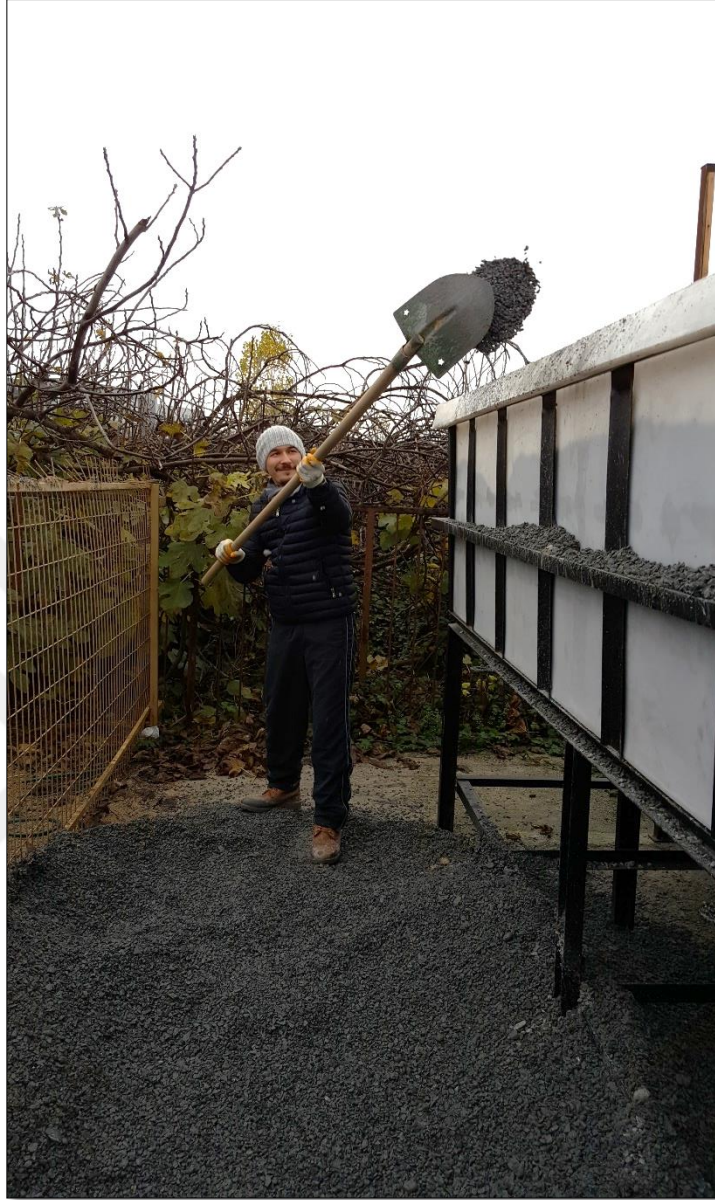
Şekil 3.21: Sızdırma hendeğinin doldurulması işlemi.
