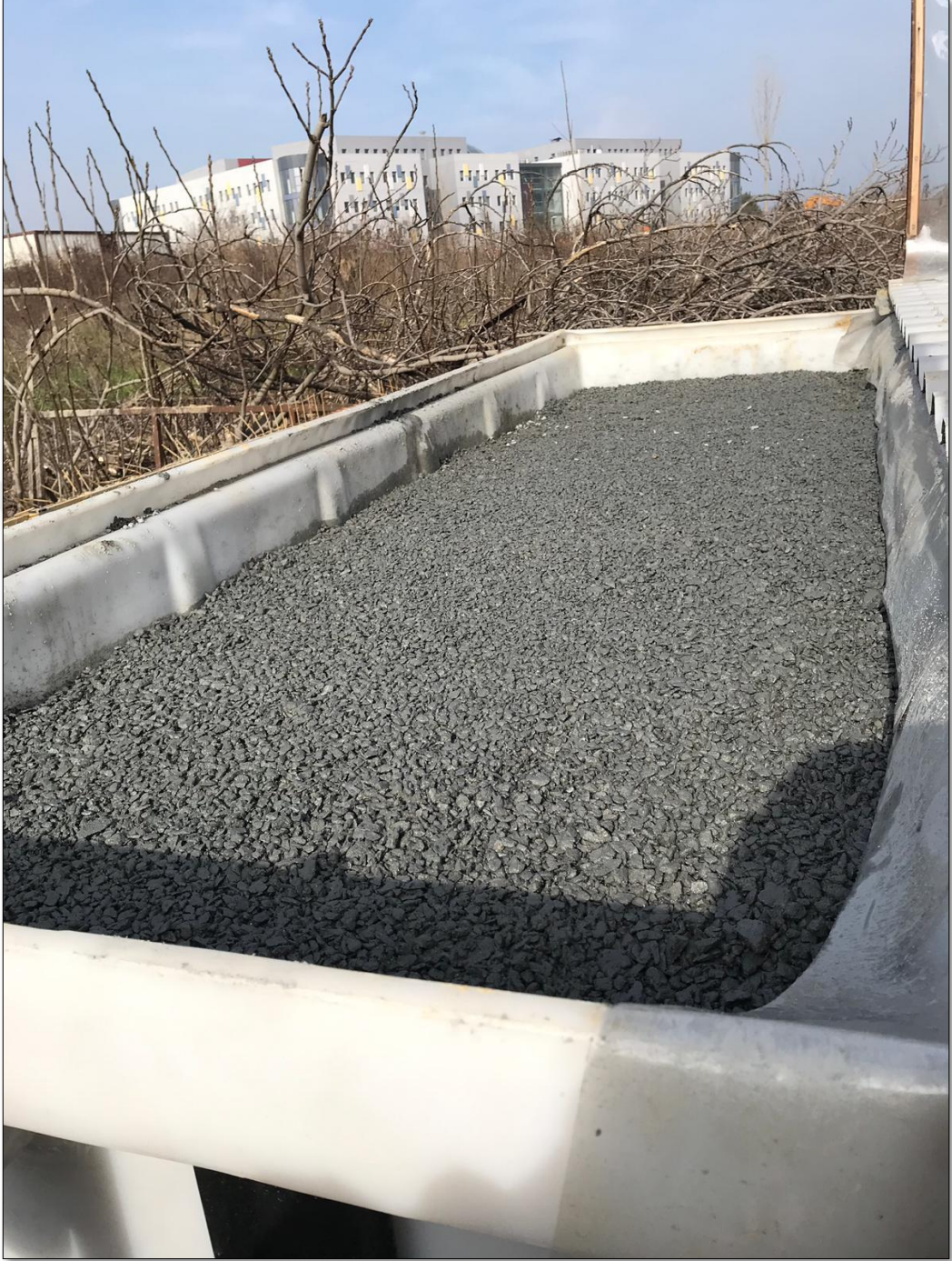
Şekil 3.29: Kum katman üzerine serilmiş çakıl katmanı.
