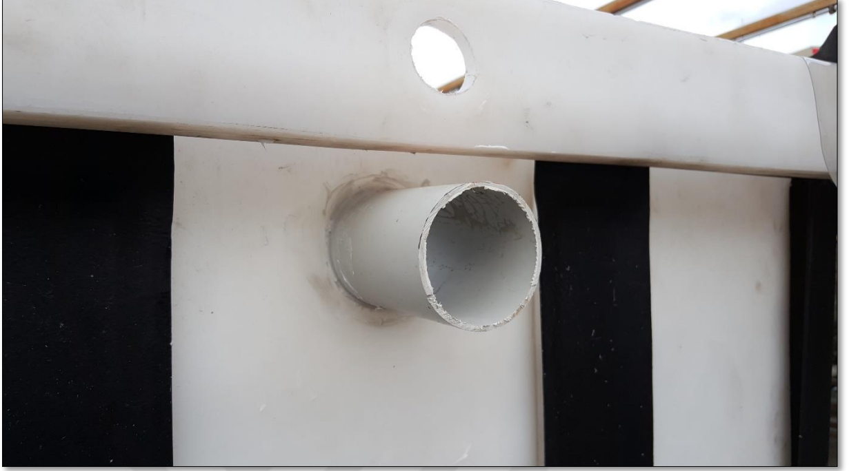
Şekil 3.24: Çapı genişletilmiş ve konumu değiştirilmiş aşma debisinin ölçüldüğü güncel PVC boru.
