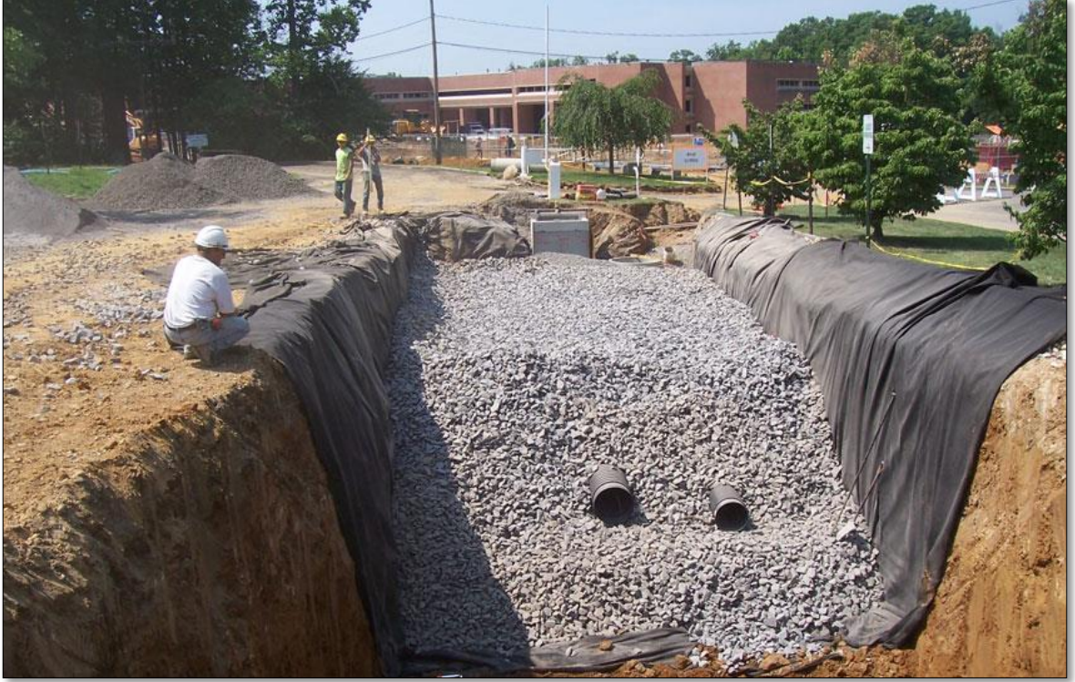
Şekil 2.1: Sızdırma hendeğinin yapım aşamasındaki görünümü
