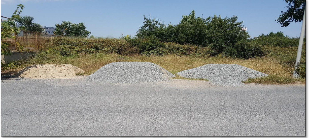
Şekil 3.20: Sızdırma hendeğini oluşturan kum ve çakıl malzemeler.
