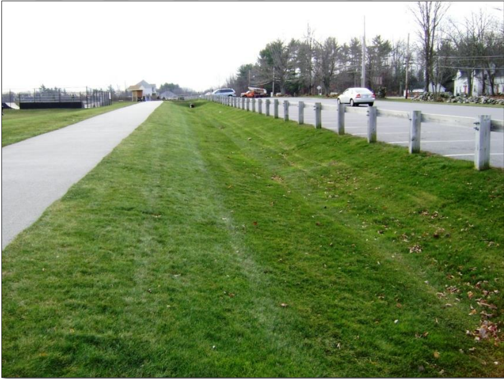
Şekil 2.5: Geçirimsiz yüzeyin yanına uygulanmış yağmur hendeği ( http://prj.geosyntec.com/npsmanual/image/waterqualityswales.jpg ).
