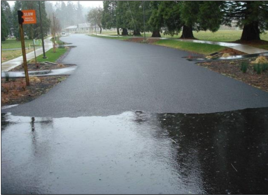
Şekil 2.3: Geçirgen asfalt ile klasik asfaltın karşılaştırılması ( https://www.vaasphalt.org/wp-content/uploads/2013/05/you-can-clearly-see-where-the-porous-asphalt-pavement-stops.jpg ).
