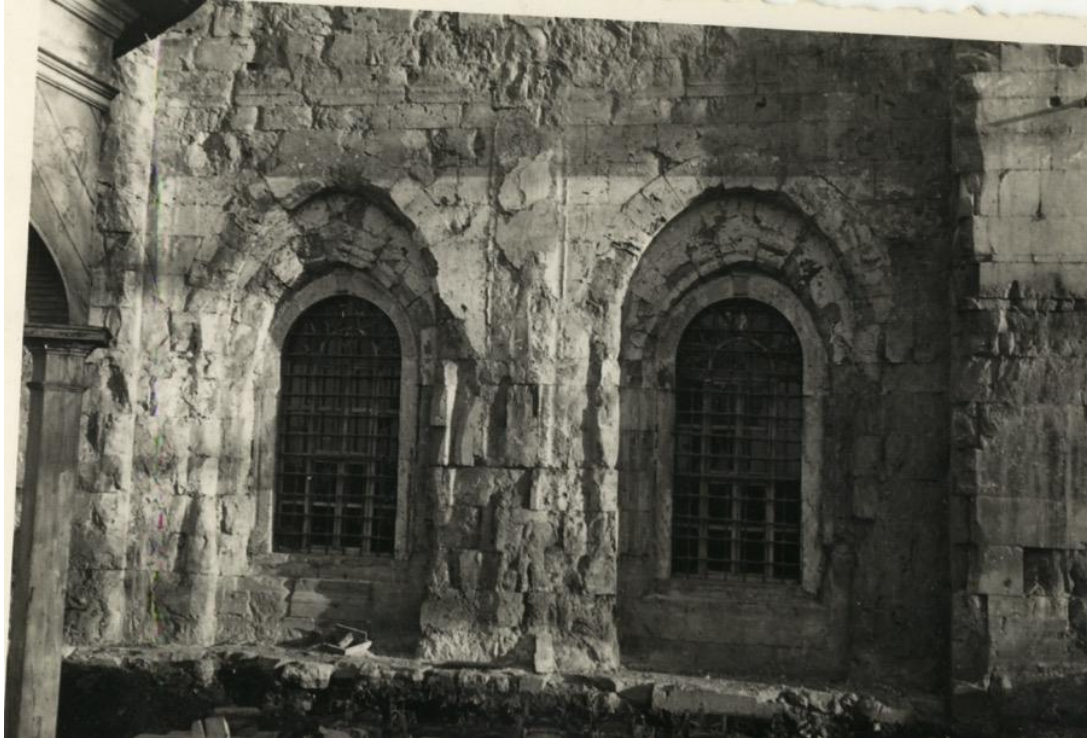
Resim 4.206. Ulucami Kuzey Cephe Duvar Örgüsü (Kaynak: 1951 Baykal arşivi-YEBEK)
