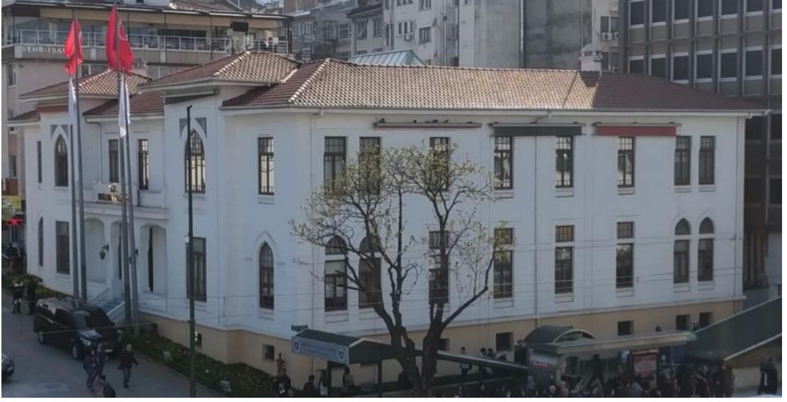
Resim 4.121. Muhasebe-i Hususiye (Valilik) Binasi Doğu Ve Kuzey Cephesi. (Foto: H.Gürsel Bilmiş-2019)
