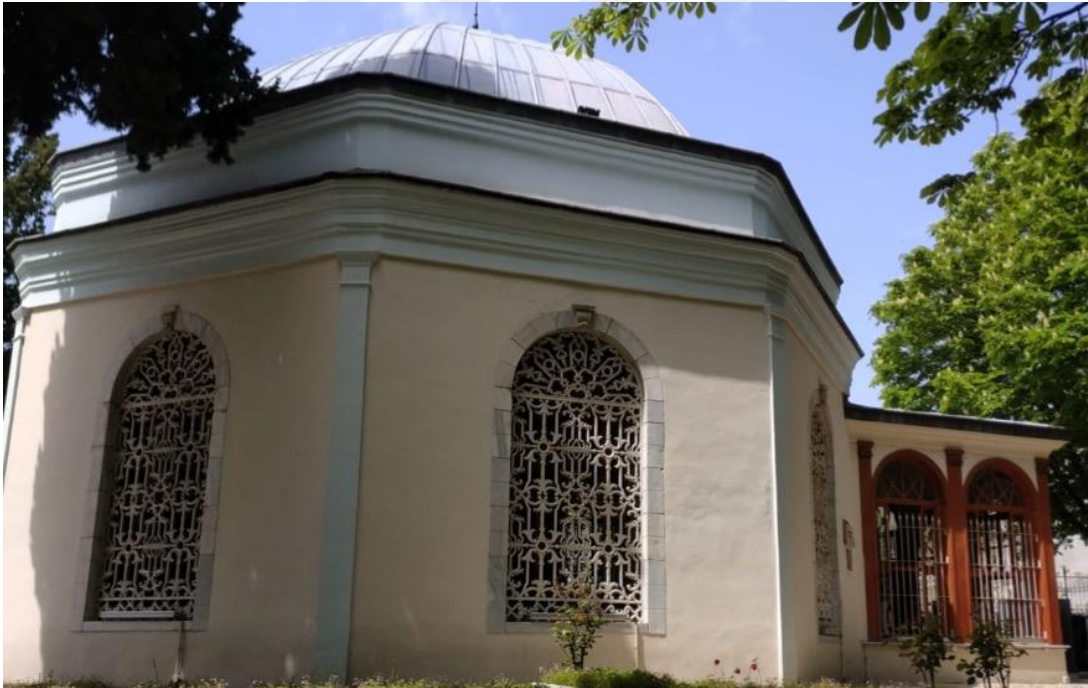
Resim 4.145. Osman Gazi Türbesi Doğu Cephesi Pencere Demir Şebekeleri (Foto: H.Gürsel Bilmiş-2019)
