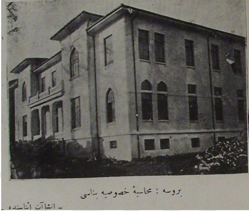
Resim 4.119. İnşaatı Bitme Aşamasındaki Muhasebe-i Hususiye Binası (Kaynak: 1927 Bursa Salnamesi)
