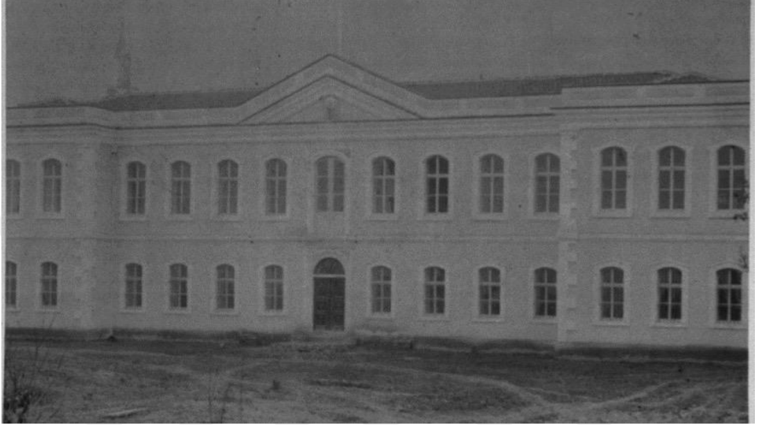
Resim 4.82. Bursa Mekteb-i İdâdi-i Mülkisi Ana Binasının İnşaatının Henüz Tamamlandığı Sırada Çekilen Bir Fotoğrafi. Kuzey Cephe (Kaynak: İÜNEK-9525/23-Sebah & Joillier-tarihsiz)
