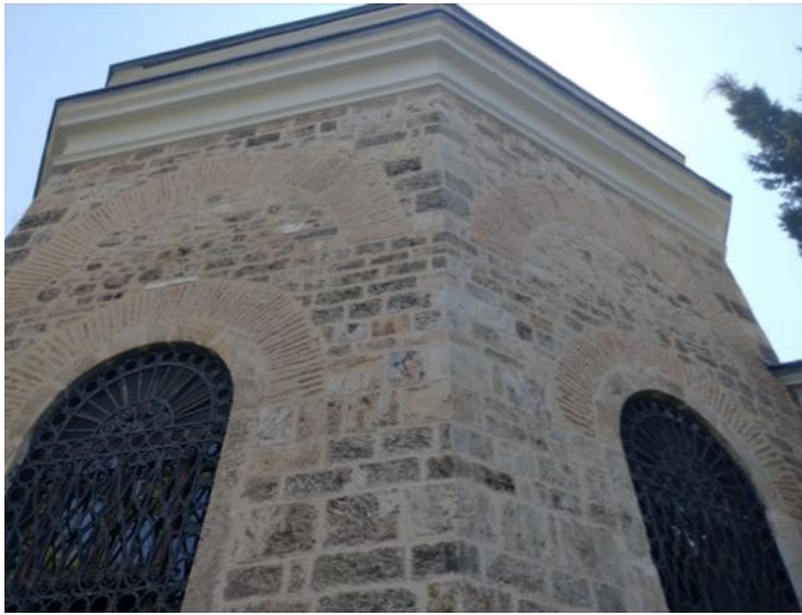
Resim 4.166. Emir Sultan Türbesi Kuzey Cepheden Pencere Kemerleri İle Kubbeyi Taşıyan Battal Tuğla Kemerler. (Foto: H.Gürsel Bilmiş-2019)
