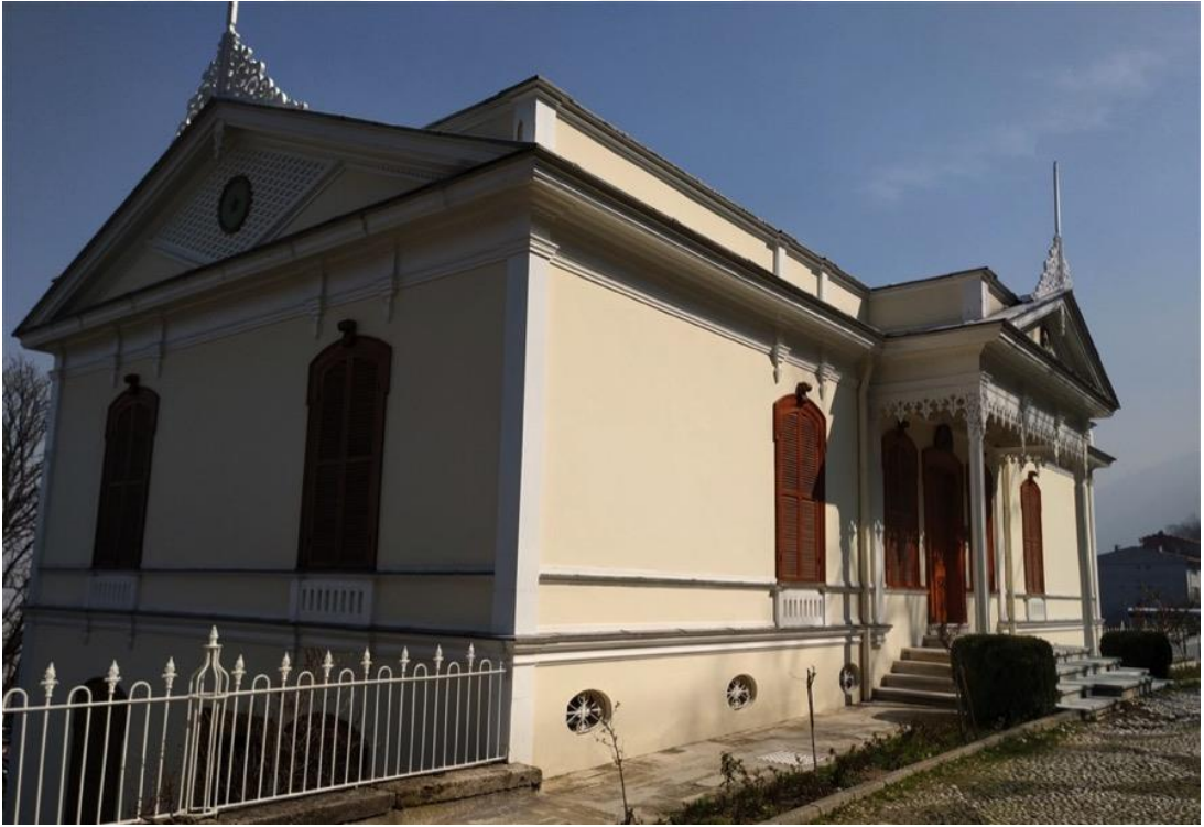
Resim 4.4. Kasr'ın Güneybatıdan Görünüşü. (Foto: H.Gürsel Bilmiş-2019)
