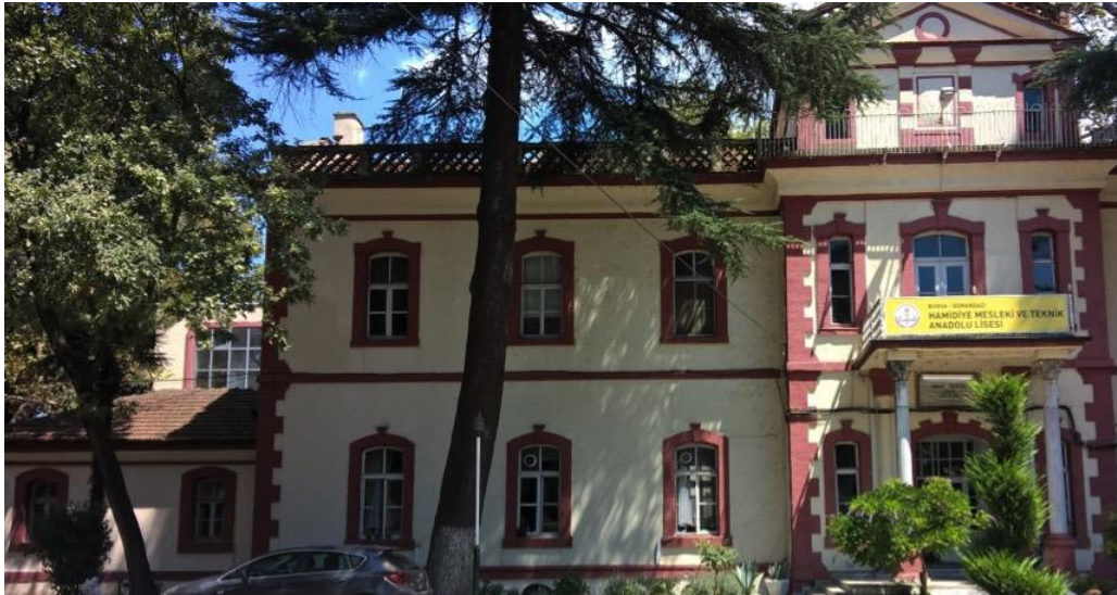
Resim 4.73. Hüdavendigâr Ziraat Mektebi Ana Binanın Güneye Bakan Girişin Sol Cephesi. (Foto: H.Gürsel Bilmiş-2018)
