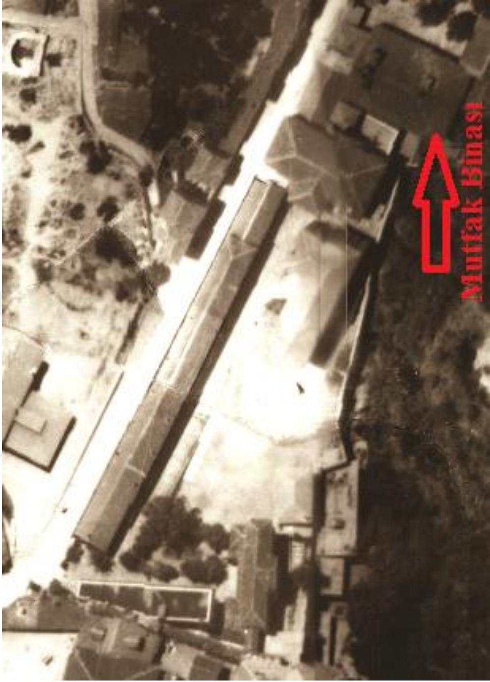
Resim 4.108. Henüz Yıkılmamış Olan Mutfak/Kiler Binası. 1939. (Kaynak: B.B.B Kent Belleği)
