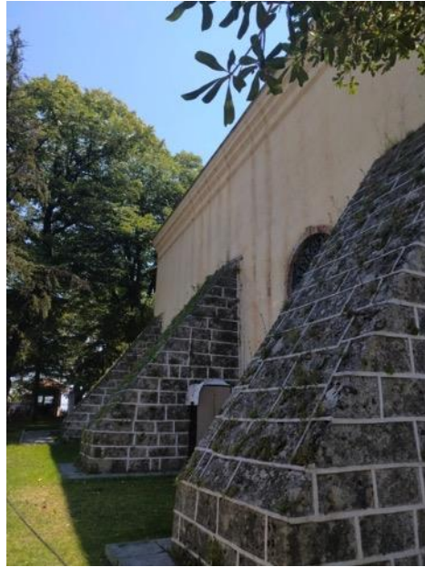
Resim 4.192. Hüdevendigar Gazi Türbesi Kuzey Duvarına Pandalaki Kalfa Tarafından İnşa Edilen Destek Ayakları. (Foto: H.Gürsel Bilmiş-2019)
