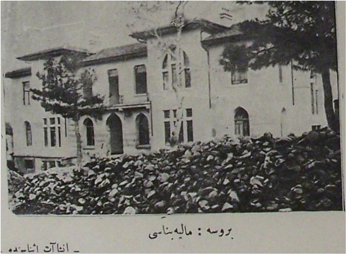
Resim 4.122. İnşaat Halindeki Maliye Binasi. Güneybatıdan Görünüş (Kaynak: 1927 Bursa Salnamesi)
