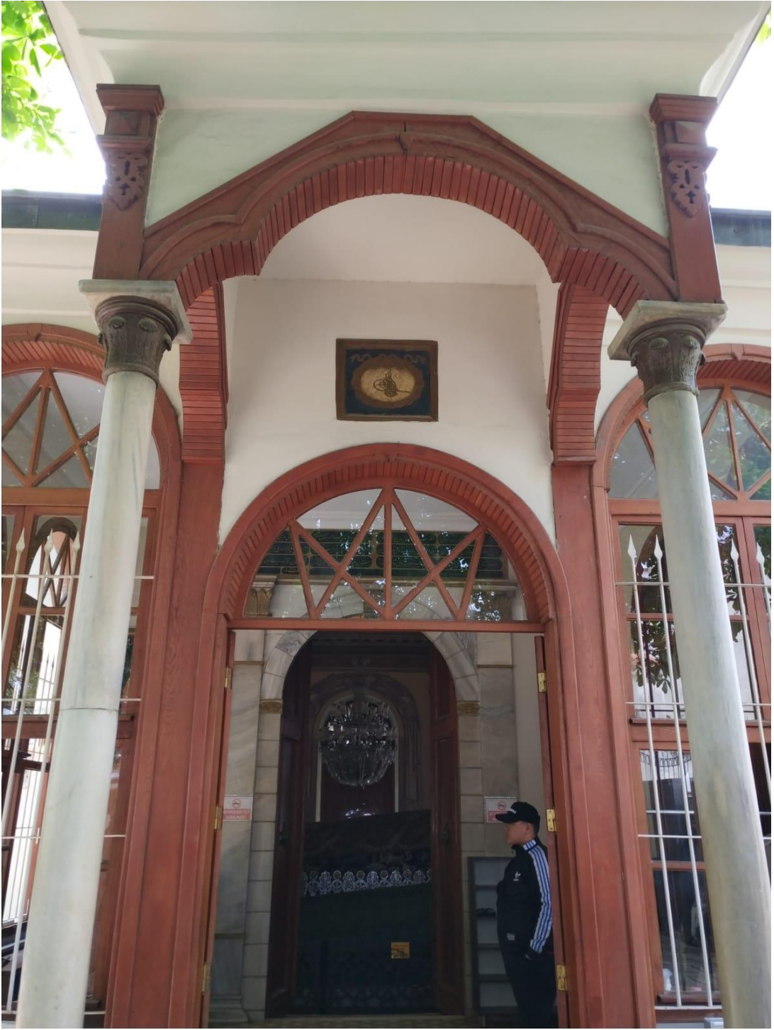
Resim 4.142. Osman Gazi Türbesi Giriş Kapısı, İnce Sütunçeler Ve Sundurma (Foto: H.Gürsel Bilmış-2019)
