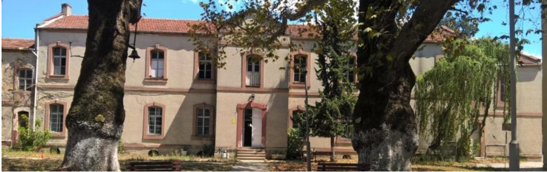
Resim 4.78. Hüdavendigar Ziraat Mektebi Dershane Ve Yatakhane Binası Kuzey Cephesi. (Foto: H.Gürsel Bilmiş-2018)
