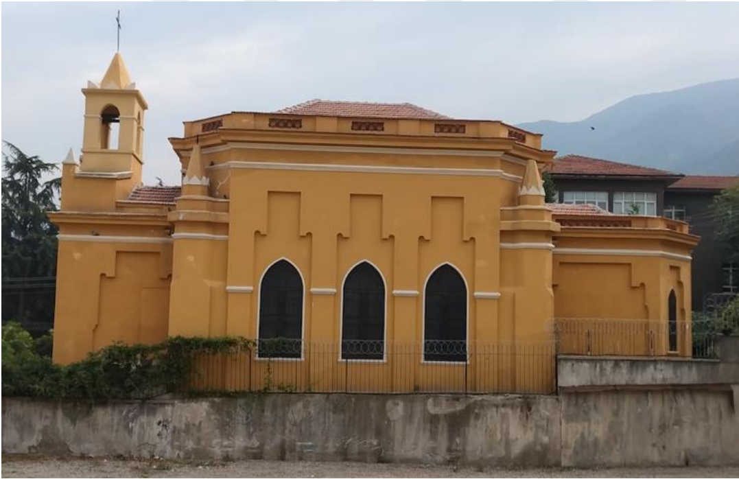
Resim 4.20. Fransız Kilisesi Binası Batı Cephesi. (Foto: H.Gürsel Bilmiş-2019)
