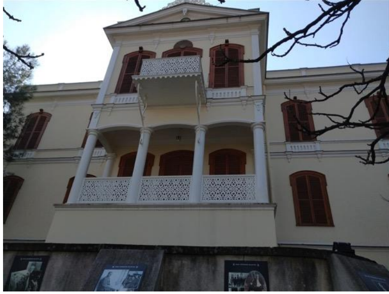
Resim 4.5. Kuzey Cephe (Foto: H.Gürsel Bilmiş-2019)
