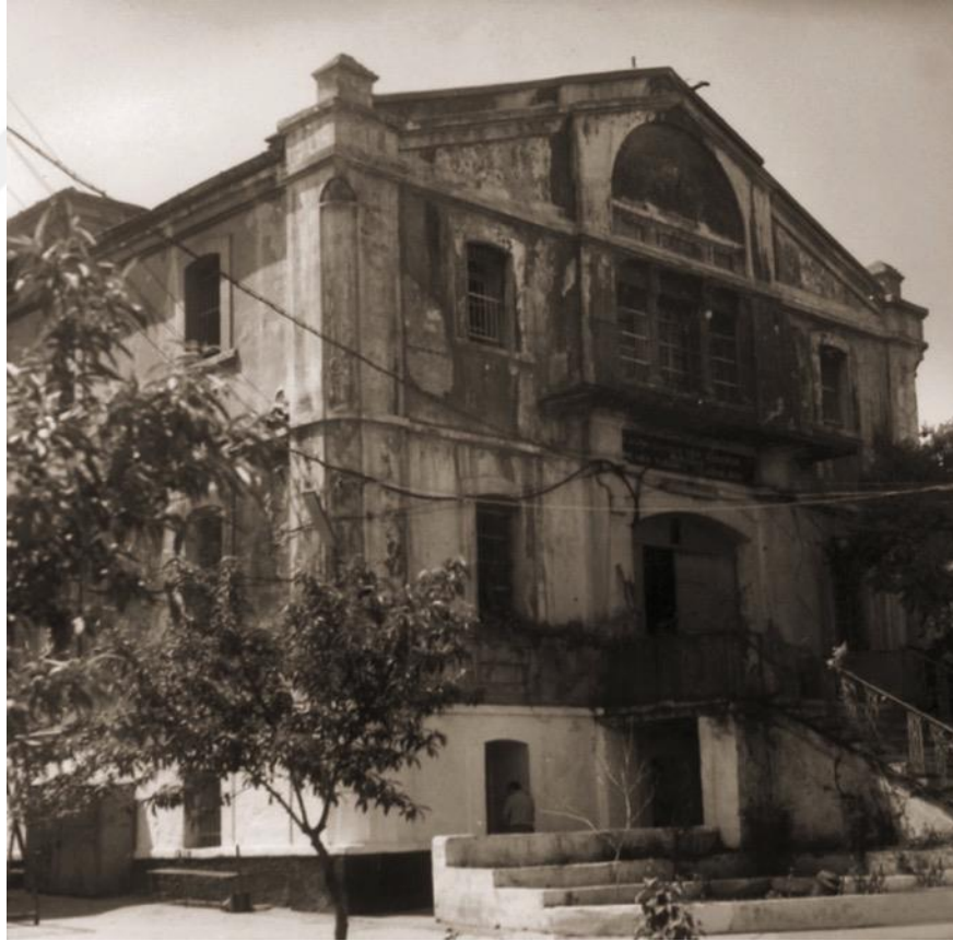
Resim 4.118. Hapishane Binasının Kuzeydoğudan Giriş Cehhesi (Kaynak: www.bursakutuphanesi . Erişim Tarihi: 24.8.2018)
