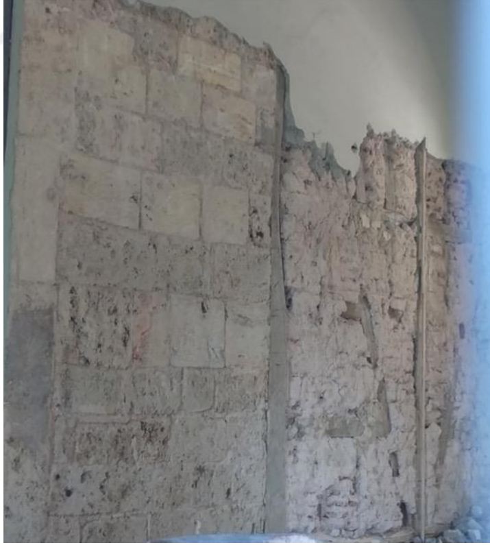
Resim 4.170. Emir Sultan Türbesi Batı Odası Küfeki Taş-Tuğla Duvar Örgüsü, Ahşap Çapraz Ve Dikmeler (Foto: H.Gürsel Bilmiş-2019)
