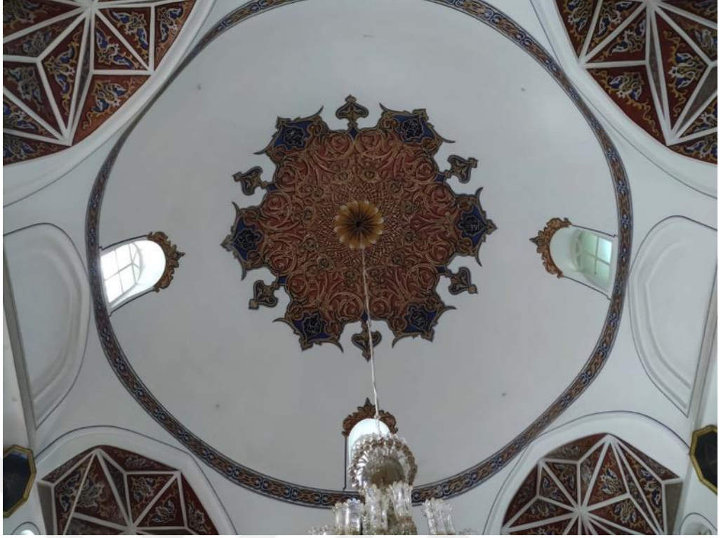
Resim 4.172. Orhan Camii Mihrap Önu Kubbesi Mukarnaslı Köşe Trompları (Foto: H.Gürsel Bilmış-2019)
