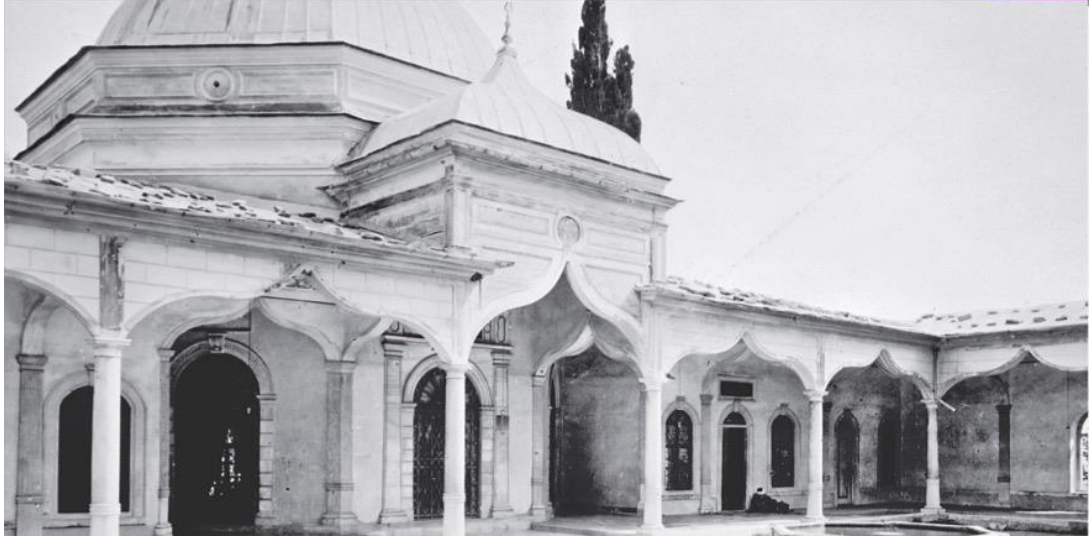
Resim 4.161. 19. Yüzyıl Sonlarına Doğru Emir Sultan Türbesi ve Revaklar. Muhtemelen 1894 (Kaynak: B.B.B. Kent Belleği)
