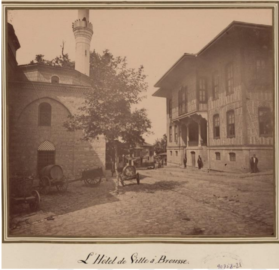
Resim 4.35. Fotoğrafında Otel Olarak Yanlış Nitelendirilen Belediye Binasının Güneybatıdan Görünüşü (Kaynak: İÜNEK-90758/21)
