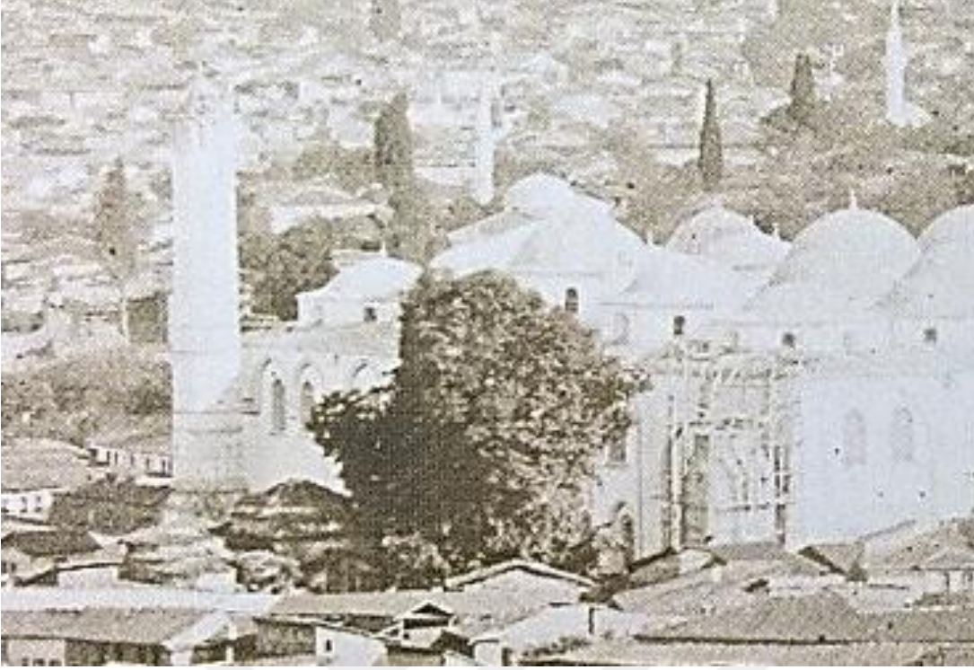
Resim 4.196. Ulucami'nin İnşa Halindeki Batı Minaresi İle Şerefeye Kadar Yıkık Doğu ('Güdük') Minare. Foto: Moustier-1862 (Kaynak: N.D. Bursa Fotoğrafları, no:32)
