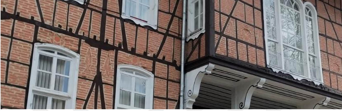
Resim 4.42. Belediye Binasının Batı Cephesinde Pencere Üzerleri Ve Aralarındaki Bezemeler. (Foto: H.Gürsel Bilmiş-2019)
