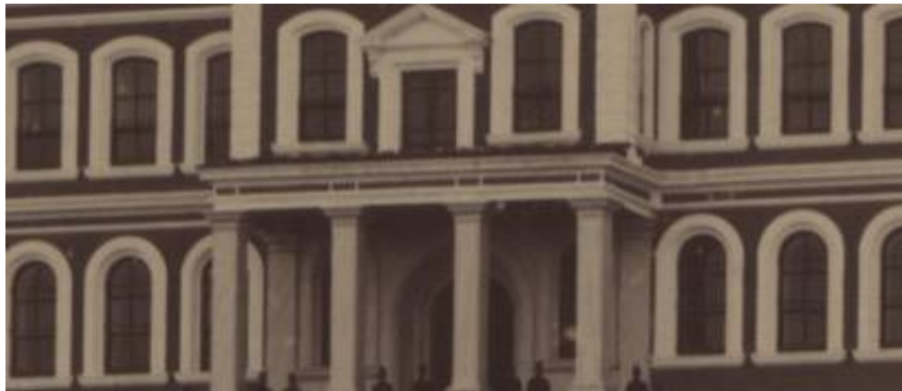
Resim 4.51. Bursa Mekteb-i İdâdi-i Askerisinin Parapet Ve Kitabesiz Girişi (Kaynak: İÜNEK-90852/33 tarihsiz)
