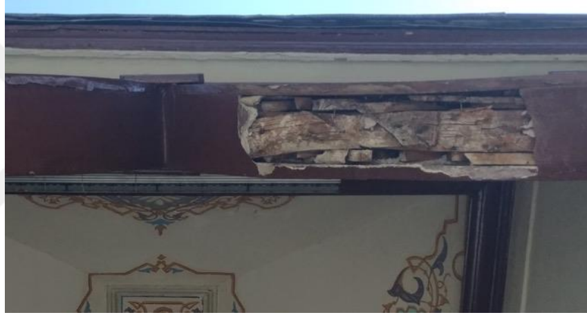
Resim 4.162. Emir Sultan Türbesi Batı Girişindeki Revakta Ahşap Basık Kaş Kemer İç Dolgusu (Foto: H.Gürsel Bilmiş-2019)
