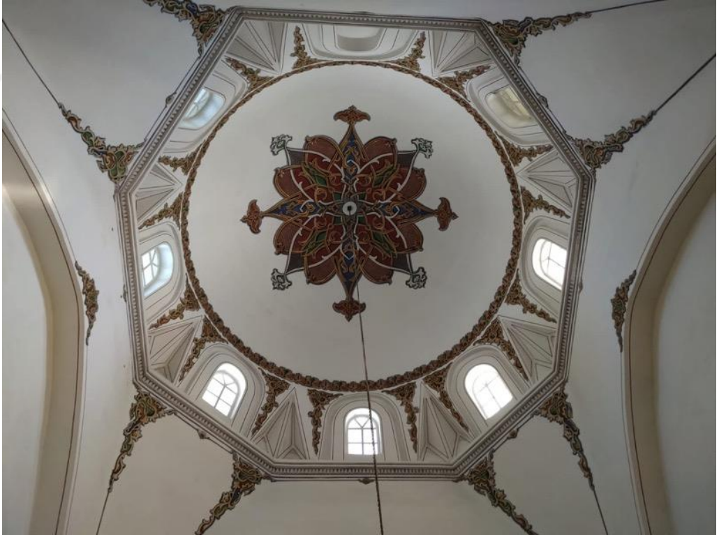
Resim 4.173. Orhan Camiinde Kuzeydeki Kubbenin Türk Üçgenleri (Foto: H.Gürsel Bilmış-2019)
