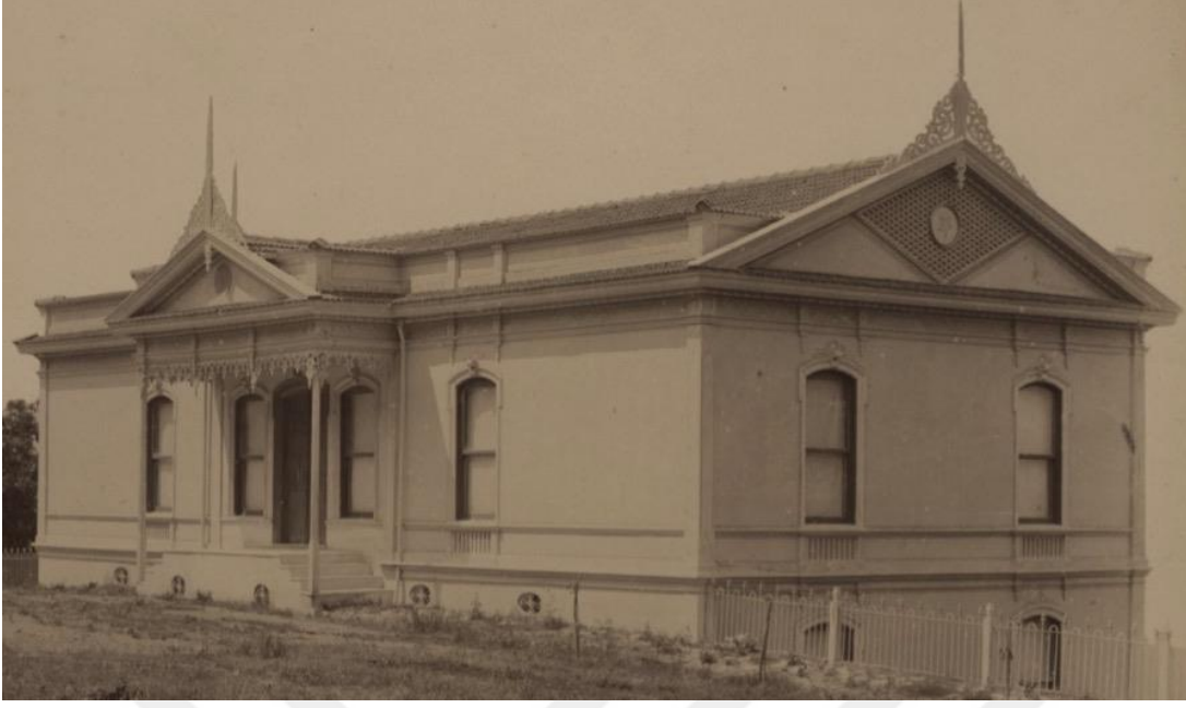
Resim 4.1. Kasrın Güneydoğu'dan Görünüşü. Muhtemelen 1890 Cıvarı. (Kaynak: İÜNEK-779-28-0023)
