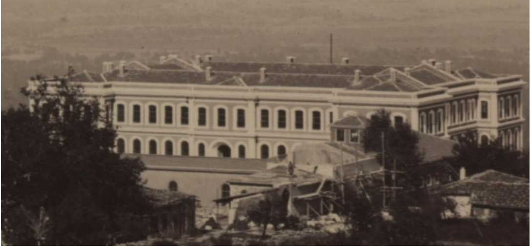
Resim 4.57. Bursa Mekteb-i İdâdi-i Askerisi Güneyinde İnşası Devam Eden Hamam. Hamamın Yanında Henüz Tek Katlı B blok. Muhtemelen 1892-93. (Kaynak: İÜNEK-90852/0035)
