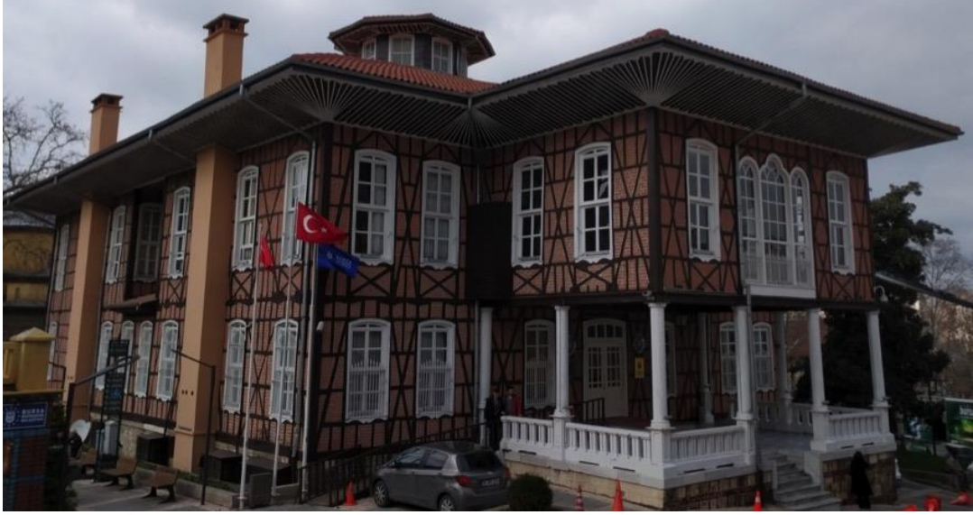
Resim 4.40. Belediye Binasının Güneydoğudan Görünüşü. Güney Girişi, Genişletilen Salon Ve Çatıdaki Aydınlık Feneri (Foto: H.Gürsel Bilmiş-2019)
