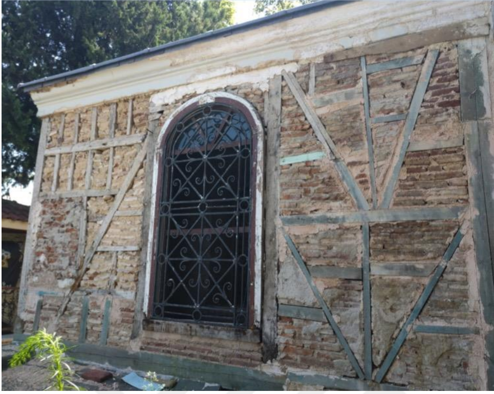
Resim 4.169. Emir Sultan Türbesi Doğu Odası Tuğla Duvar Örgüsü, Ahşap Hatıl, Çapraz Ve Dikmeler İle Ahşap Pencere Söveleri (Foto: H.Gürsel Bilmiş-2019)
