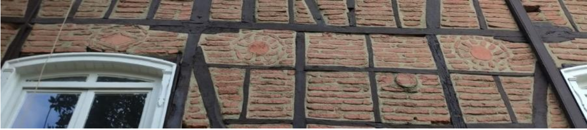
Resim 4.43. Belediye Binasının Kuzey Cephesinde Pencere Üzerlerindeki Bezemeler. (Foto: H.Gürsel Bilmiş-2019)
