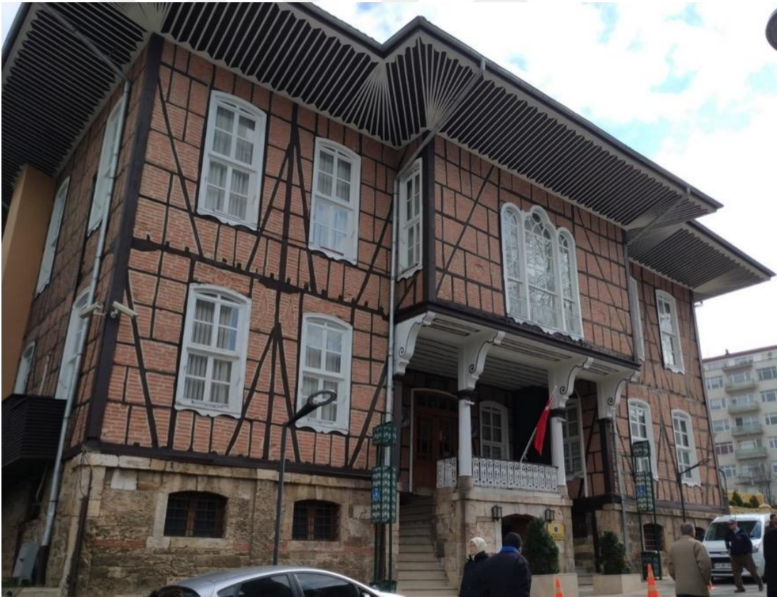
Resim 4.41. Belediye Binasının Batı Cephesinden Yüksek Bodrum Ve Zemin Kat Girişi (Foto: H.Gürsel Bilmiş-2019)
