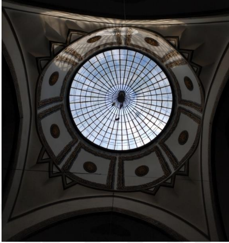
Resim 4.205. Ulucami'nin Mihrap-Taçkapı Ekseninde Üçüncü Sırada Bulunan Üstü Açık Kubbesi. (Kaynak: H.Gürsel Bilmiş-2019)
