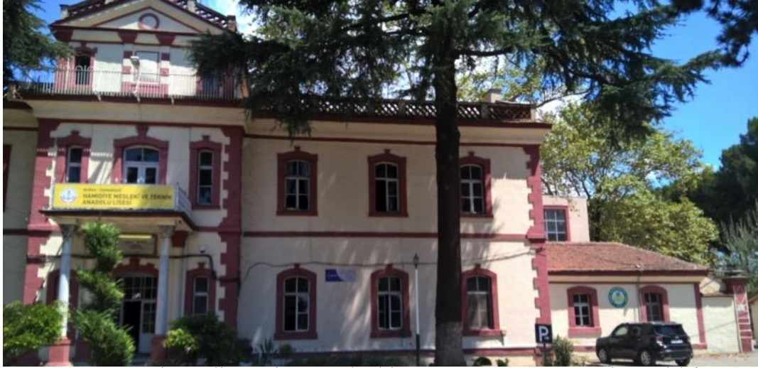
Resim 4.72. Hüdavendigâr Ziraat Mektebi Ana Binası Güneye Bakan Girişin Sağ Cephesi. (Foto: H.Gürsel Bilmiş-2018)
