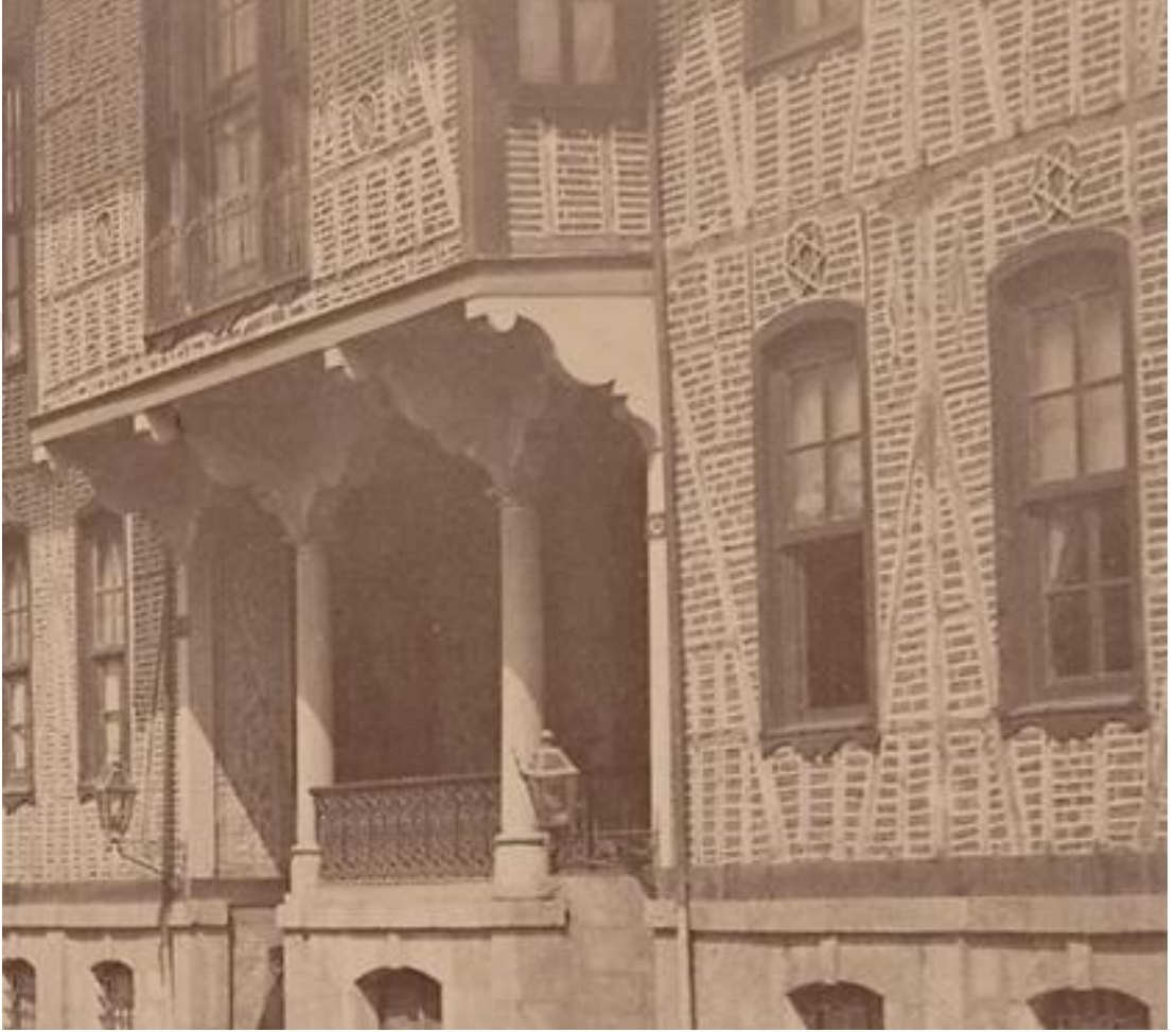
Resim 4.37. Belediye Binası Batı Cephe Detayı (Kaynak: İÜNEK-90758/21)
