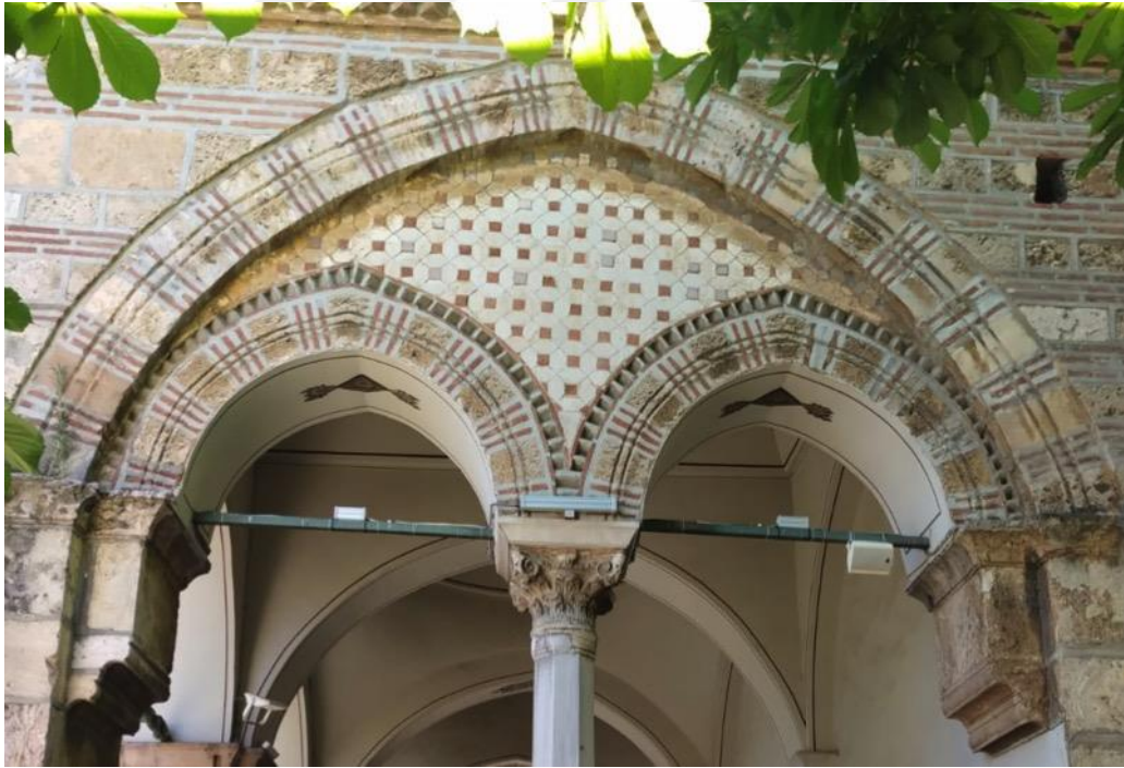
Resim 4.175. Orhan Camii Yan Revaklarda Devşirme Sekizgen Sütun Başlıkları Üzerine Taşınan Çift Kemer Ve Alınlıklardaki Tuğla Bezeme (Foto: H.Gürsel Bilmiş-2019)
