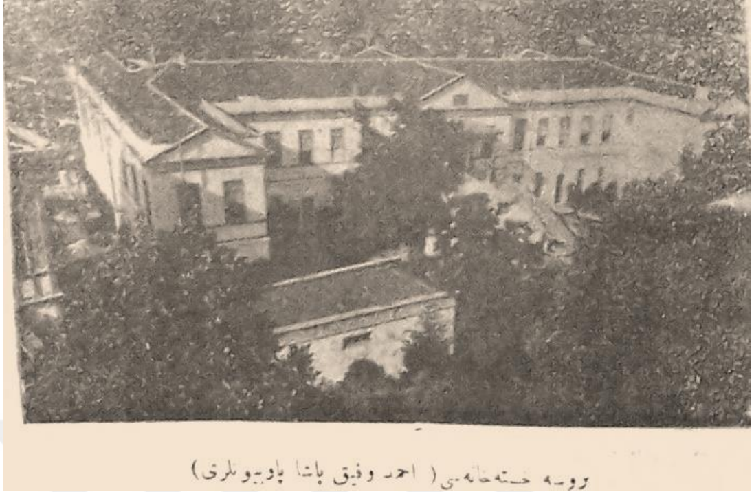
Resim 4.22. Gureba Hastanesinin Güney Cephesinden Görünüşü. Tarihsiz. (Kaynak: Bursa Vilayeti Coğrafyası, s.143)
