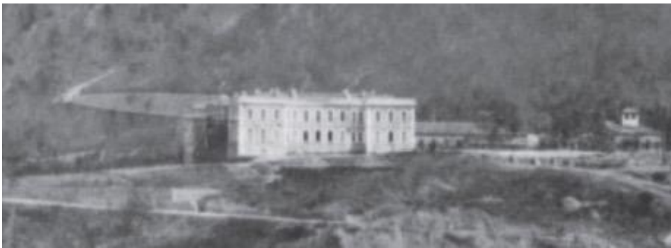
Resim 4.54. Bursa Mekteb-i İdâdi-i Askerisi Arkasında Devam Eden Depo, Yemekhane Ve Hamam Birimleri İnşaatları.(Kaynak: B.B.B. Kent Belleği. Muhtemelen 1891-1892)
