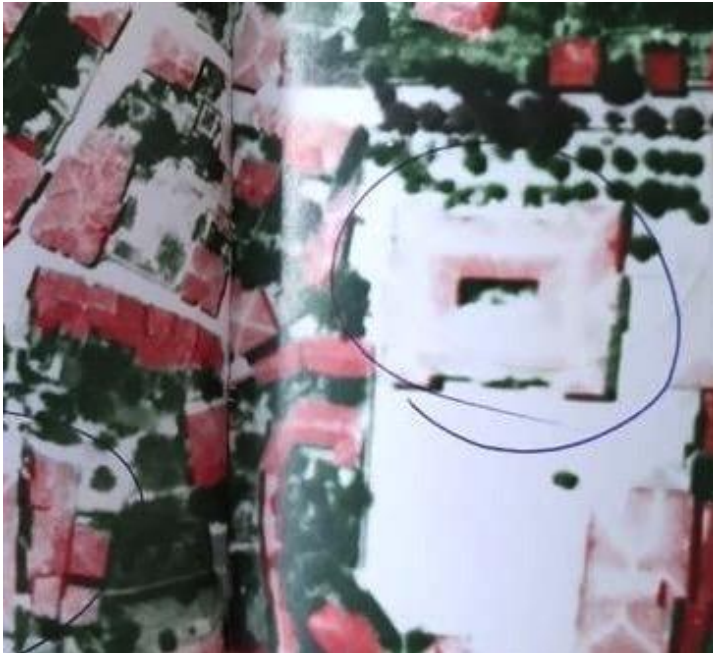
Resim 4.84. 1939 Yılına Ait Bir Hava Fotoğrafında Erkek Lisesi Binaları (Kaynak: B.B.B. Kent Belleği)
