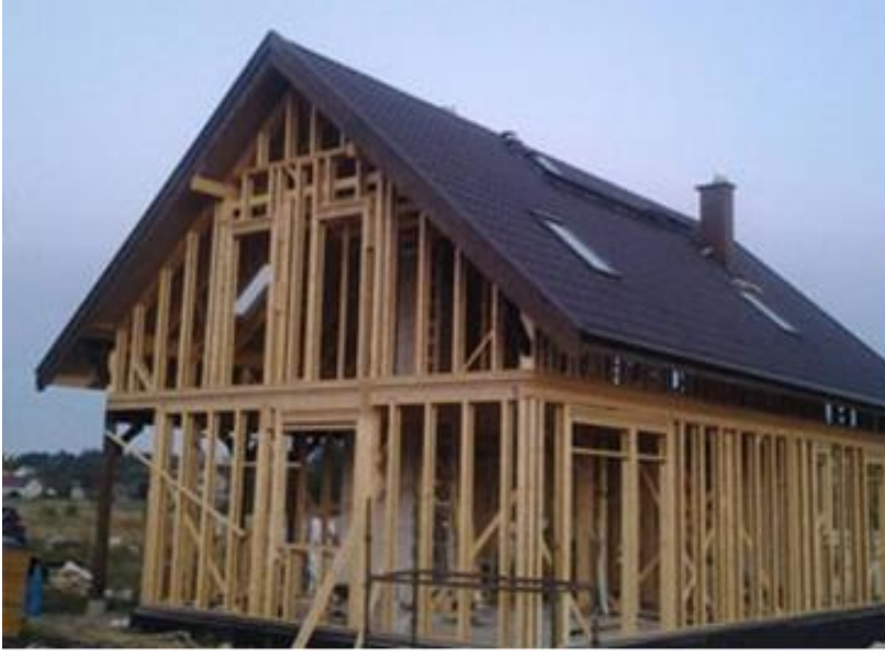
Şekil 2-1 Ahşap Karkas Sistem (URL 1)
