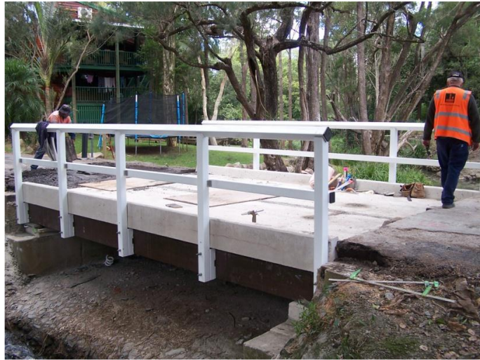
Şekil 2.4: Brisbane Belediyesi'nin yaptırdığı geopolimer tabliyeli köprü [13].
