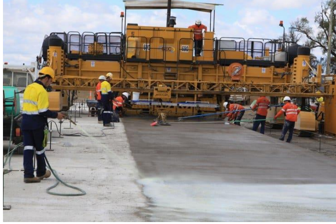
Şekil 2.1: Brisbane West Wellcamp Havalimanı kaplaması geopolimer beton imalatı [11].
