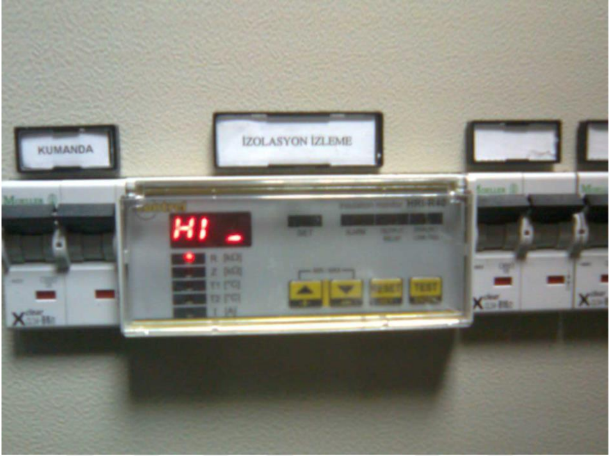
Şekil 3.12: İzolasyon izleme cihazı [29].
