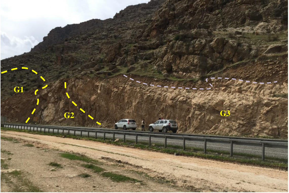
Şekil 2.5: Yamaç molozu (G1), zayıf kireçtaşı (G2) ve sağlam kireçtaşı (G3) (batı bakışlı).
