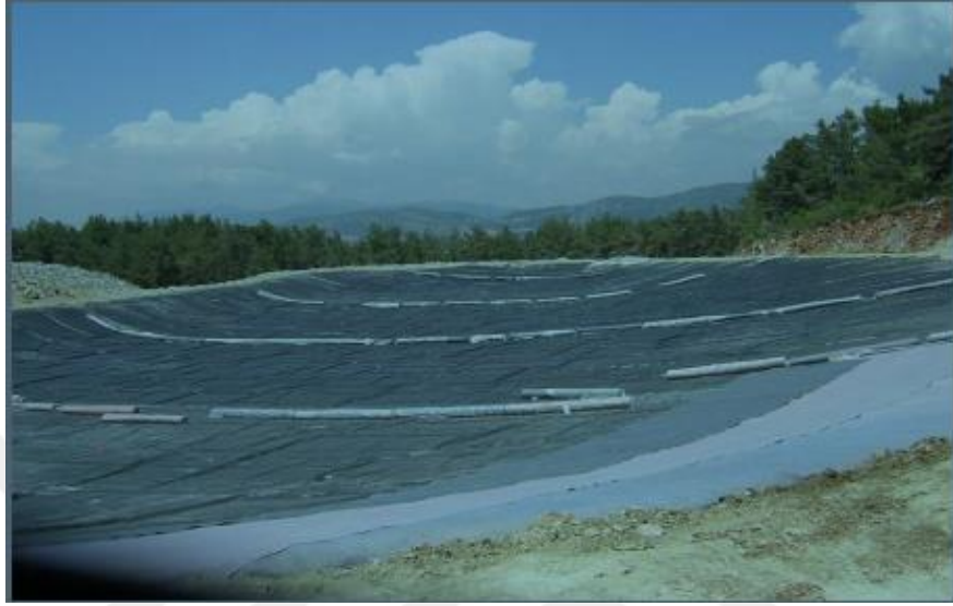
Şekil 2.4: Geomembran serilmesi.
