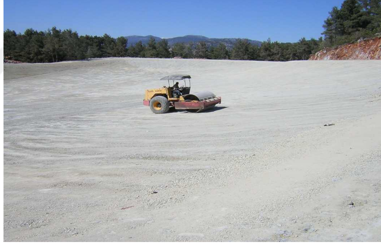
Şekil 2.3: Kil geçirimsizlik tabakasının sıkıştırılması işlemi.
