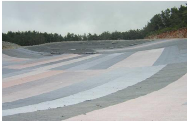
Şekil 2.5: Geotekstil serilmesi.
