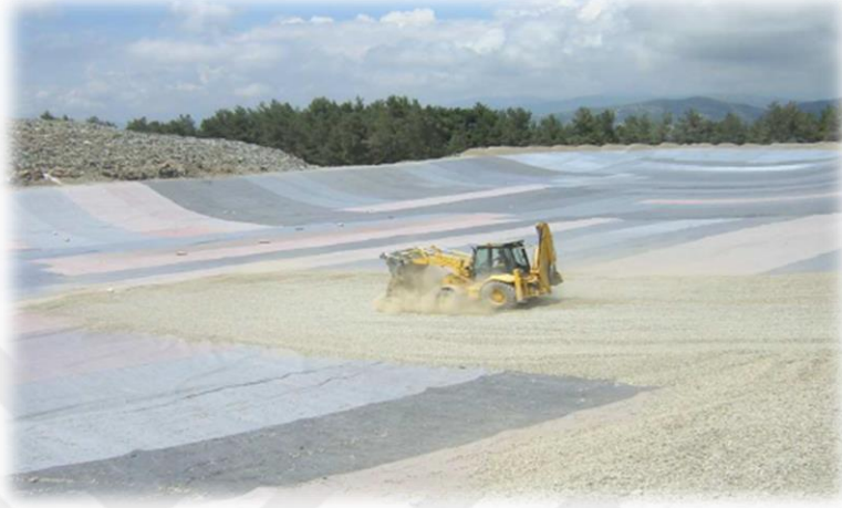
Şekil 2.6: Drenaj için filtre çakılı serilmesi.
