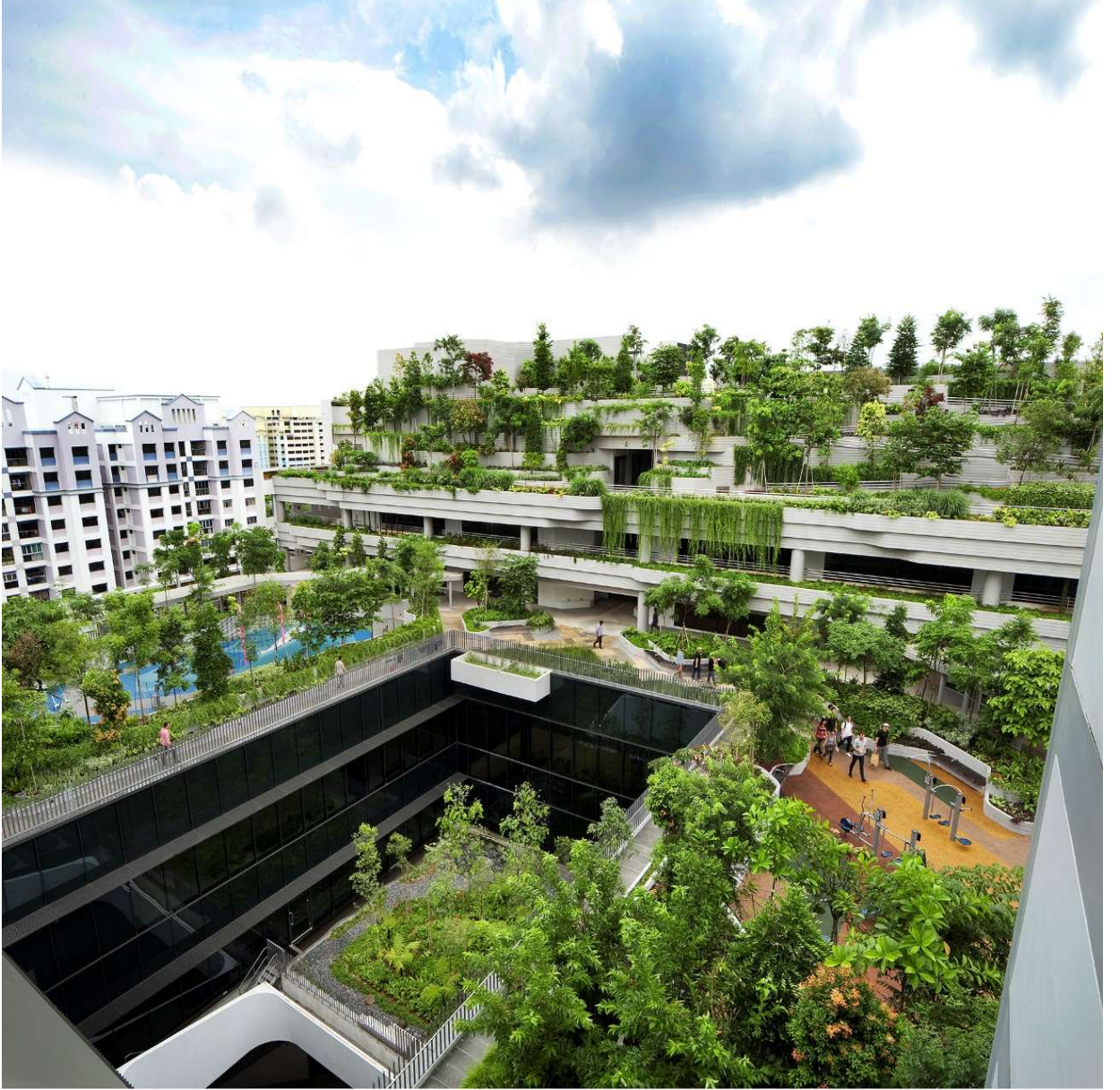
Şekil 4.12: Singapur 2017 yılı “Skyrise Greenery Awards” yarışması “olağanüstü” dalı ödül alan proje “Kampung Admiralty” Deniz Kuvvetleri Komutanlığı Binası. Patrick Bingham – Hall and Ramboll Studio Dreiseitl Singapore Pte Ltd
