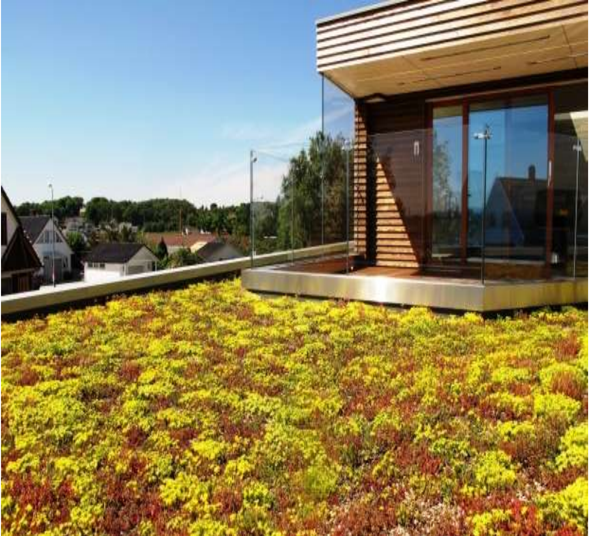
Şekil 2.1: Ekstensif Yeşil Çatı Örneği ( https://www.isola.com/products-2/roof/green-roof/flat-green-roofs-4/ )
