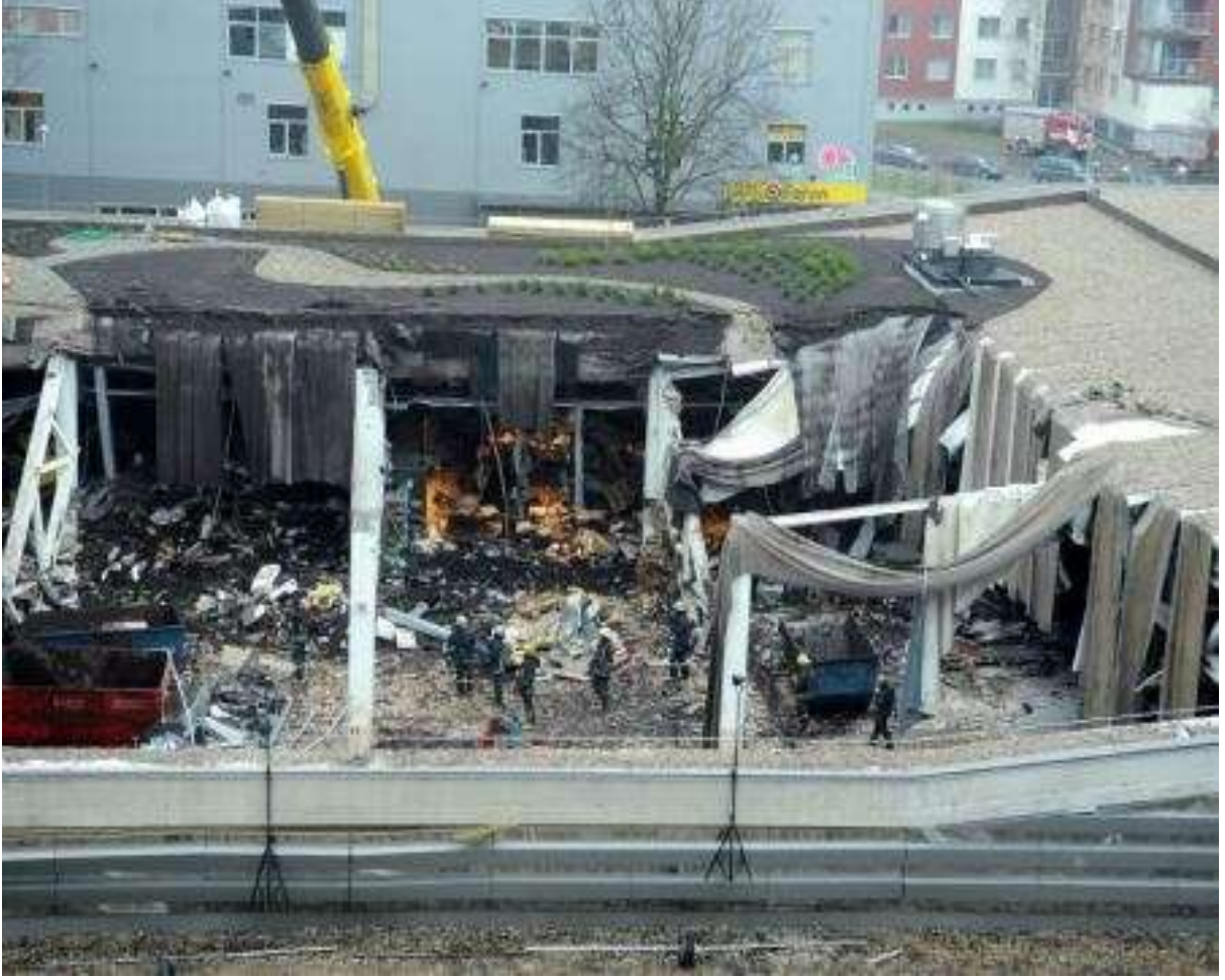
Şekil 2.3: Letonya’da 54 kişinin öldüğü yeşil çatı çökme kazası sonucu oluşan durum ( http://www.greenrooftechology.com/green-roof-blog/green-roof-collapse-in-latvia )
