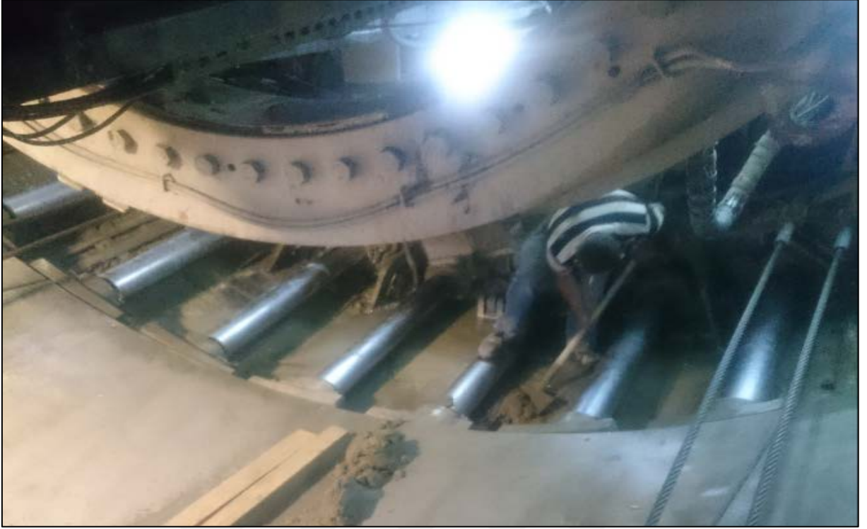
Şekil 2. 3: Tek Kalkanlı Bir TBM'e Ait İtme Pistonları
