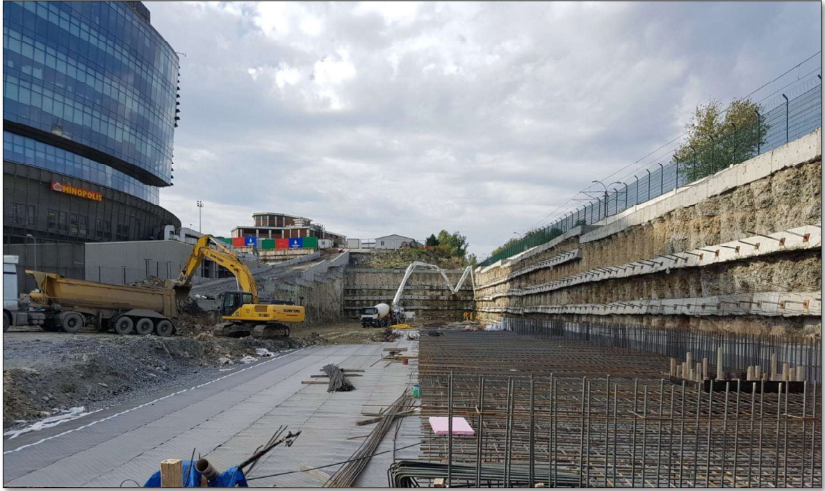
Şekil 3.2: İksa çalışmasından bir görünüş.
