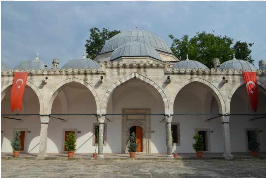
Şekil 6.16 Şehzade Medresesi Dershane Revakı (Özyürek, K. 2019).
