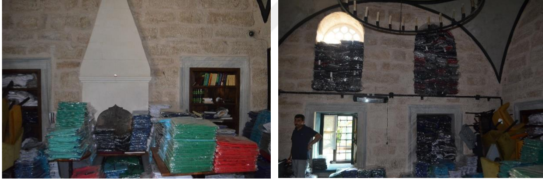
Şekil 7.47 Kuyucu Murad Paşa Sıbyan Mektebi Kuzey ve Batı Duvarları (Özyürek, K. 2019)
