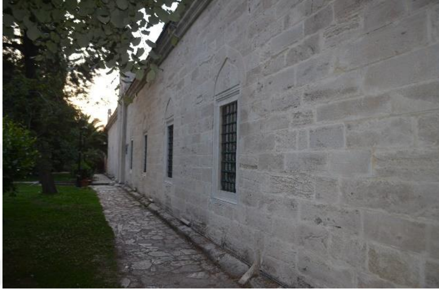
Şekil 6.11 Şehzade Medresesi Batı (giriş) Cephesi (Özyürek, K. 2019).
