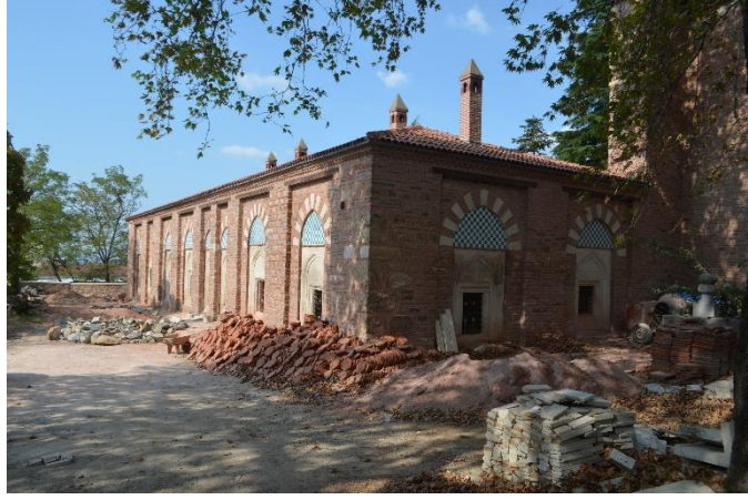
Şekil 4.17 Bursa Yeşil Medrese Güneydoğudan Görünümü (Özyürek, K. 2019)
