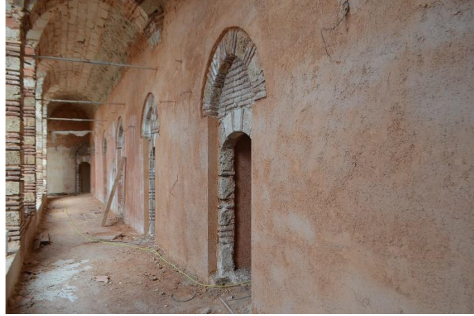
Şekil 4.14 Yıldırım Medresesi Batı Revakı (Özyürek, K. 2019).
