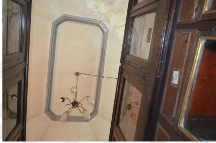
Şekil 8.58 Nuruosmaniye Kütüphanesi Kitap Deposu Aynalı Tonozu (Özyürek, K. 2019).
