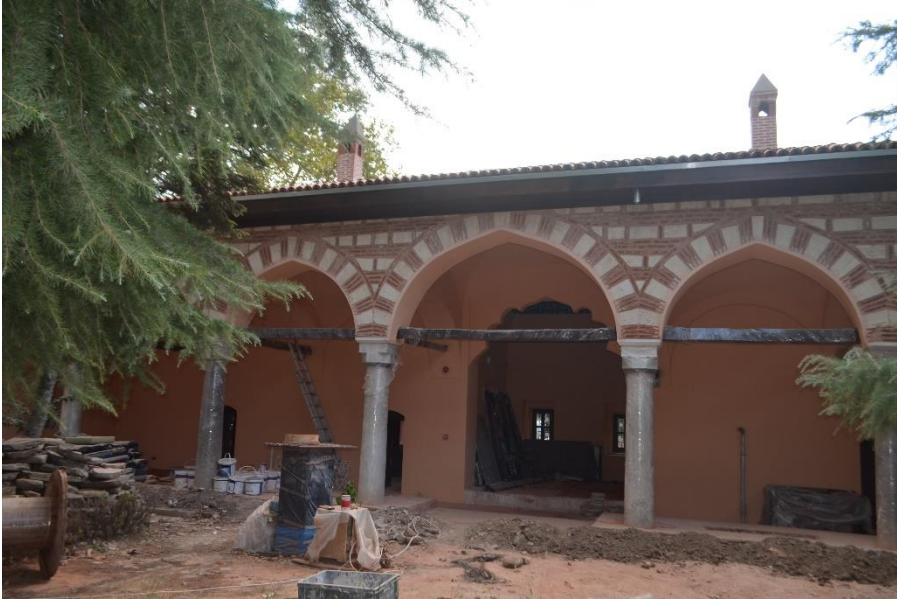
Şekil 4.19 Bursa Yeşil Medrese Avlusu Batı Revak Cephesi (Özyürek, K. 2019)
