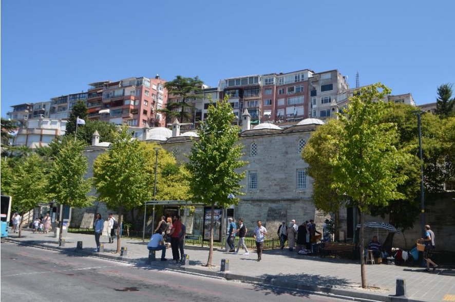
Şekil 6.28 Üsküdar Mihrimah Sultan Medresesi Kuzey Cephesi (Özyürek, K. 2019).
