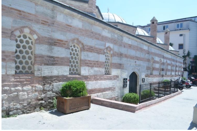
Şekil 6.141 Kılıç Ali Paşa Medresesi Kuzey (Giriş) Cephesi (Özyürek, K. 2019).
