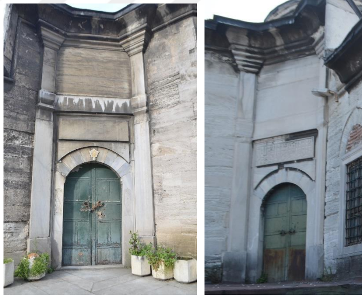
Şekil 8.52 Nuruosmaniye Kütüphanesi Güneybatı ve Kuzeybatı Kapıları (Özyürek, K. 2019).
