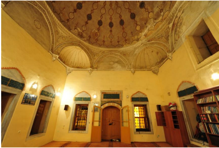
Şekil 8.11 Damat İbrahim Paşa Kütüphanesi Restorasyon Öncesi İç Mekânı. 672
