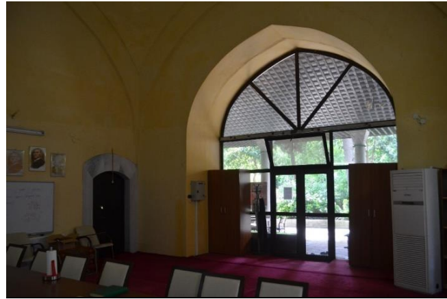
Şekil 5.42 İstanbul II. Bayezid Sıbyan Mektebi Sofa-Eyvan Mekânı Kemerli Açıklığı (Özyürek, K. 2019).
