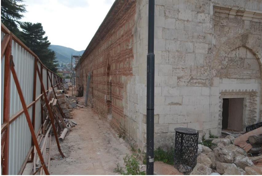
Şekil 4.11 Bursa Yıldırım Medresesi Doğu Cephesi (Özyürek, K. 2019).
