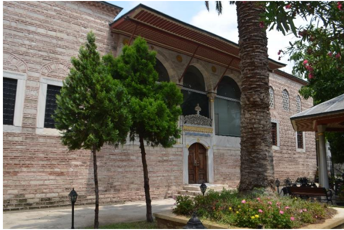
Şekil 7.83 Feyzullah Efendi Medresesi Dershane ve Kütüphane Hacimlerinin Avlu (Giriş) Cephesi (Özyürek, K. 2019)
