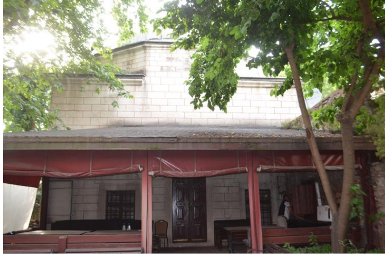
Şekil 6.24 Şehzade Sıbyan Mektebi Giriş Cephesi (Özyürek, K. 2019).
