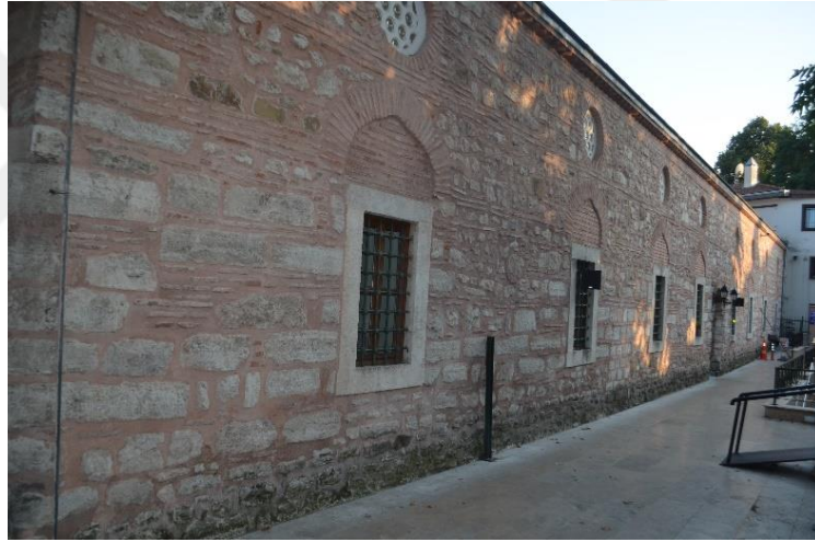
Şekil 6.41 Beşiktaş Sinan Paşa Medresesi Kuzey Cephesi (Özyürek, K. 2019).
