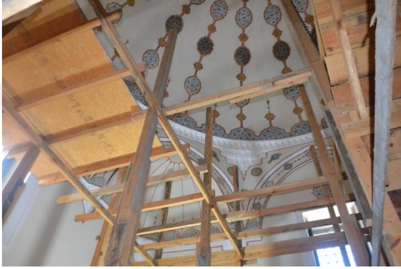
Şekil 8.10 Damat İbrahim Paşa Külliyesi Kütüphanesi İç Mekânı (Özyürek, K. 2019).
