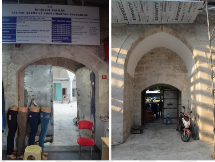
Şekil 7.38 Kuyucu Murad Paşa Medresesi Avlu Girişi ve Giriş Eyvanı (Özyürek, K. 2019).
