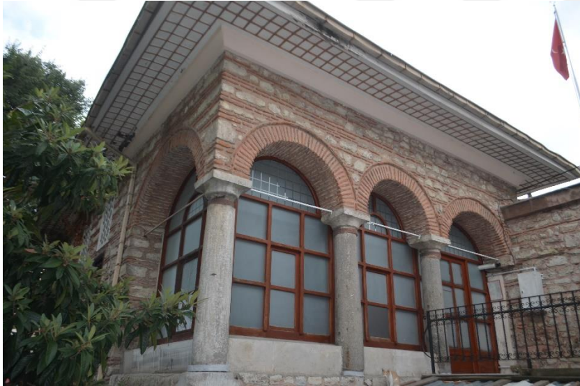
Şekil 8.61 Zeynep Sultan Sıbyan Mektebi Kuzey Revaklı Giriş Cephesi (Özyürek, K. 2019).
