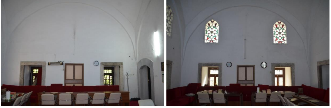
Şekil 5.45 İstanbul II. Bayezid Sıbyan Mektebi Kışlık Dershane Kuzey ve Batı Duvarları (Özyürek, K. 2019).
