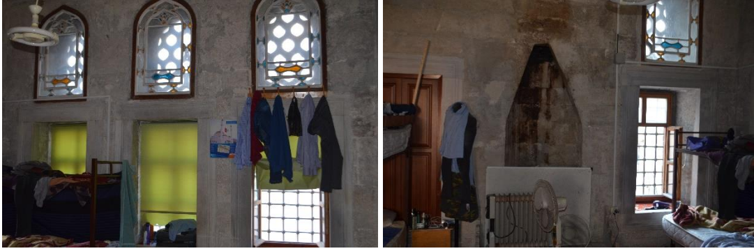
Şekil 8.22 Ahmediye Kütüphanesi Kuzey ve Batı Duvarları (Özyürek, K. 2019).
