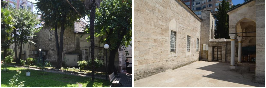
Şekil 6.29 Üsküdar Mihrimah Sultan Medresesi Doğu ve Batı (giriş) Cepheleri (Özyürek, K. 2019).
