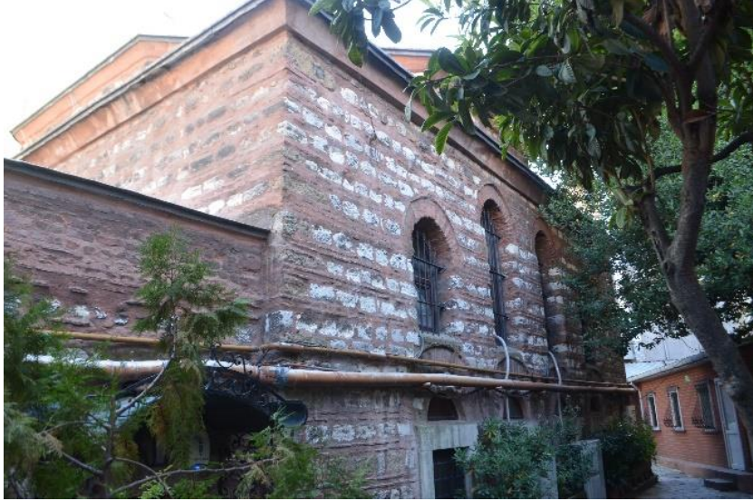
Şekil 8.74 Dershane Mescit Hacmi Kuzeybatı Köşesinden Görünüşü (Özyürek, K. 2019).
