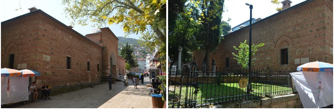
Şekil 4.25 Muradiye Medresesi Kuzey (Giriş) ve Doğu Cepheleri (Özyürek, K. 2019).
