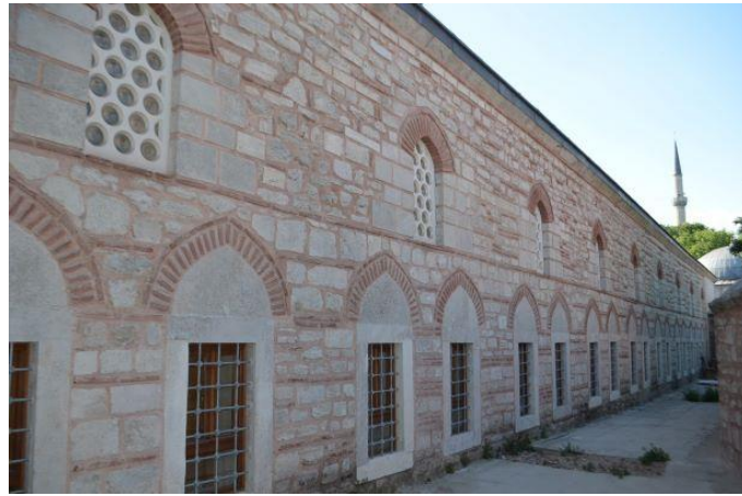
Şekil 6.110 Eyüp Sokollu Mehmed Paşa Medresesi Doğu Cephesi (Özyürek, K. 2019).
