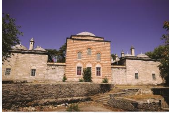
Şekil.5.32 II. Bayezid Medresesi Batı Cephesi ( www.gezgindergi.com ).
