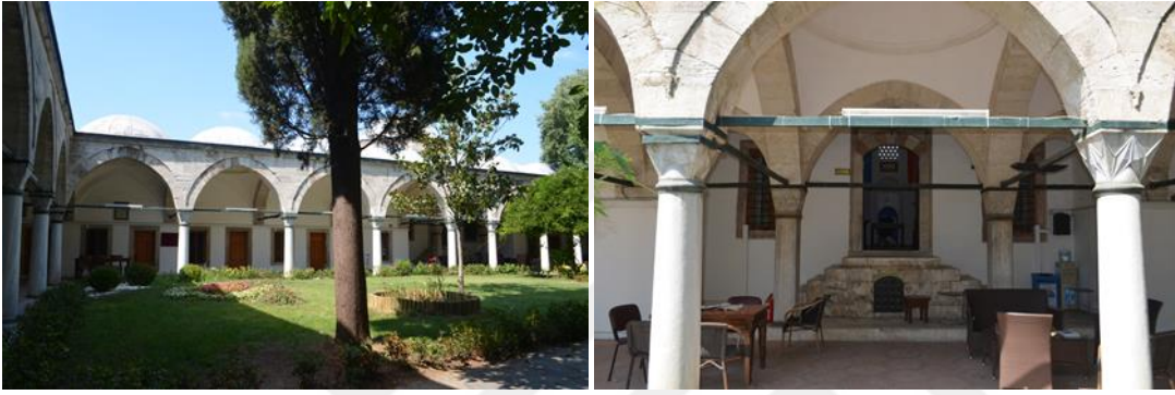
Şekil 6.114 Atik Valide Medresesi Revak Cephesi ve Dershane Revakı (Özyürek, K. 2019).
