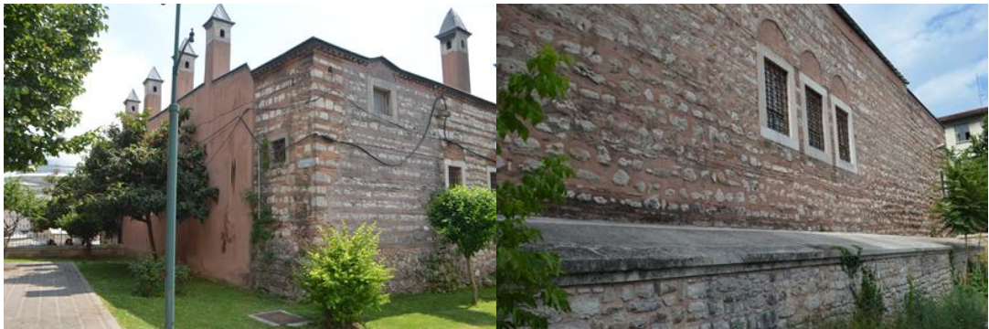
Şekil 8.31 Seyyid Hasan Paşa Medresesi Doğu ve Güney Cepheleri (Özyürek, K. 2019).
