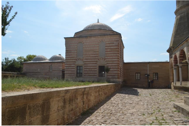
Şekil 6.96 Selimiye Darülkurra Medresesi Batı ve Güney Cepheleri (Özyürek, K. 2019).
