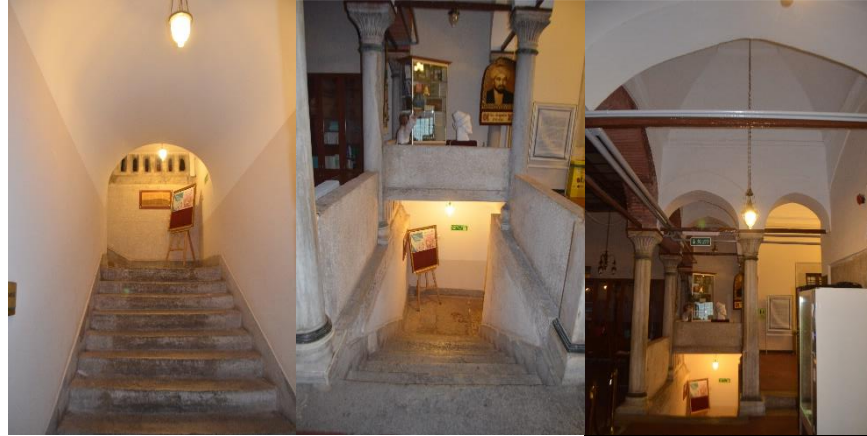
Şekil 8.34 Seyyid Hasan Paşa Medresine Ulaşım Sağlayan Altta Tonozlu Üstte Arkadlı Merdiven Sistemi (Özyürek, K. 2019).
