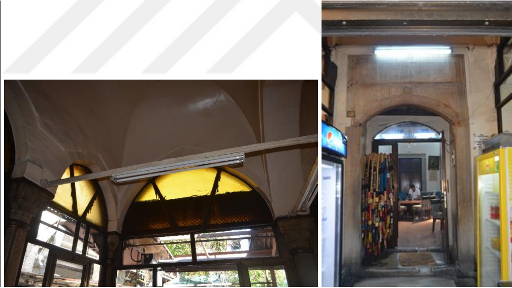
Şekil 7.95 Çorlulu Ali Paşa Medresesi Dershane Giriş Revakı ve Girişi (Özyürek, K. 2019)
