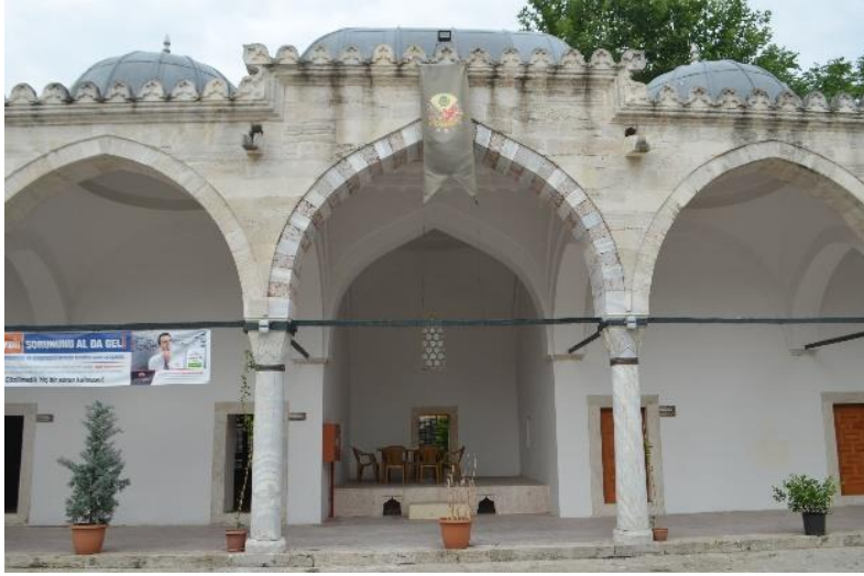
Şekil 6.15 Şehzade Medresesi Eyvanı ve Revakı (Özyürek, K. 2019).
