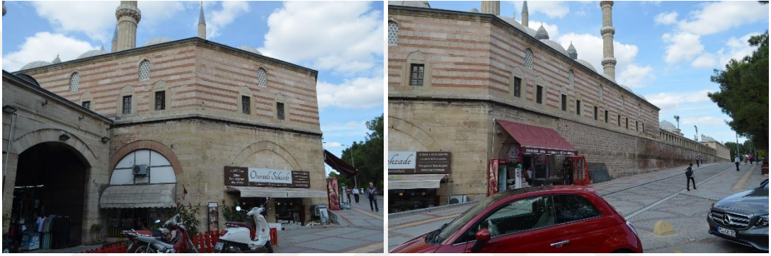
Şekil 6.95 Selimiye Darülkurra Medresesi Batı ve Güney Cepheleri (Özyürek, K. 2019).
