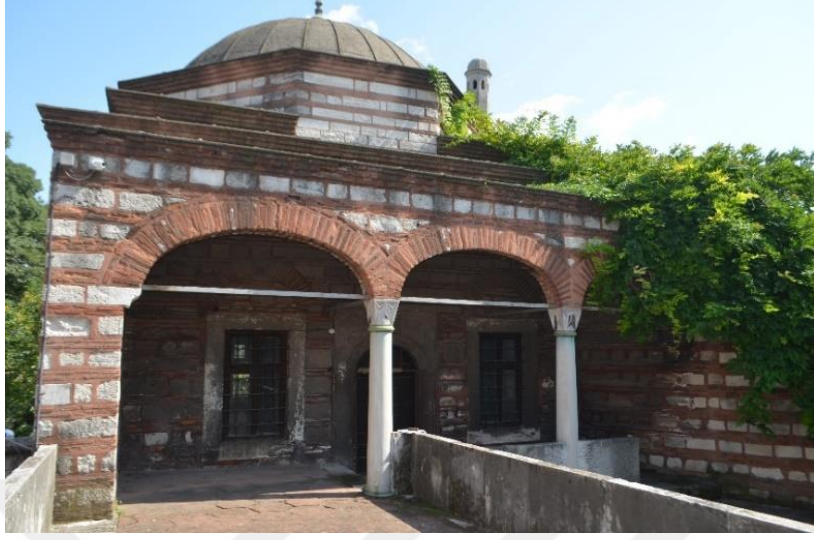
Şekil 7.77 Amcazade Külliyesi Kütüphanesi Kuzey Cephesi (Özyürek, K. 2019)
