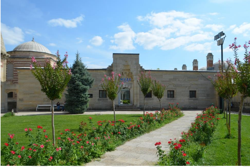
Şekil 6.97 Selimiye Darülcürra Medresesi Kuzey (Giriş) Cephesi (Özyürek, K. 2019).
