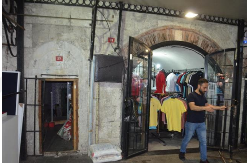
Şekil 7.45 Sıbyan Mektebi Girişi ve Mektebin Altındaki Tonozlu Dükkân Hacmi (Özyürek, K. 2019).
