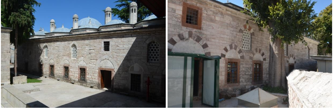
Şekil 6.1 Haseki Medresesi Batı ve Doğu Cepheleri (Özyürek, K. 2019).
