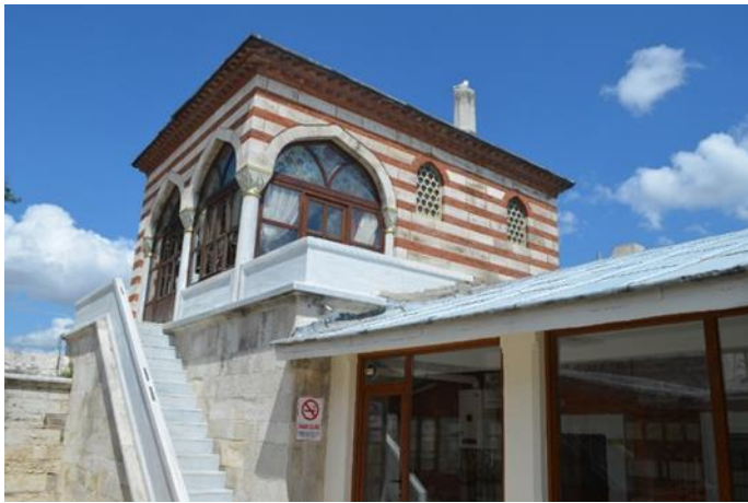
Şekil 6.66 Darülhadis Medresesi'nin Dershanesi, Medrese Avlusundan Görünüm (Özyürek, K. 2019).
