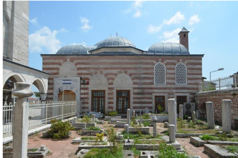
Şekil 6.82 Edirnekapı Mihrimah Sultan Sıbyan Mektebi Kuzey Cephesi (Özyürek, K. 2019).
