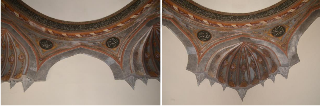
Şekil 8.40 Dershane-Mescit Mekanı Kalemîşi Süslemeleri (Özyürek, K. 2019).
