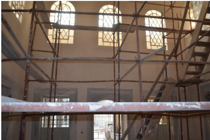
Şekil 7.42 Kuyucu Murad Paşa Medresesi Dershane-Mescit Mekânı Giriş Duvarı (Özyürek, K. 2019)
