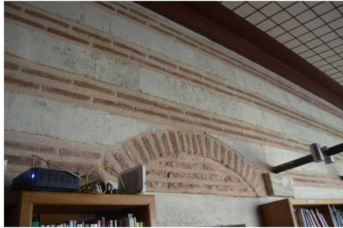
Şekil 6.149 Şemsi Paşa Medresesi Hücre Revak Cephesi (Özyürek, K. 2019).
