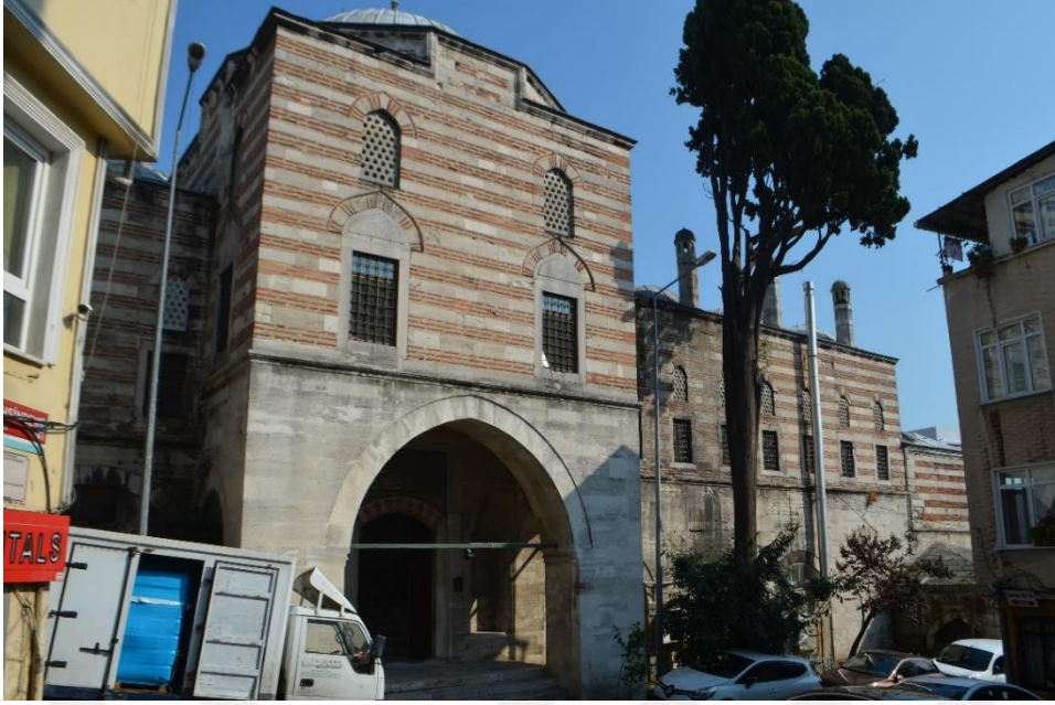
Şekil 6.126 Kadırga Sokollu Mehmed Paşa Medresesi Kuzey Cephesi (Özyürek, K. 2019).
