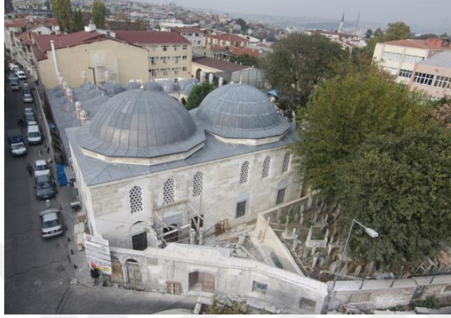
Şekil 7.13 Ekmekçizade Külliyesi'nin Kible Yönünden Görünümü. 533
