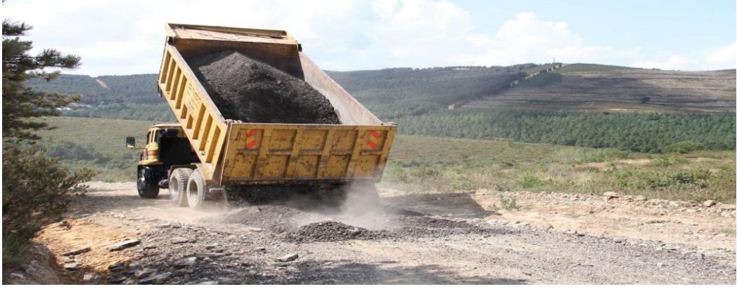
Şekil 3.22. Aydos yolunda asfalt serme çalışmaları ( https://www.kartal24.com )
