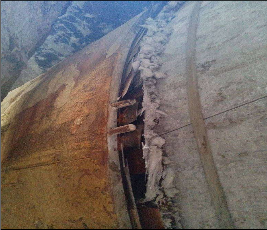
Resim 2-3: TBM kalkanı, enjeksiyon hatları, kuyruk fırçası ve mevcut boşluk
