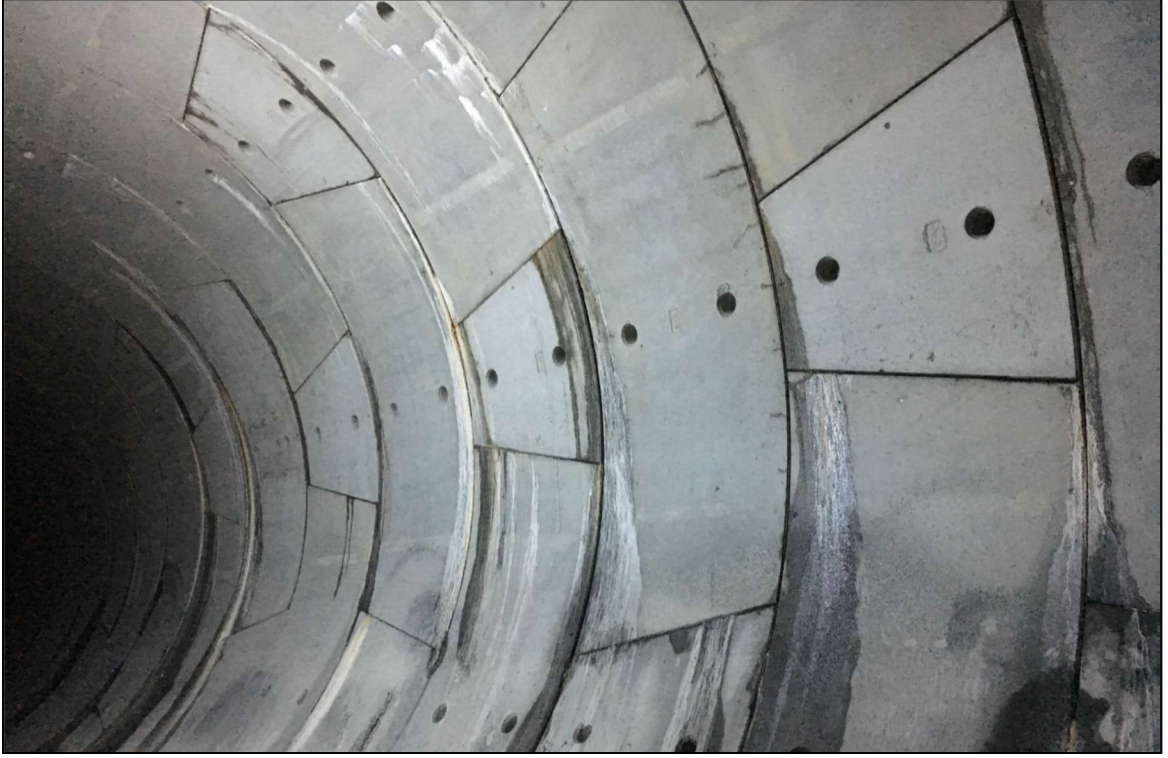
Resim 4-1: Veysel Karani ile Akşemsettin İstasyonları arası Km: 12+320 –Km: 13+500 arası su geliri görünümü
