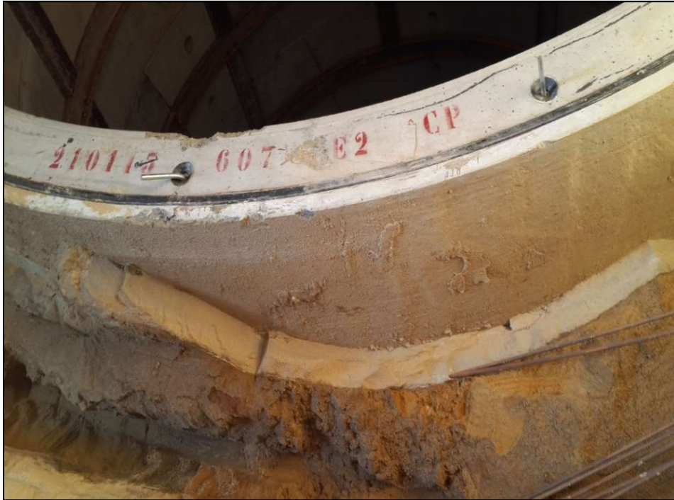
Resim 2-5: Segment çevresi ve zemin arasını doldurmuş enjeksiyon harcı görünümü
