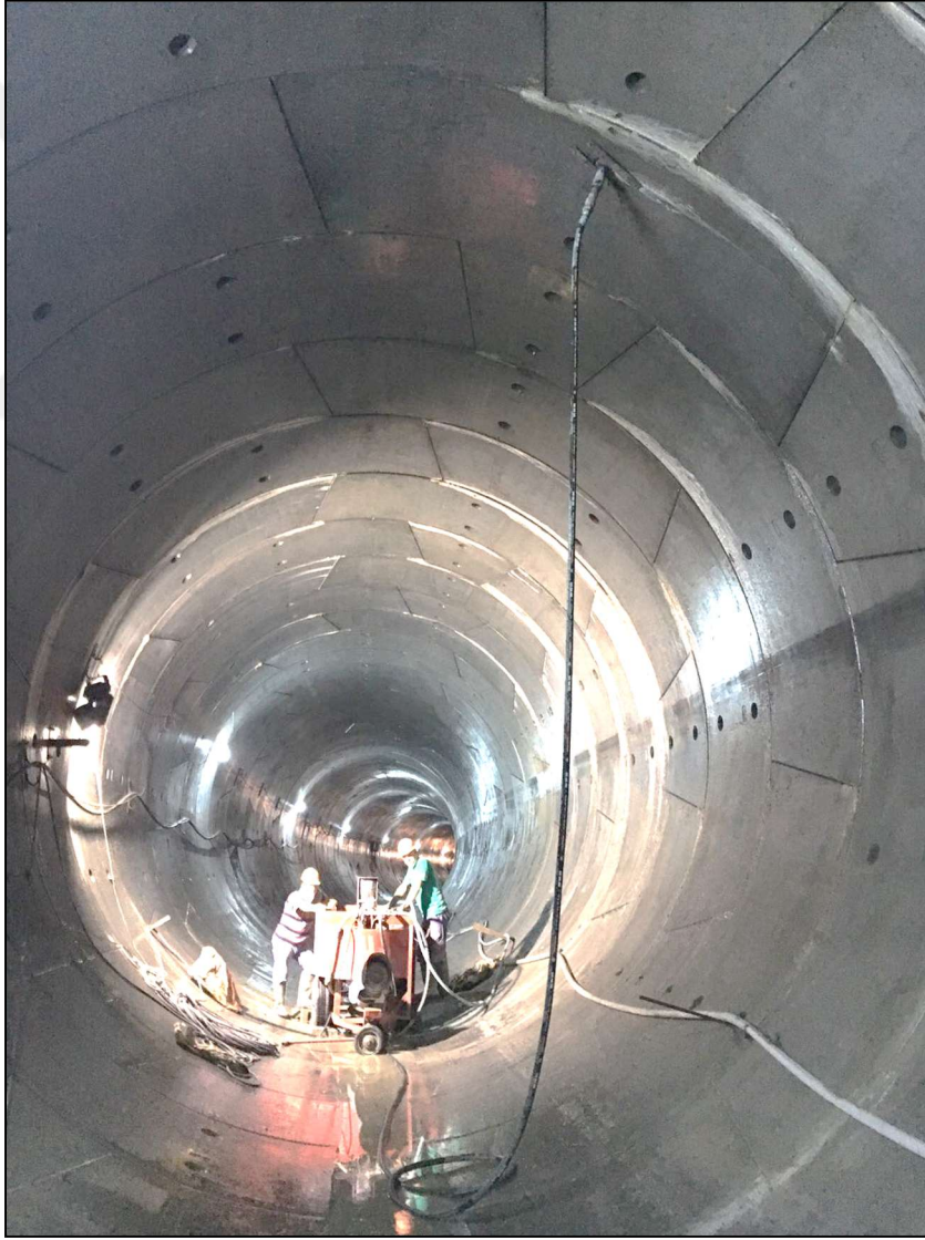
Resim 2-6: Mecidiyeköy-Mahmutbey metrosu TBM tünellerinde çimento-su enjeksiyonu uygulaması
