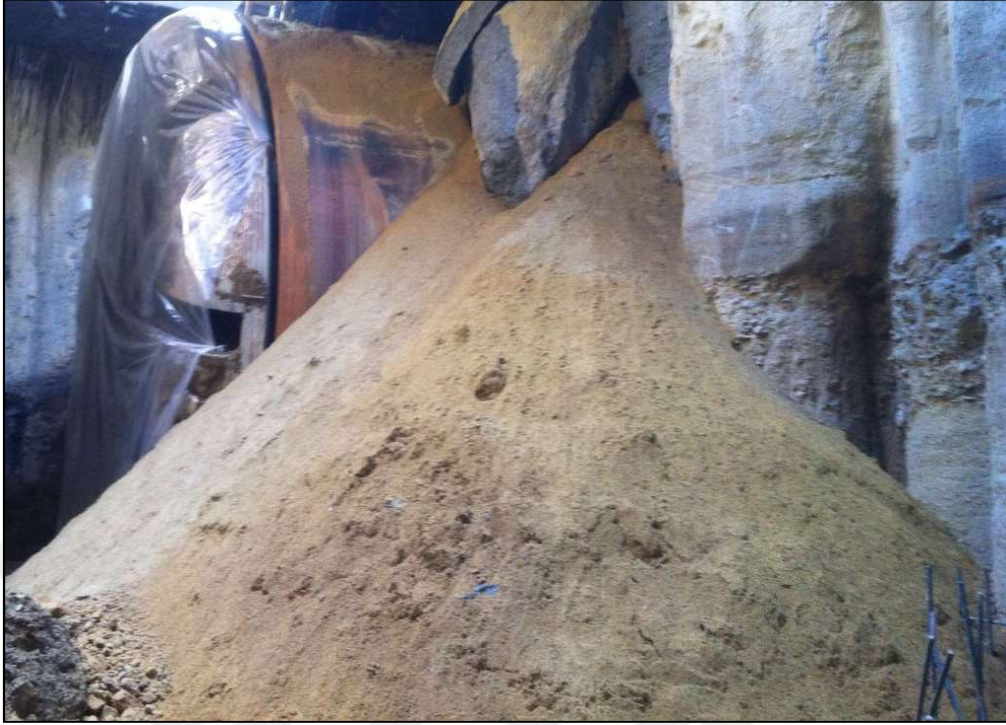
Resim 2-1: Kazım Karabekir istasyonu çıkışında (Km:14+017)gözlemlenen Çekmece formasyonunun Çukurçeşme üyesi (Siltli kum)
