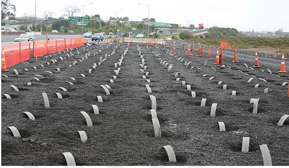
Şekil 2.5: Düşey drenler ile ıslah edilmiş saha.
