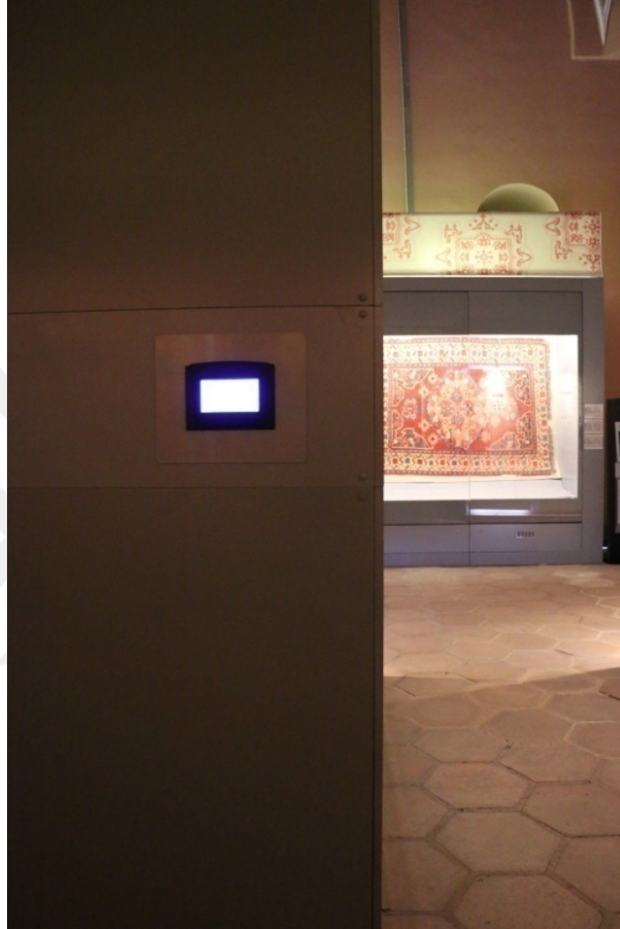
Fotoğraf 6.1 Halı Müzesi, vitrin içi nem ve sıcaklık kontrol paneli. 217
