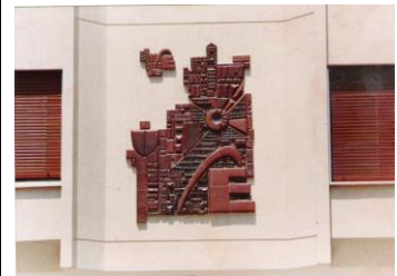
f.3 Apartman cephesi, Karşıyaka/İzmir.
