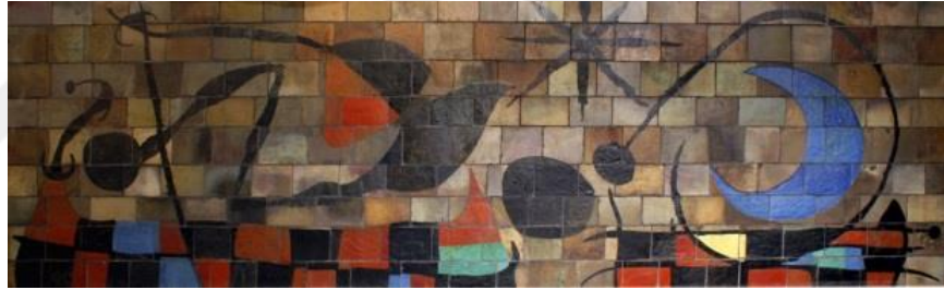
Resim 2.10. Joan Miro ve Josep Llorens Artigas'ın cephe kaplaması, UNESCO Binası, 1958.
