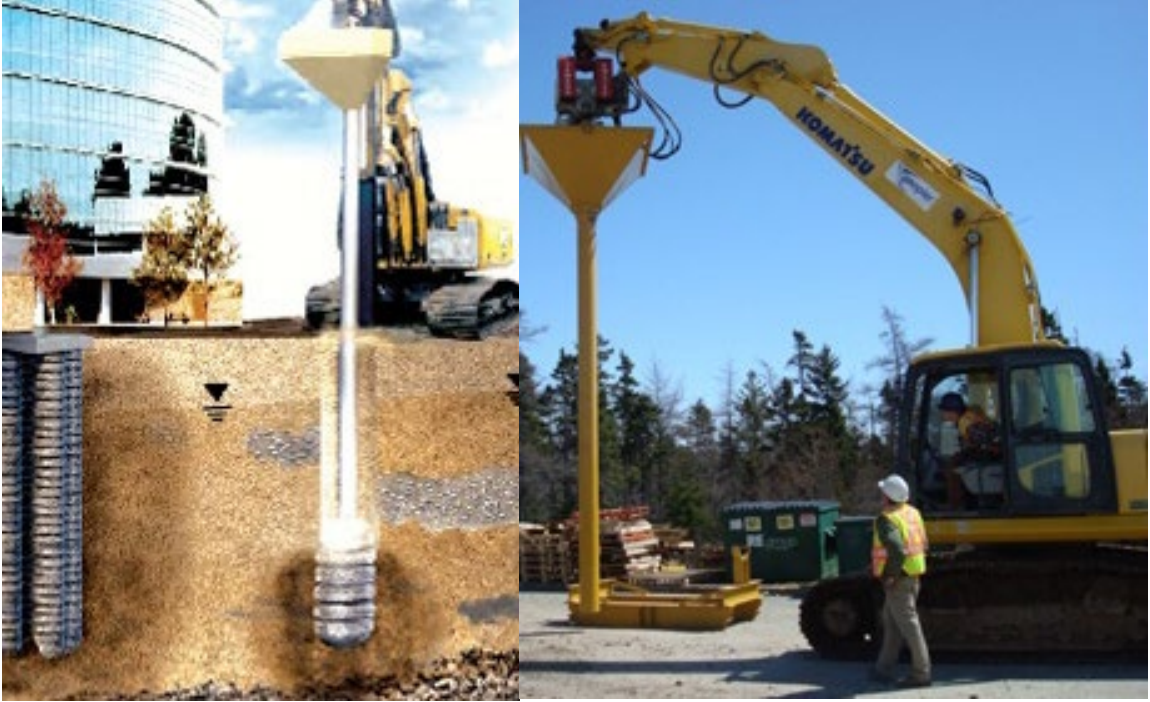
Şekil 2.33: Geopier sistemi uygulama örneği ( www.sentezinsaat.com.tr ).
