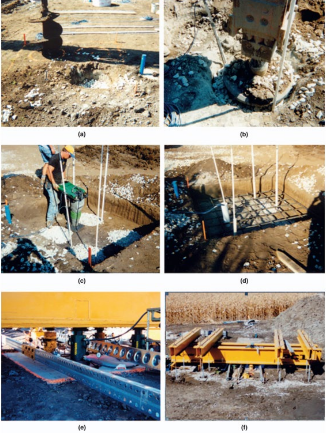
(a)Kolon boşluğunun açılması, (b)Hidrolik tokmak ve çakılın kompakte edilmesi, (c)Başlık için yüzey düzeltmesi, (d)Enstürmasyon ve çelik başlık donatısı, (e)dört adet 100 tonluk hidrolik yük tokmağı, (f)Yükleme çerçevesi
