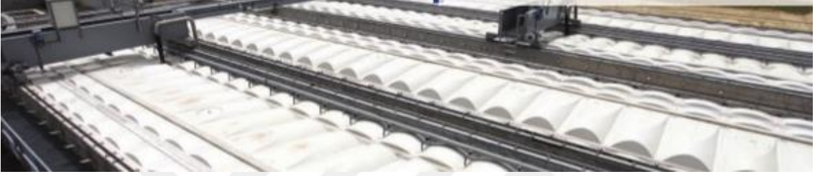
Şekil 3.2: Havalandırmalı Kum ve Yağ Tutucu.
