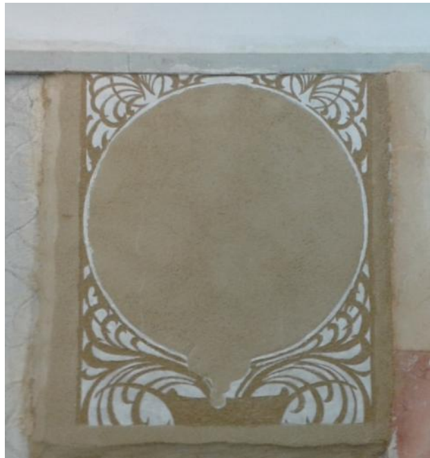
Resim 134: Tamamlanmış kazıma işlemi.
