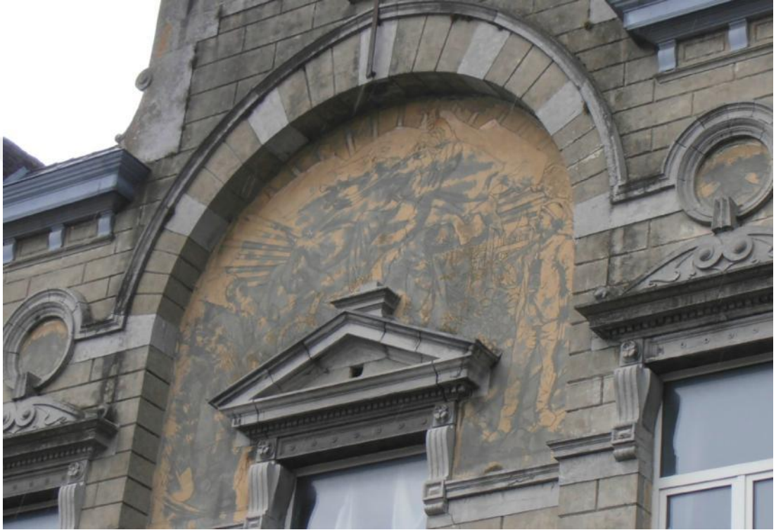
Resim 82: Colfontaine Halk Evi, 1898-1913, cephe sgraffitosu, Paul Cauchie.
