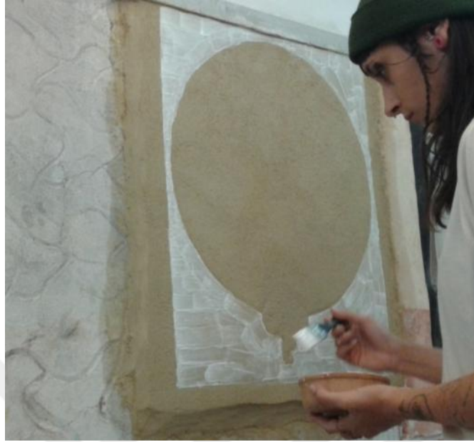
Resim 131: Kazınacak olan alana fırça ile kireç kaymağı sürülür.
