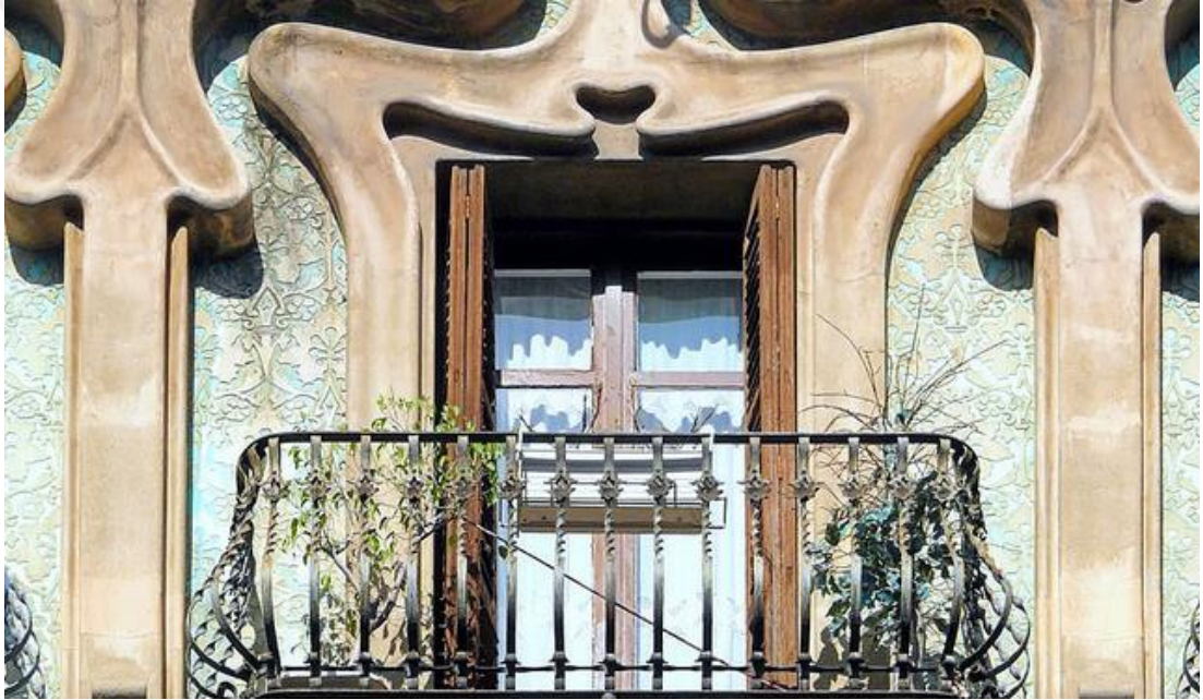
Resim 95: Duvar dokusu oluşturulan bitkisel motiflerin kullanıldığı sgraffito uygulaması.
