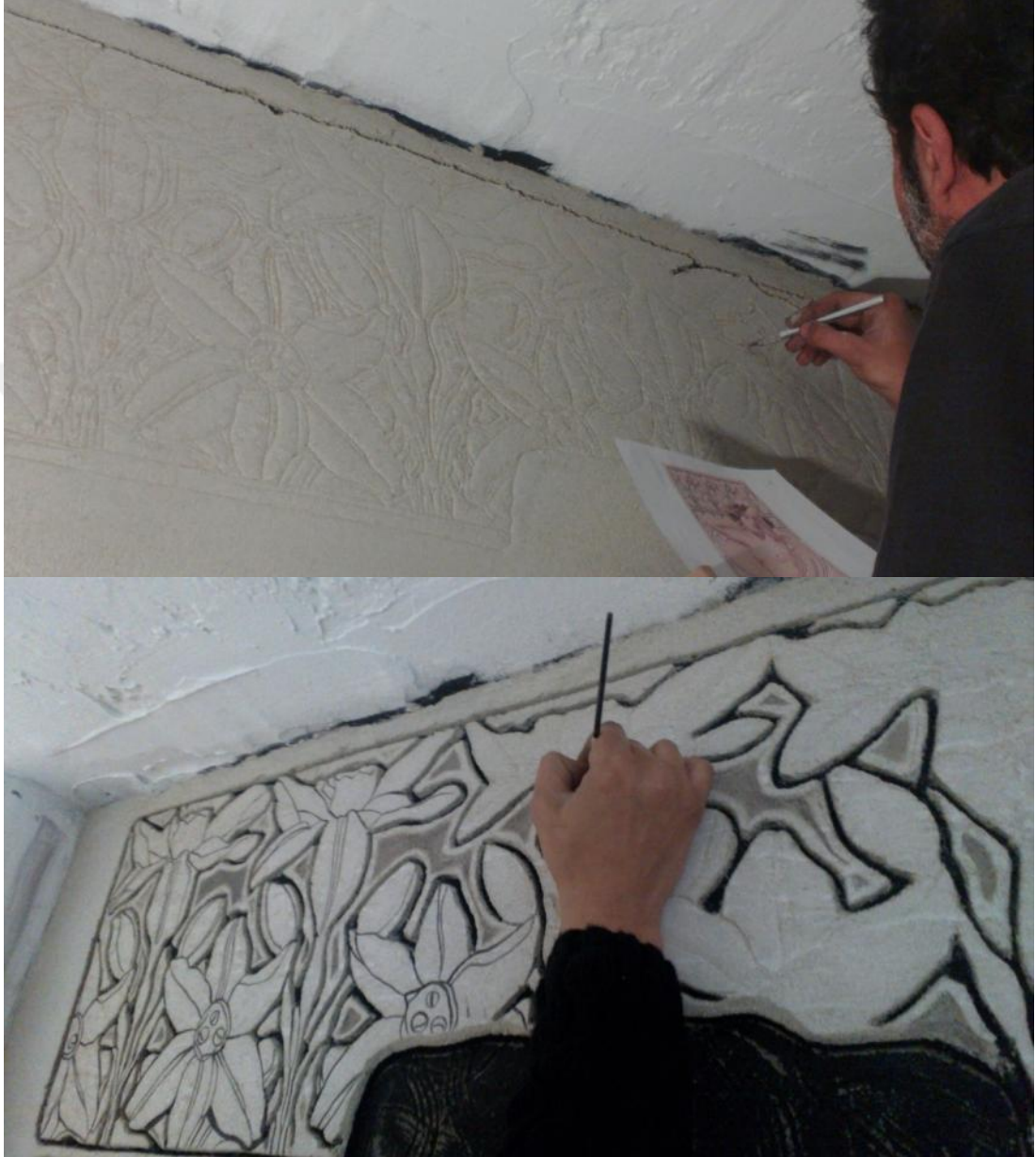
Resim 149: Desenin aktarıldığı harcın kesimi ve boyanması.
