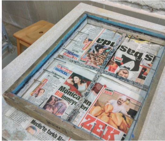
Resim 104: Çivi ve şerit tellerle şasinin hazırlanması.
