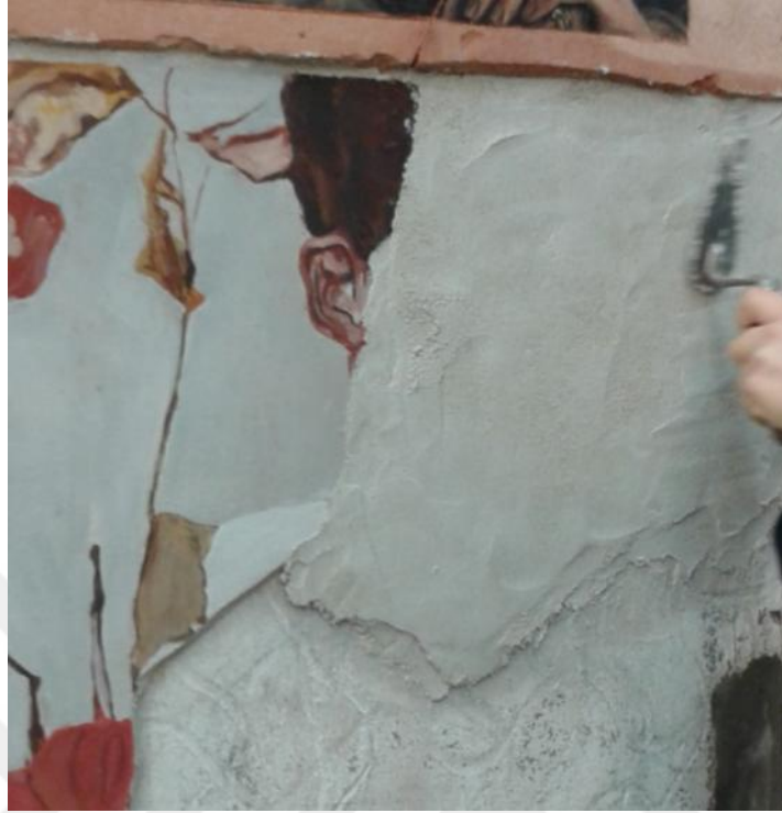
Resim 107: İntonaco katmanının yerleştirme ve yüzeyi düzgün hale getirme işlemi.
