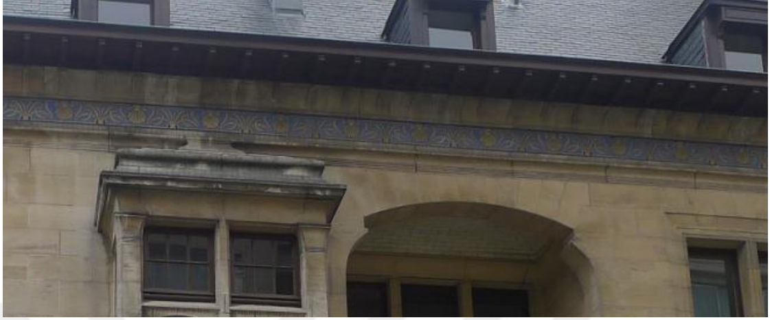
Resim 72: Otlet Evi, 1894-98, çatının hemen altında bordür olarak uygulanmış sgraffito.
