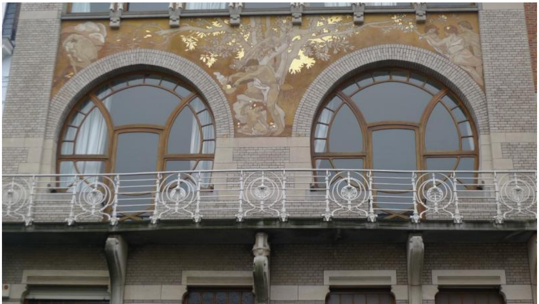
Resim 64: Ciamberlani Evi, ön cephe sgraffito duvar resminde pencereler arası boşluk değerlendirilmiş.
