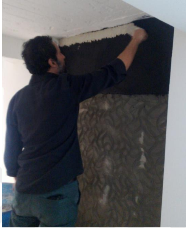
Resim 147: Siyah ve renksiz iki katman kireç harcının üst üste yerleştirilmesi.
