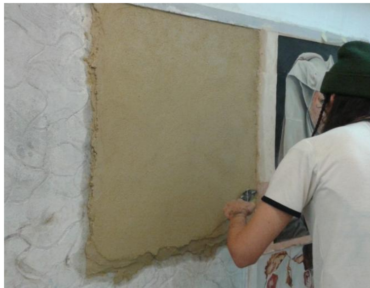
Resim 129: Kazıma ve boyama yapılacak katın duvara atılması.
