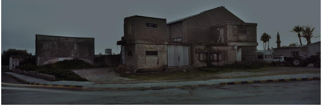
Resim 5-8 Sütluce Dünya Sineması, Sütluce, (İpsillat)
