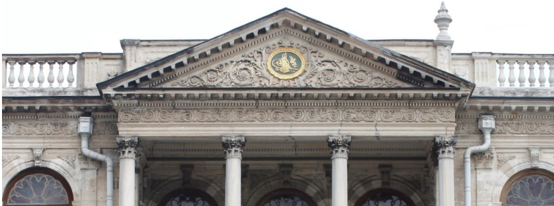
Resim 6.185. Dolmabahçe Sarayı Selamlık Bölümü giriş kapısı üçgen alınlık
