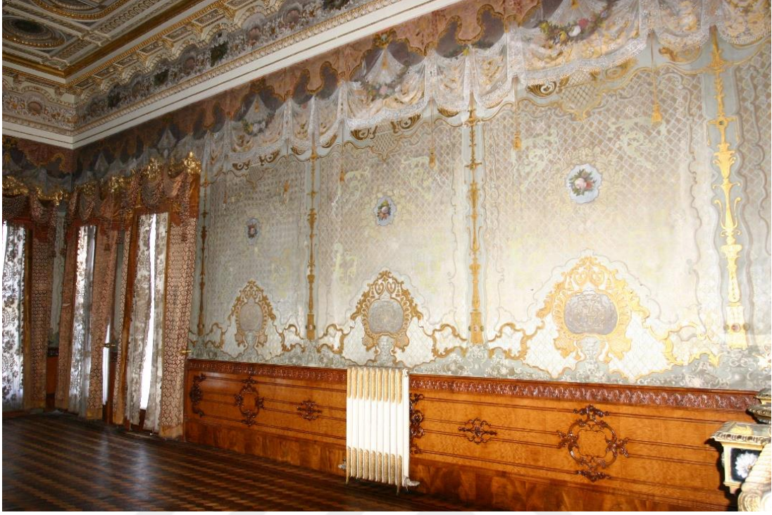
Resim 4.30. 28 numaralı oda duvar, genel görünüm
