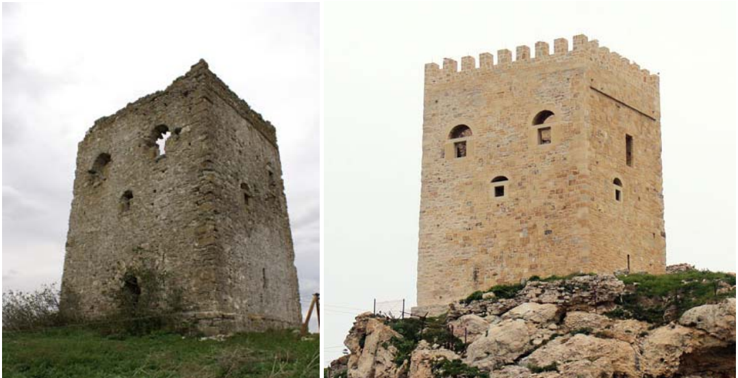
Resim 4.22 Restorasyon Öncesi ve Restorasyon Sonrası
