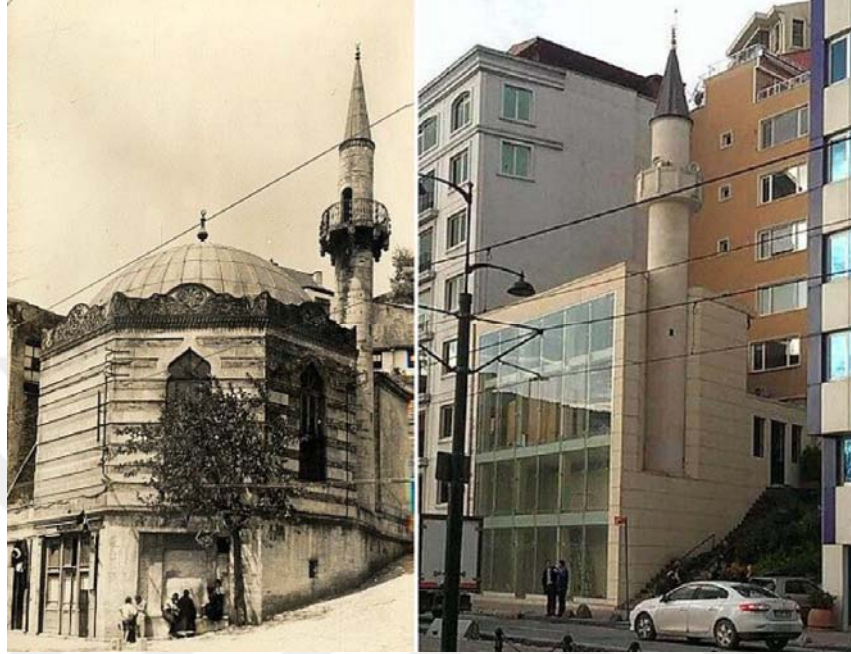
Resim 4.23: Restorasyon Öncesi ve Restorasyon Sonrası
