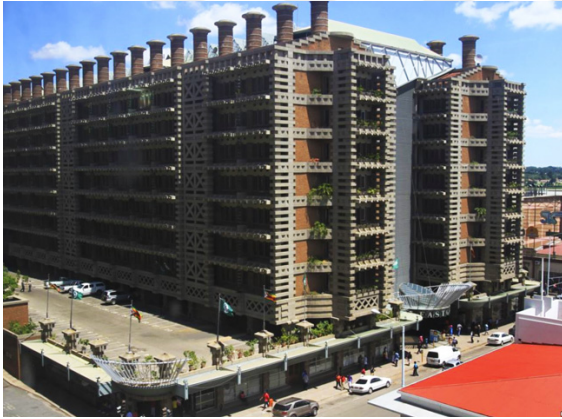
Resim 3.9 Zimbabwe'nin Harare kentinde bulunan Eastgate binasının dış cephesi
