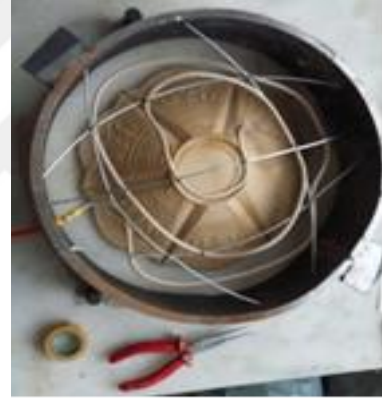
Resim 6.1.16. Hava tesisatının döşenmesi.
