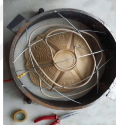
Resim 6.4.15. Hava tesisatının döşenmesi.
