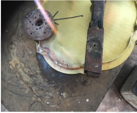
Resim 6.4.39. Kubbe tabanına monte edilmesi.
