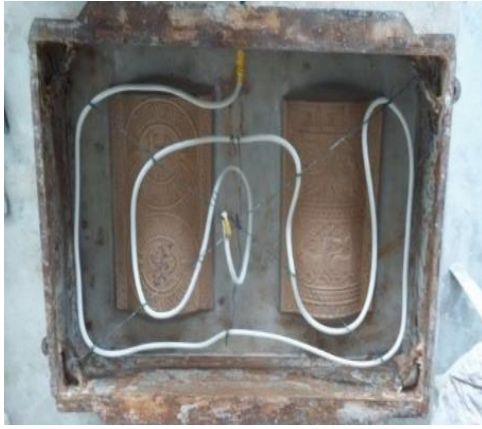
Resim 6.1.27. Model kalıba hava tesisatının döşenmesi.
