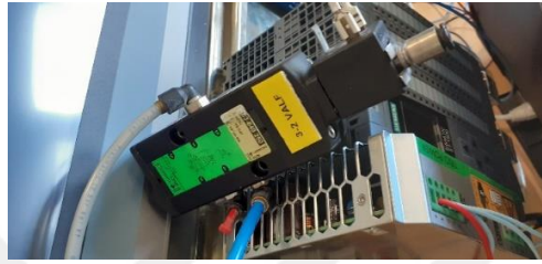
Şekil 3-18 (3-2 manyetik valf Epcb bağlantısı)
