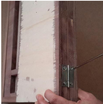
Resim 5.40: Menteşe ile panellerin yerleştirilmesi
