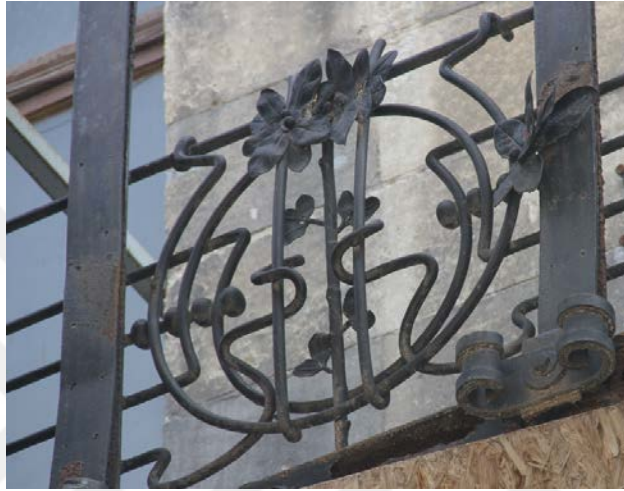
Resim 1. 27: Botter apartmanı demir balkon korkuluk detayı (Foto: Berrin Çakin Güç, 2017)
