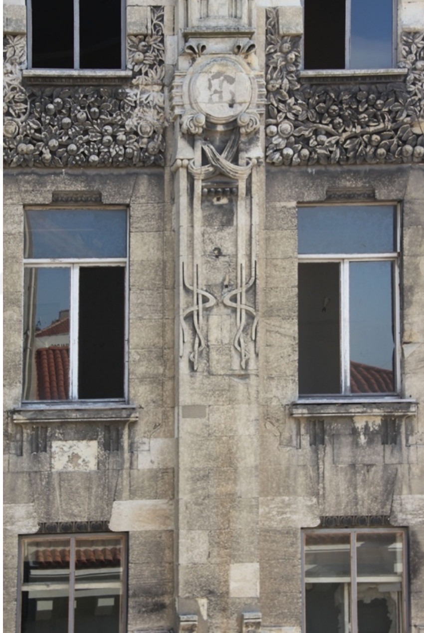
Resim 1. 36: Botter apartmanı 2. 3. kat görünüm (Foto: Berrin Çakin Güç, 2017)
