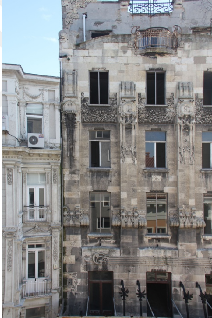
Resim 1. 33: Botter apartmanı cephe görünüş (Foto: Berrin Çakin Güç, 2017)
