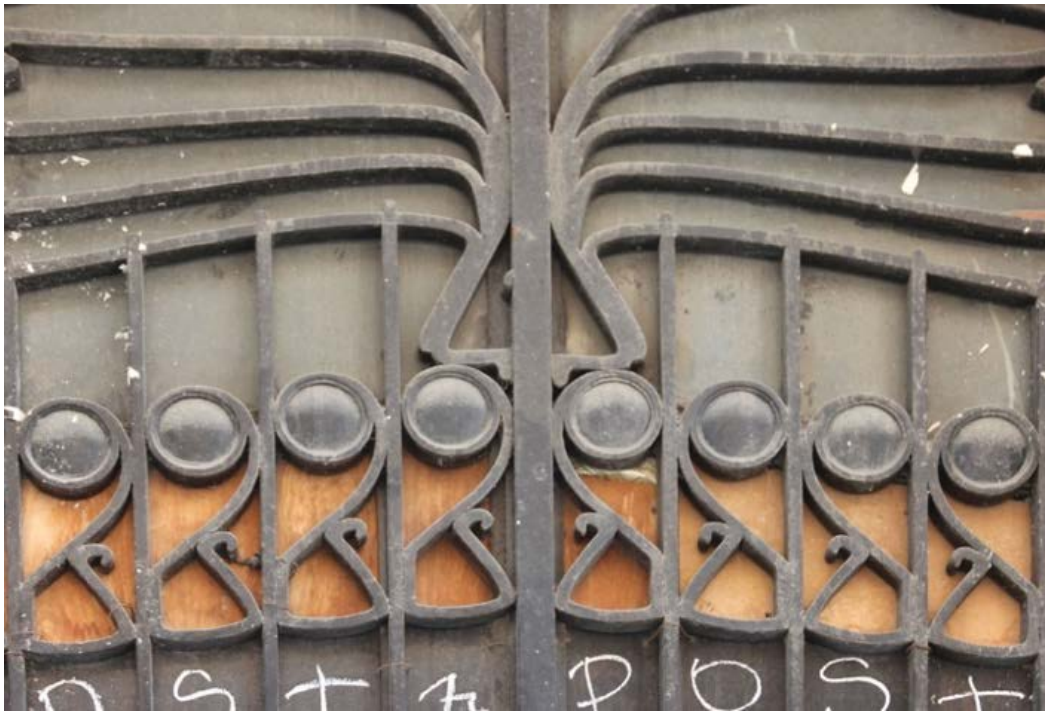
Resim 1. 15: Botter apartmanı giriş kapısı detay (Foto: Berrin Çakin Güç, 2017)
