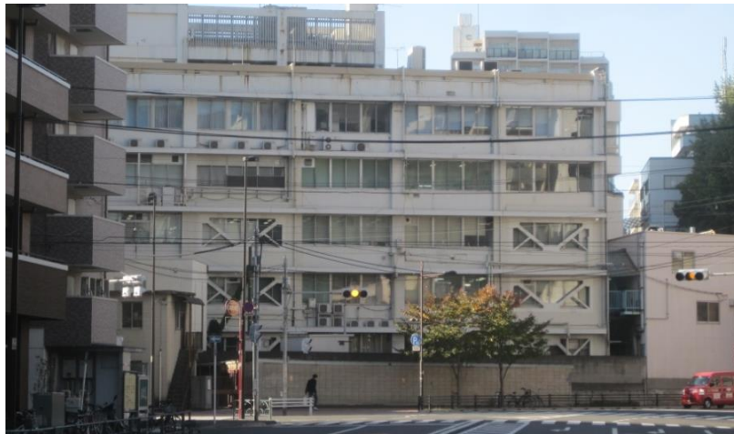
Şekil 1.18. Betonarme bir binada çelik yapı elemanları kullanılarak uygulanan deprem güçlendirmesi
