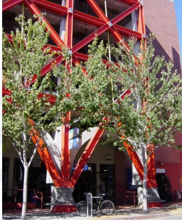
Şekil 1.19. Betonarme garaj yapısında çelik güçlendirme örneği (web iletisi 7)
