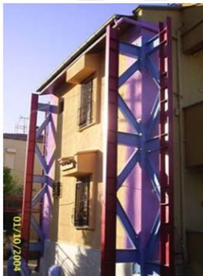
Şekil 2.6. Tama ve ark. (2005), dıştan çelik perde ile güçlendirme
