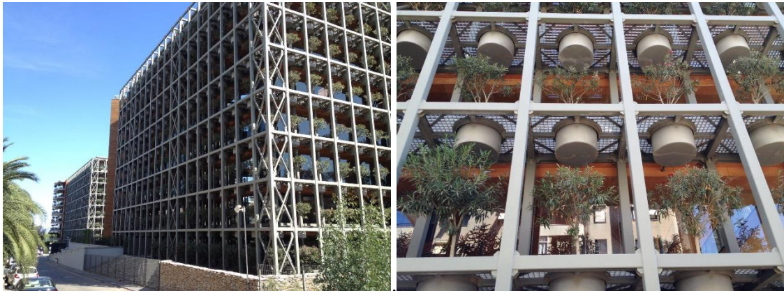
Şekil 1.28. Yapıların dış cephesinde taşıyıcı sistemin vurgulanması örnekleri – 6 (Dere, Y. 2017).
