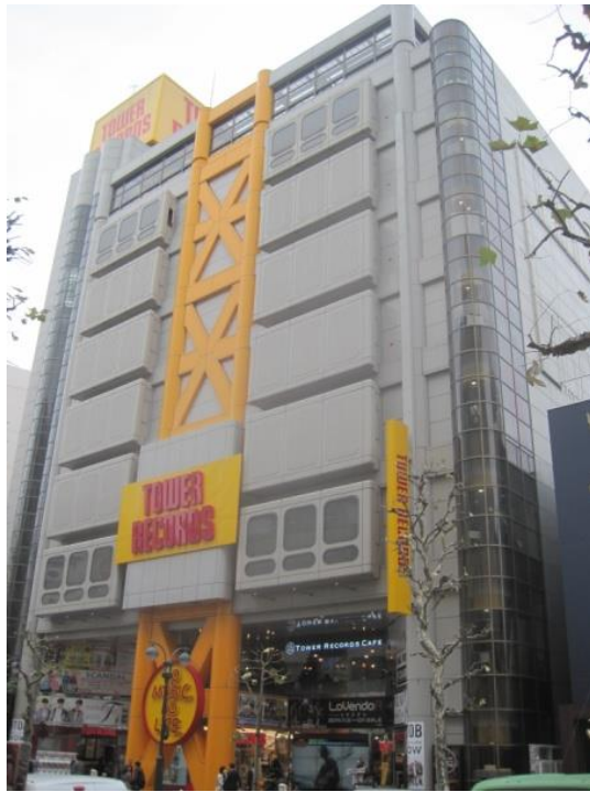
Şekil 1.16. Konsollu binada uygulanan ve yatay rijitliği artıran tasarım
