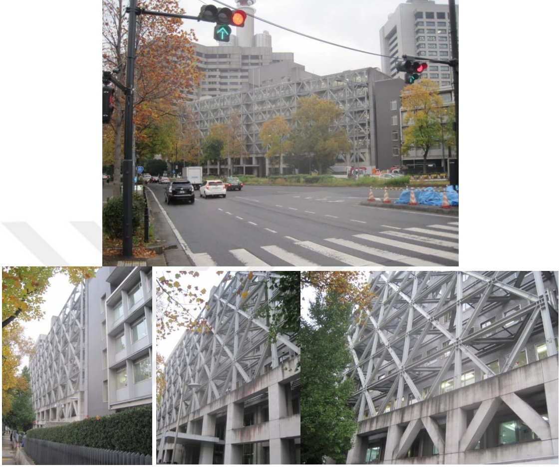
Şekil 1.22. Tokyo’da görülen güçlendirme örneği
