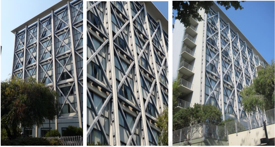
Şekil 1.20. San Francisco şehrinde betonarme yurt binasında uygulanan güçlendirme örneği
