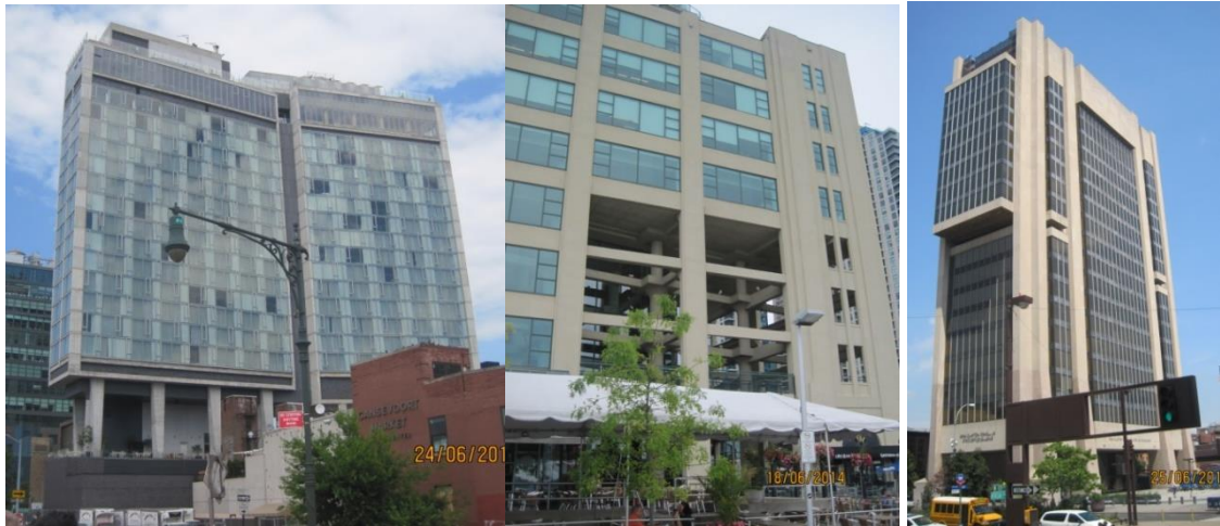
Şekil 1.7. Yapılarda deprem açısından olumsuz mimari tasarım örnekler – 1
