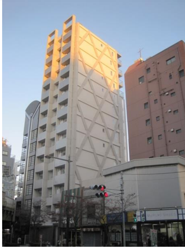
Şekil 1.30. Betonarme bir binada gözlenen diyagonal elemanlar
