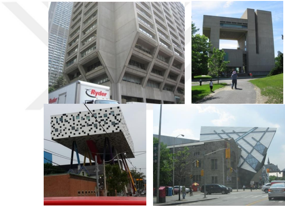
Şekil 1.9. Yapılarda deprem açısından olumsuz mimari tasarım örnekler – 3
