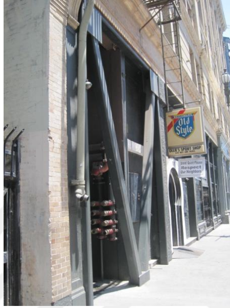
Şekil 1.17. Mevcut binada yumuşak kat için gözlenen güçlendirme
