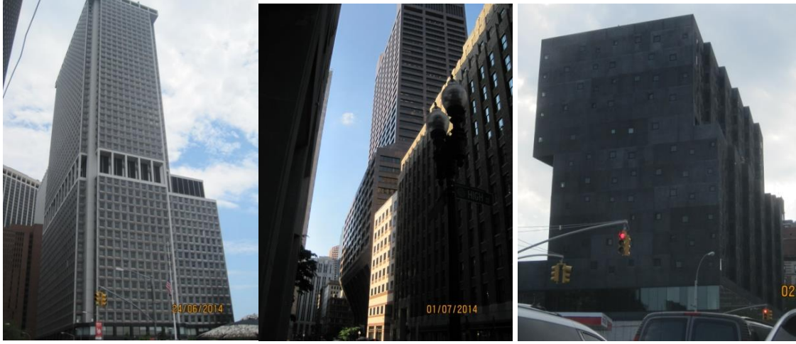
Şekil 1.8. Yapılarda deprem açısından olumsuz mimari tasarım örnekler – 2
