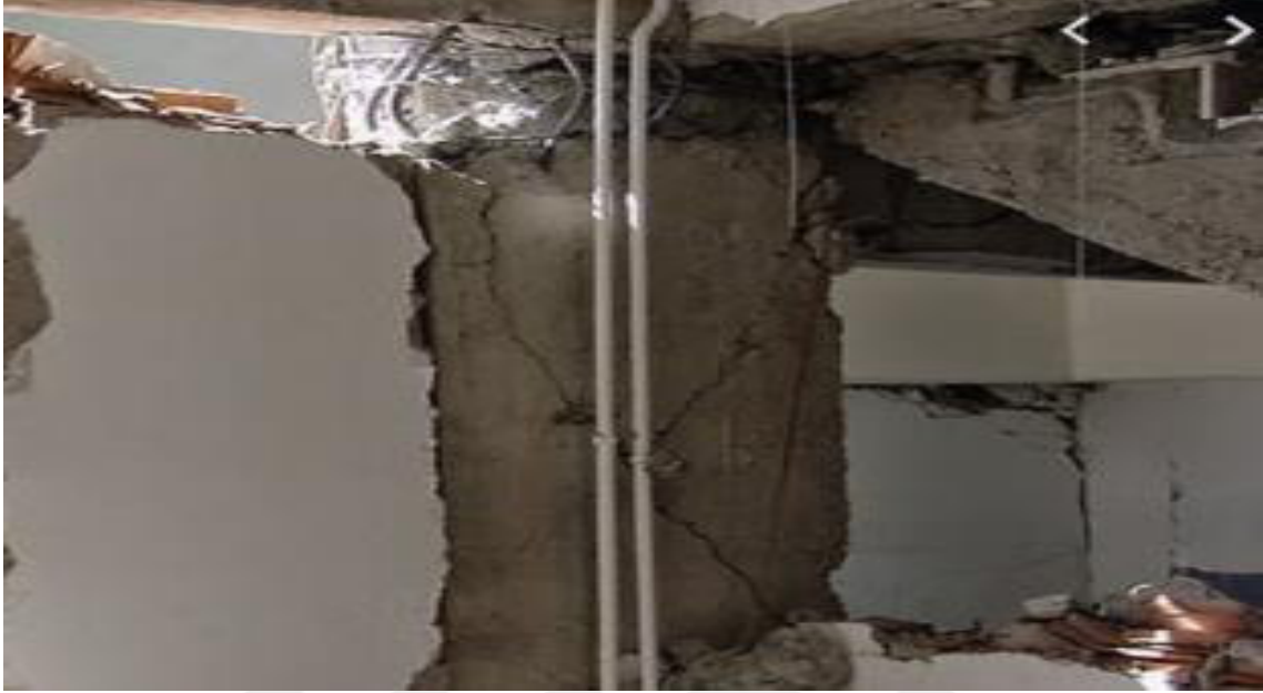
Şekil 3.4. Kolonlarda basınç hasarı
