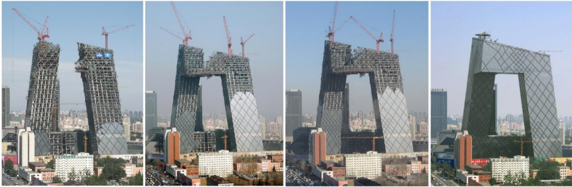
Şekil.4.25. CCTV Merkez Binası'nın yapım süreci (URL-72, 2012)
