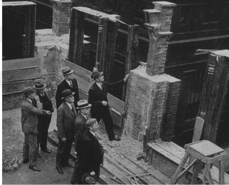
Şekil.4.7. Home Insurance Binasının 1931'deki yıkımı esnasında ortaya çıkan, taş kaplama cephesinin altındaki çelik strüktürü (Marshall, 2015)
