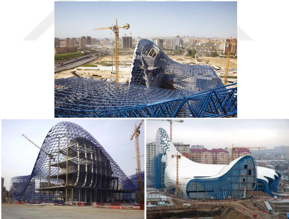
Şekil.4.27. Çelik uzay kafes sistemli yapı kabuğunun oluşturulması (URL-75, 2019; URL-77, 2019)
