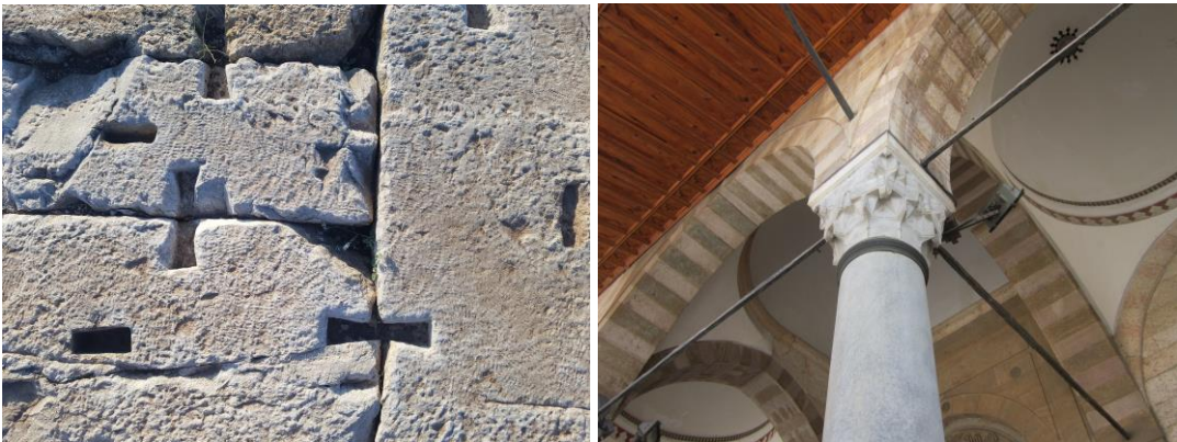
Şekil.3.1.a ve Şekil.3.1.b. Manisa Sardes Antik Kenti'nde demir kenet yuvaları ve Konya Şerafettin Camii'de demir gergi çubuklarının kullanımı (Yelda Korkmaz Kişisel Arşiv, 2019 ve 2013)
