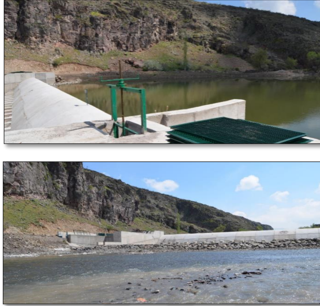
Şekil 4.13. Kırmır çayı üzerinde yer alan sulama barajı (Anonim, 2019h)
