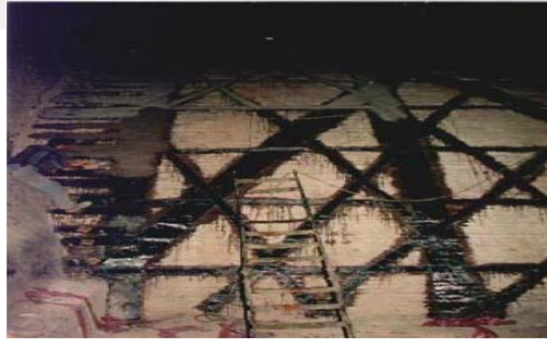
Şekil 1.7. Yığma kemerde CFRP uygulaması (Öncü, 2011)
