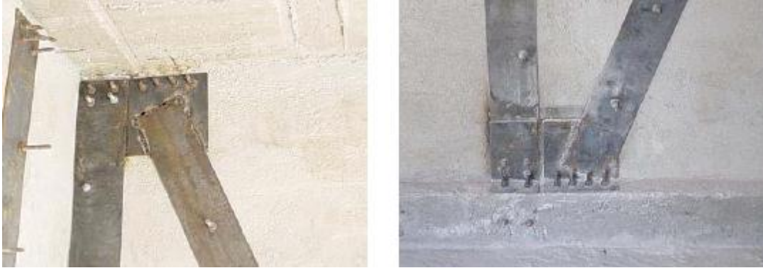
Şekil 2.10. Bağlantı detayları(Altın ve ark., 2005)
