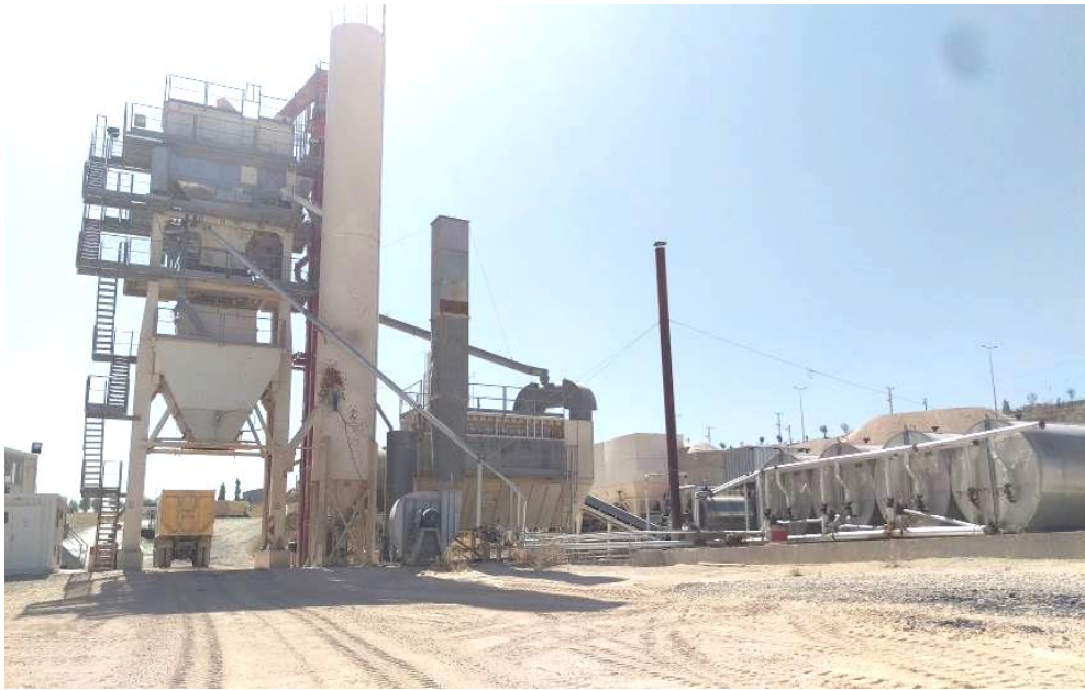
Şekil 3.17. Haymana asfalt plent tesisi
