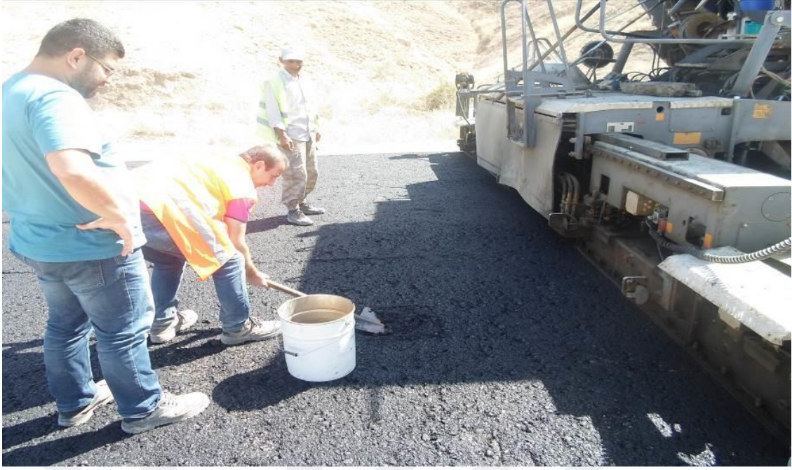
Şekil 4.7. Ankara-Haymana yolu bitümlü alt temel kaplamasından numune alım işlemi
