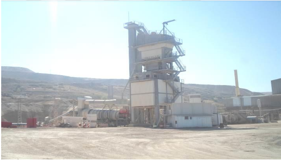
Şekil.3.15. Yakupabtal ocak asfalt planti
