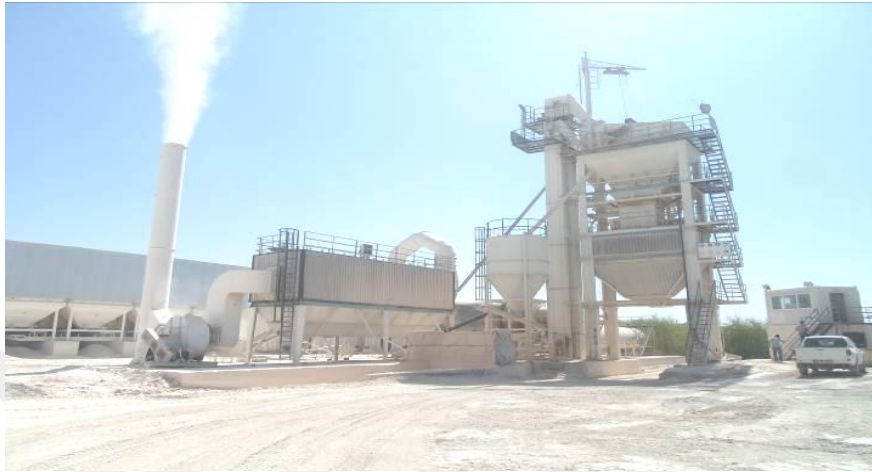
Şekil 3.21. Polatlı asfalt plant tesisi
