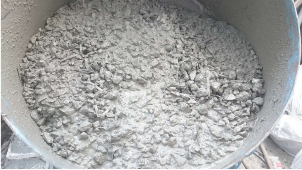
Şekil 3.13. Atık teneke katkılı beton karışımının hazırlanışı
